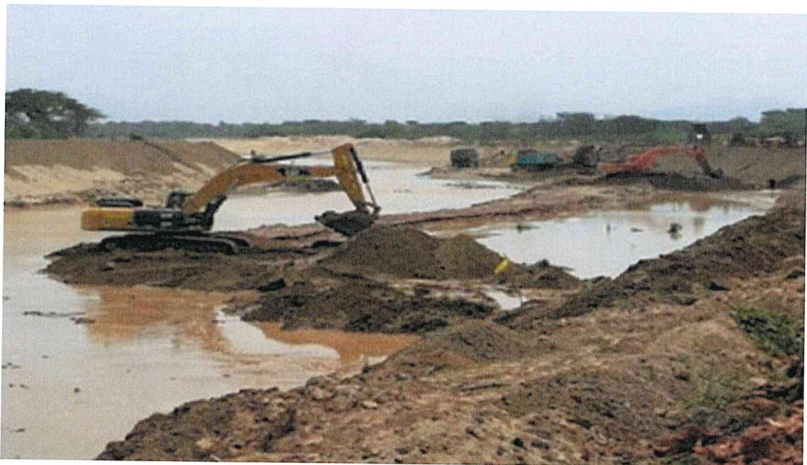
Descolmatación de cauce de río
