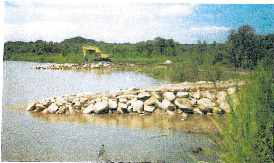
Imagen N° 5 Protección con espigones de roca
