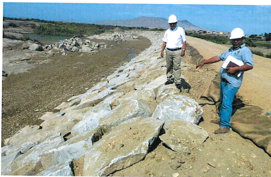
Imagen 01: Protección - dique enrocado acomodado
