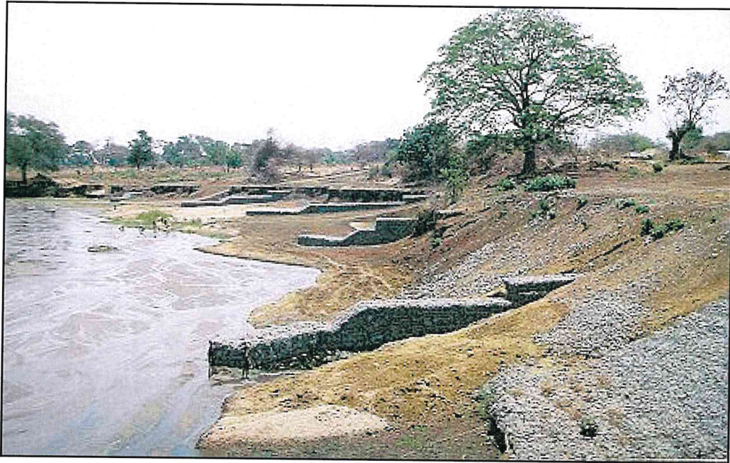
Imagen N°4 Protección con espigones de gaviones
