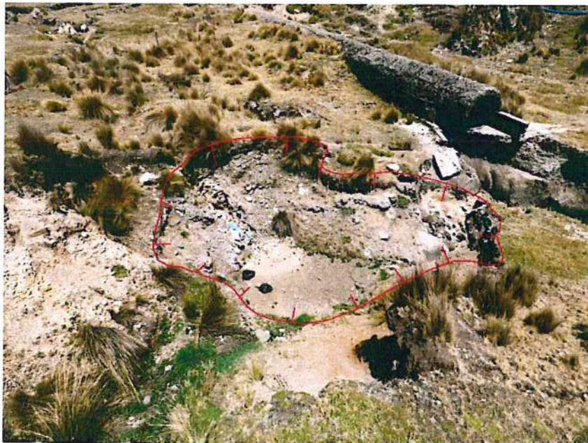
Figura 18: Vista con dirección al suroeste, se aprecia otra vista del hundimiento H1 (línea color rojo).
