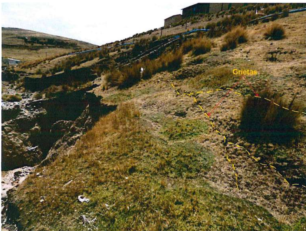
Figura 25: Vista con dirección al norte donde se puede observar los agrietamientos en el borde del hundimiento H3.
