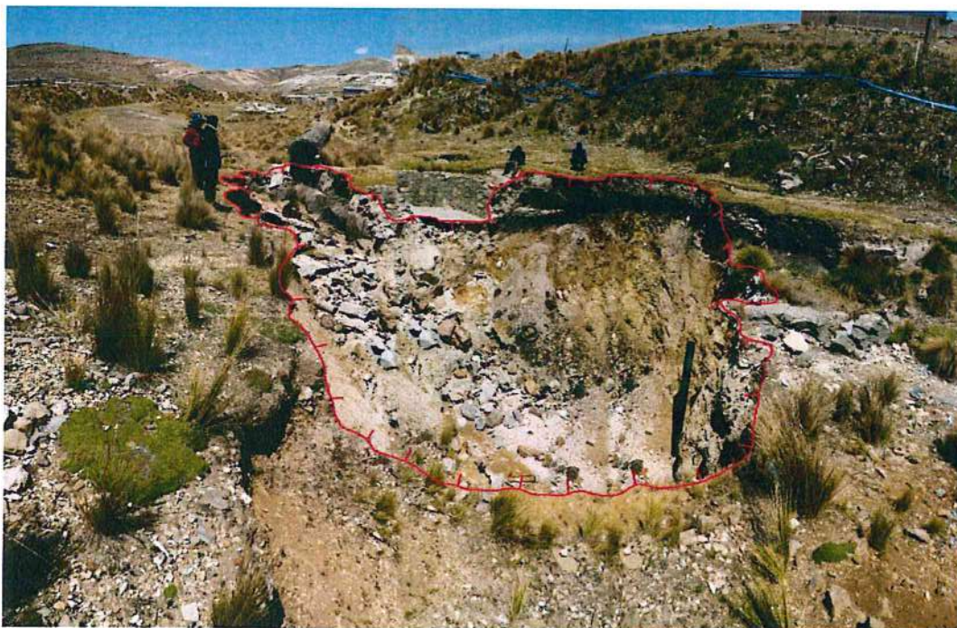
Figura 21: Vista con dirección al sur, se puede ver el cauce de la quebrada Chontacancha y el hundimiento H3 (línea color rojo) producido en el mismo cauce.
