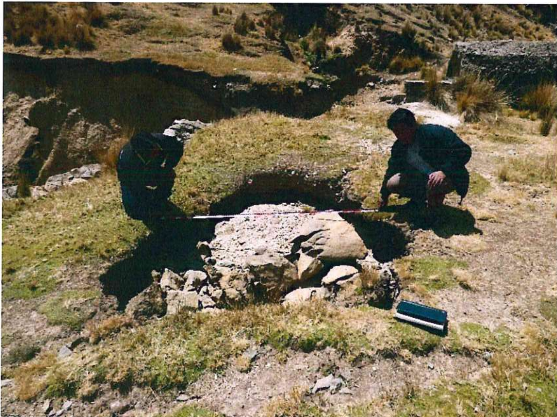
Fotografía 3: Vista con dirección al sureste donde se puede observar el hundimiento H2, localizado a solo 1.5 m del último hundimiento.
