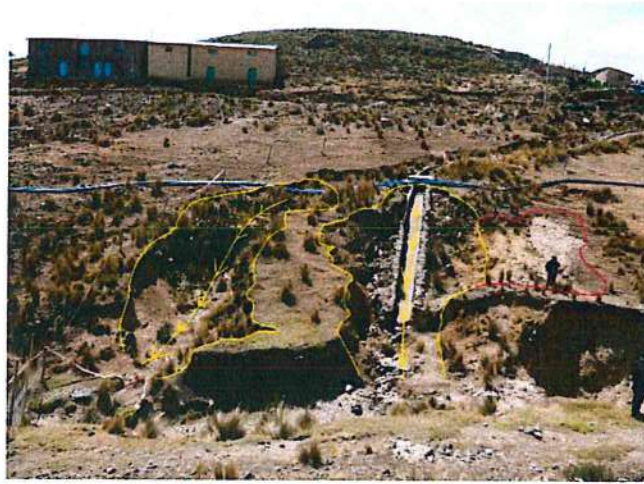
Figura 14: Vista con dirección al este se observa laderas de la margen derecha de la quebrada Chontacancha afectada por cárcavas (línea color amarillo) y erosión laminar (línea color rojo).
