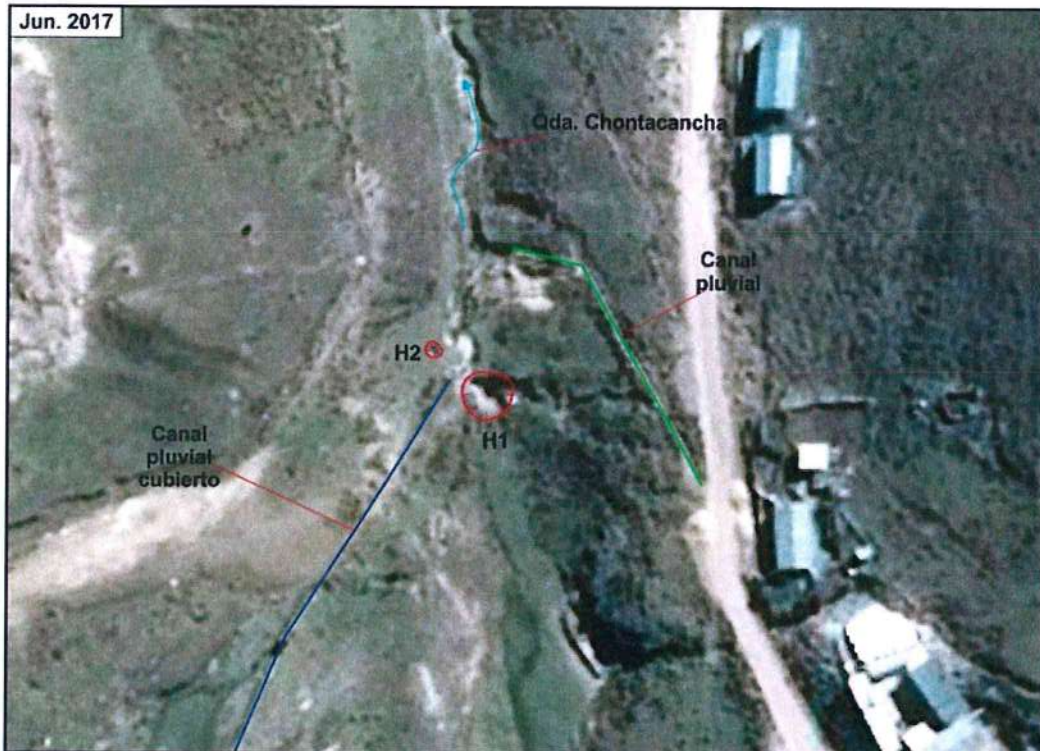
Figura 19: Imagen Google Earth (junio, 2017) se puede observar el hundimiento H2.
