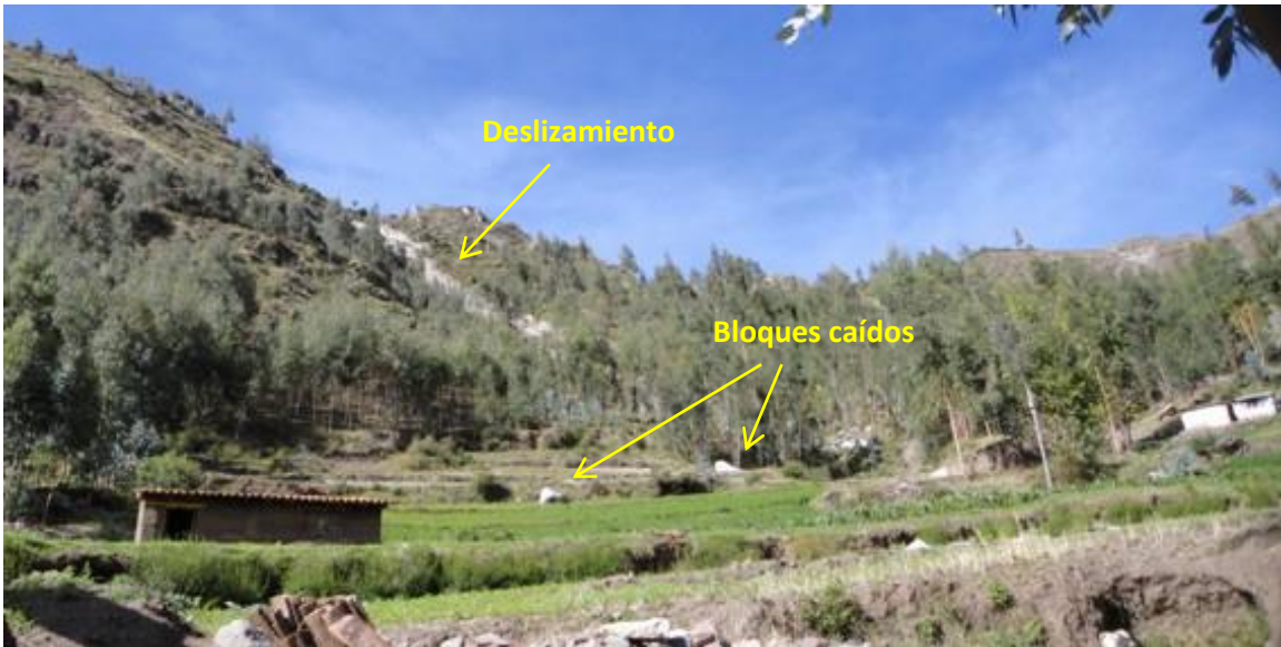
Fotos 17: Vista ladera arriba, donde se puede apreciar la ubicación final de los bloques caídos con respecto a las viviendas de Cachi Baja.
