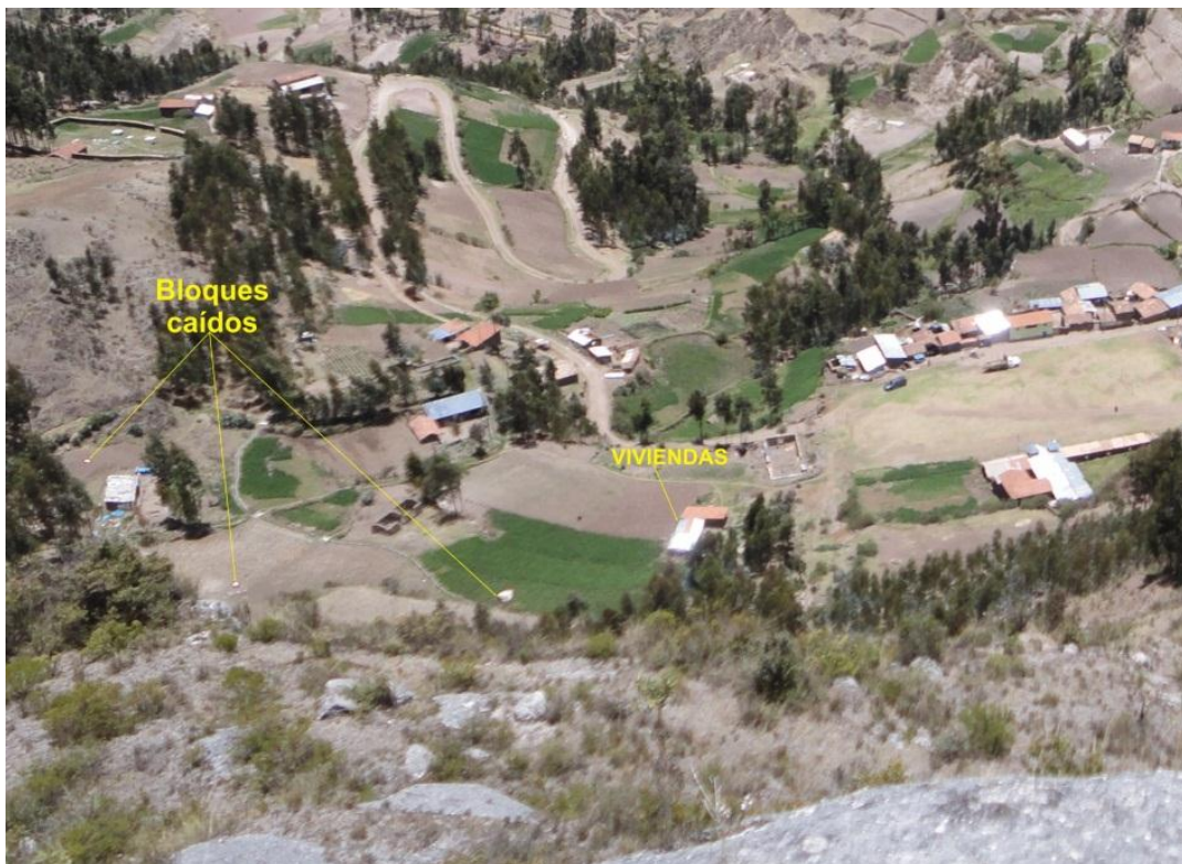
Foto 16: Vista ladera abajo, donde se ha localizado y señalado con flechas amarillas la ubicación final de los bloques caídos que alcanzaron mayor desplazamiento.
