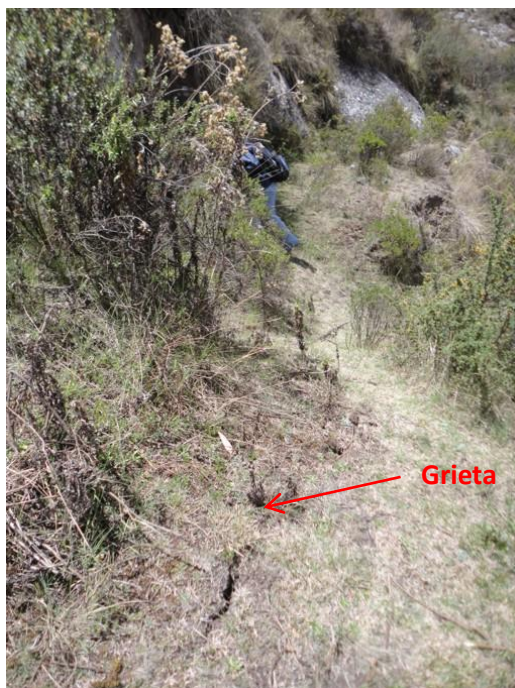
Foto 12: Grietas abiertas localizadas por encima de la corona del deslizamiento.
