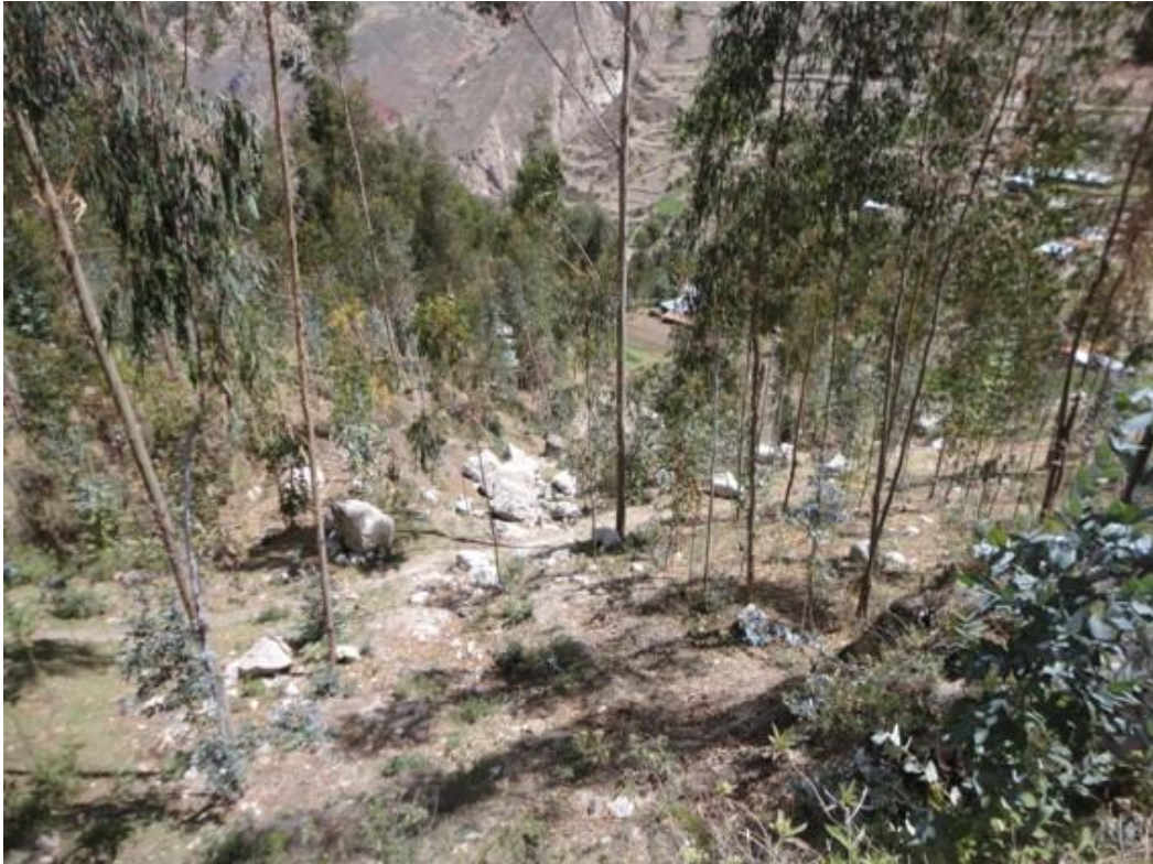
Foto 15: Vista ladera abajo donde se puede apreciar varios bloques caídos que alcanzaron distancias mayores que el material desplazado por el deslizamiento.
