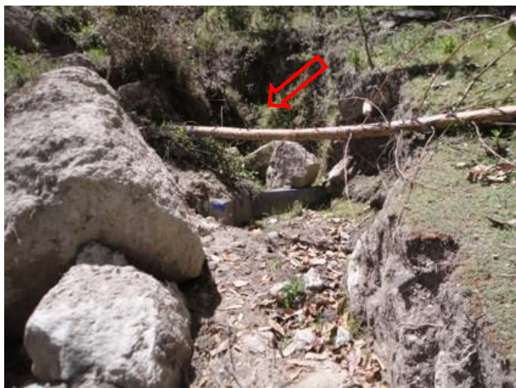
Foto 7: Afloramiento de agua captado (puquial), localizado al lado izquierdo del deslizamiento. Se ha señalado con flecha roja.
