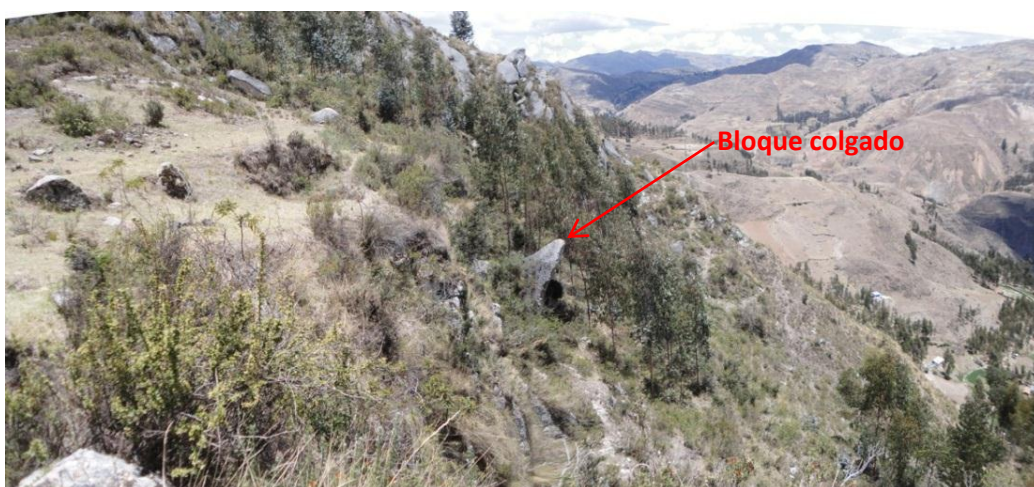
Foto 22: Bloque de roca ignimbrita, desprendido desde el talud, el cual quedó colgado o suspendido.
