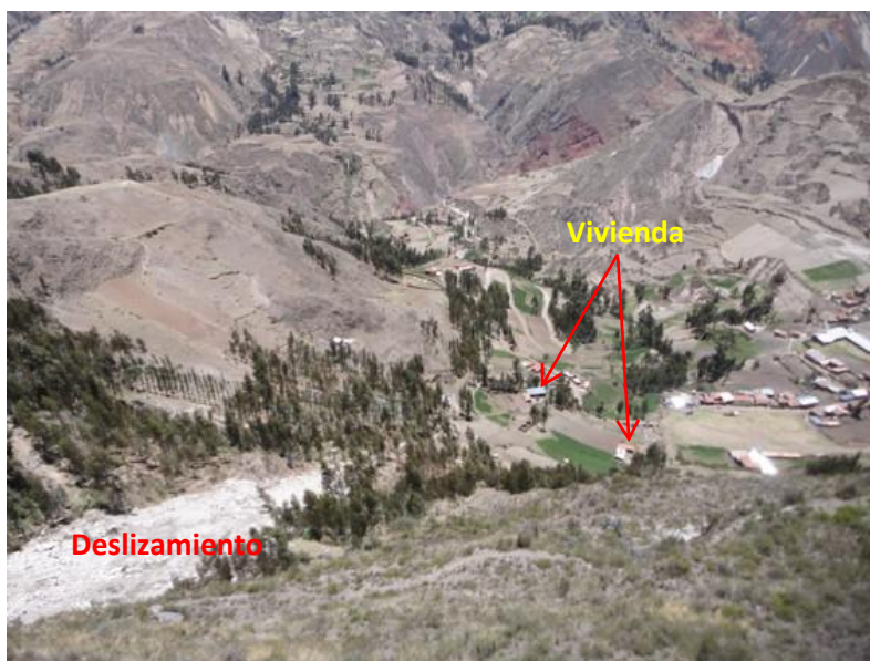
Foto 13: Terrenos de cultivo y viviendas localizados debajo del deslizamiento.
