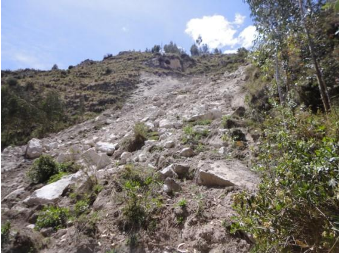
Foto 10: Otra vista del deslizamiento, se observa gran cantidad de bloques en la parte superior del depósito.
