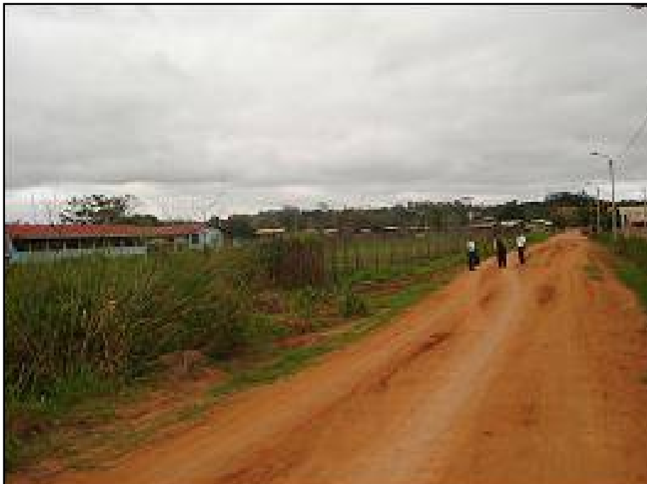
Foto N° 10. Av. León Velarde (Vista hacia el sur). Se observa la carencia de estructuras de drenaje superficial, así como, protección contra inundación por desborde del río Acre.
