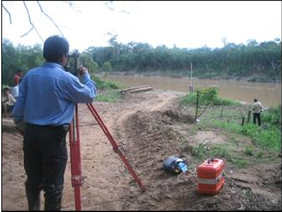
Foto N° 03. Puerto Callao (Río Acre). Trabajos topográficos para determinar la gradiente hidráulica del Río Acre.
