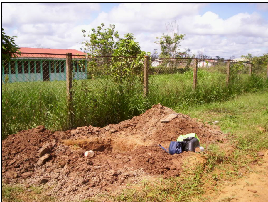
Foto N° 12. Vista general de la calicata C4 ubicada a lo largo de la Av. León Velarde y al frente del Colegio Secundario de Iñapari.
