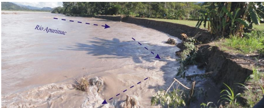
Foto 53. Sivia, sector actualmente erosionado por el río Apurímac.
