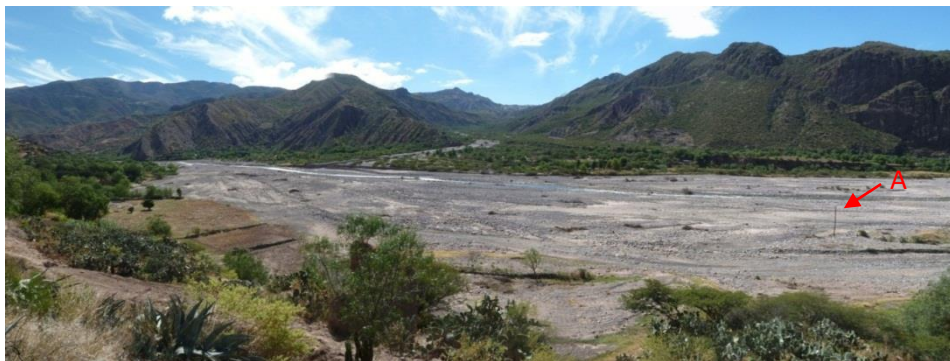
Foto 11: Vista de la quebrada Chincho en confluencia con el río Cachi, la migración de este último dejó los postes de transmisión eléctrica (A) dentro del cauce.
