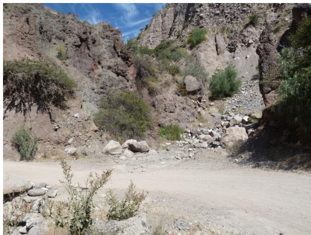
Foto 9: Flujo de detritos que corta tramo de la carretera que conduce a Julcamarca y Lircay.
