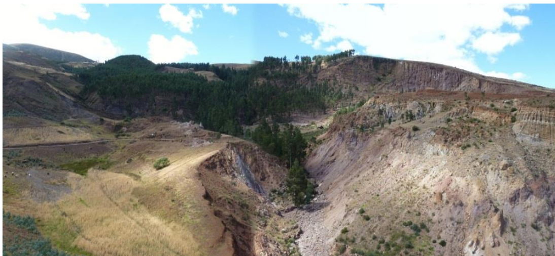
Foto 13: Vista aguas arriba donde se puede observar la escarpa del deslizamiento en ambas márgenes de la quebrada Pamparque.
