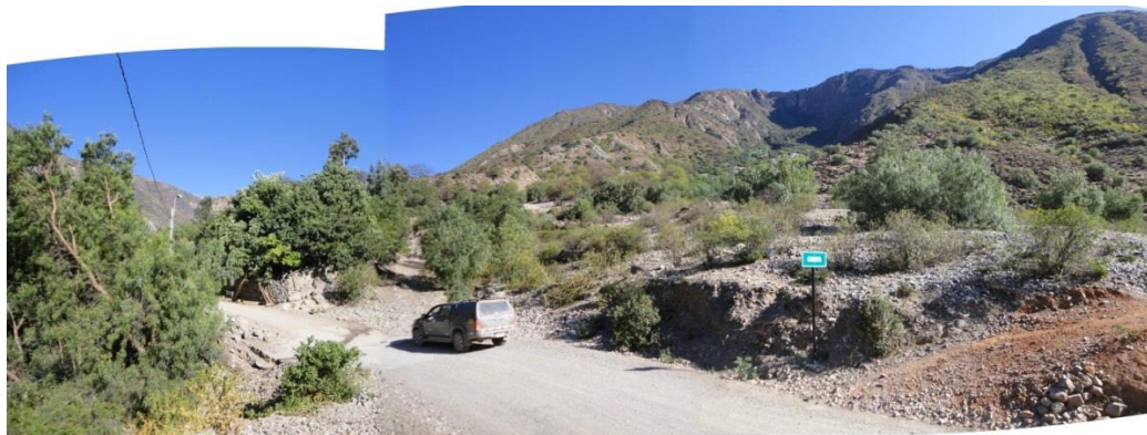
Foto 45: Derrumbe-flujo de detritos afecta tramo de carretera y viviendas en el sector de Chonta.
