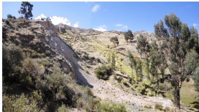
Foto 47: Vista de perfil de deslizamiento traslacional en el sector de Jivicha, produce asentamiento de terrenos de cultivo.
