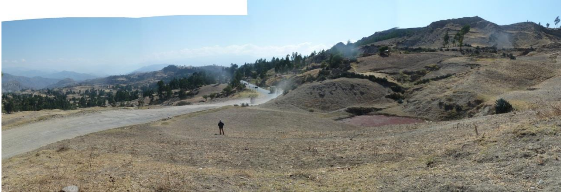
Foto 4. Vista deslizamiento rotacional en el Km.322+300 Libertadores Pisco- Ayacucho, Sector Chachococha, se puede observar la formación de una laguna en la concavidad dejada por el vasculamiento del cuerpo del deslizamiento, irregularidades en el terreno y pérdida de asfalto en carretera.
