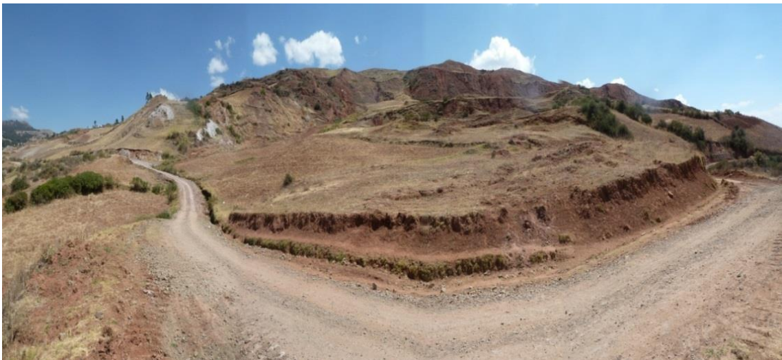
Foto 17: Deslizamiento en el sector de Pucaloma, compromete capas rojas, afecta tramo de carretera Socos-Luyanta.
