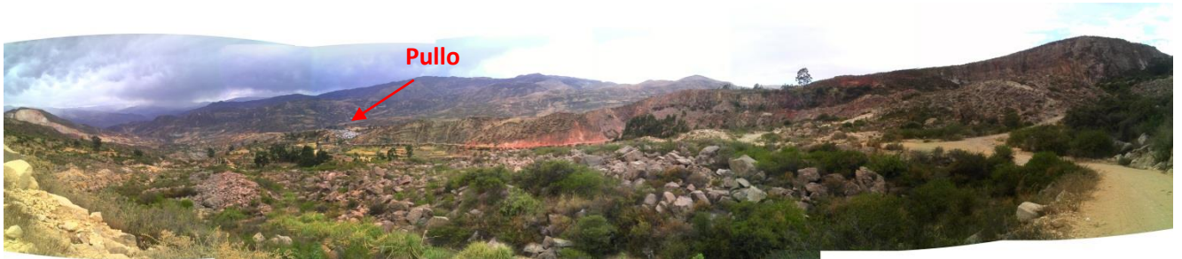
Foto 34: Deslizamiento de Pullo produce asentamientos en la plataforma de carretera afirmada, el terreno continúa moviéndose ladera abajo.
