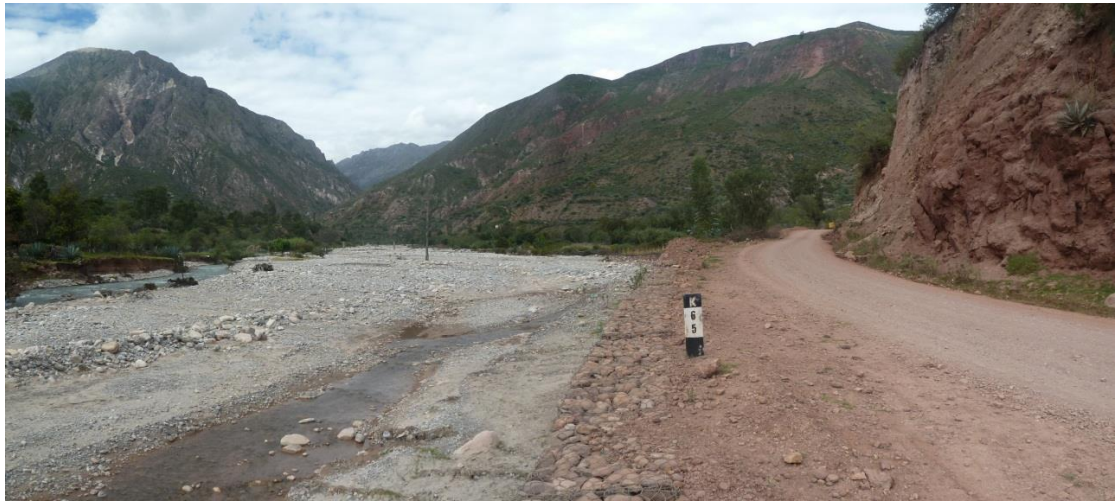
Foto 24: Km 65 de la carretera Cangallo-Huancapi, sector Tío Cucho protegido con gaviones, se produce erosión fluvial de la plataforma de carretera e inundaciones.
