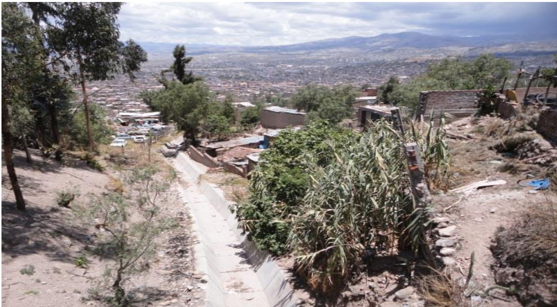
Foto 19: Torrentera canalizadas en la parte alta de la ciudad de Huamanga, que permite que los huaycos discurran.
