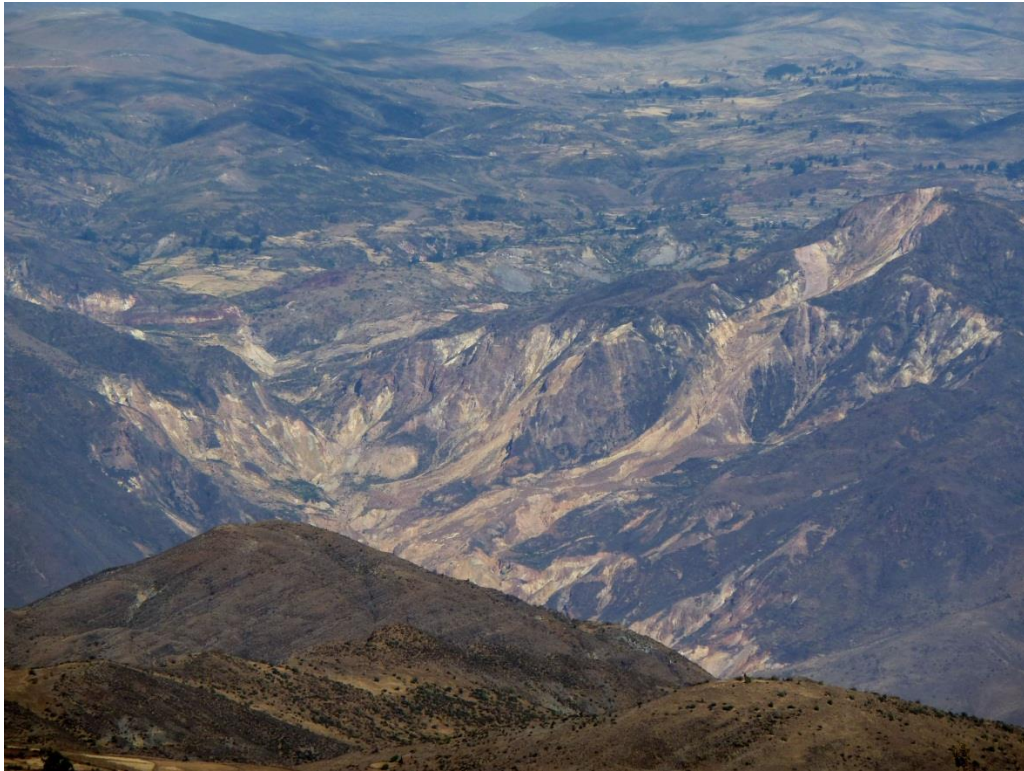
Foto 31: Deslizamiento flujo en el lado norte del cerro Sallachipa, los materiales se encausaron por la quebrada y llegaron hasta el río Sangarará.
