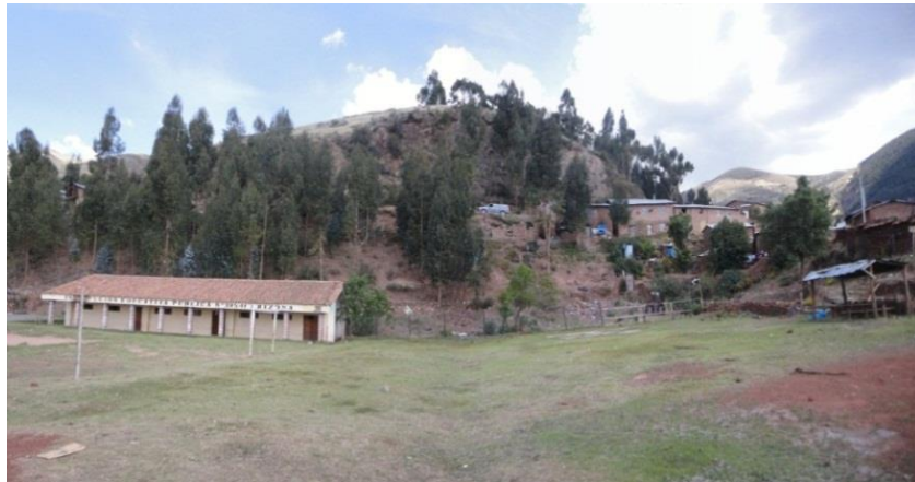
Foto 1: Se observan irregularidades en el terreno causados por el desplazamiento del suelo en el Sector Arizona- Km.293 de la Carretera Libertadores Wari.
