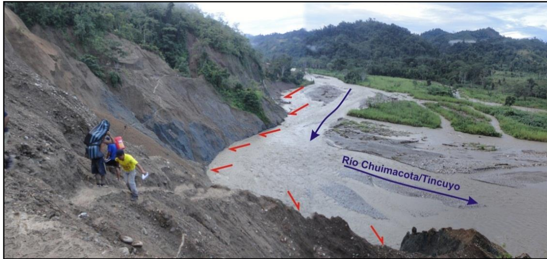
Foto 58: Llochegua; Derrumbe del sector de Barranca, afectó carretera Llochegua-Chihullo, se muestra el área inestable. Las flechas de color rojo indican el sentido de la erosión del río, las de color azul el sentido de corriente del río.
