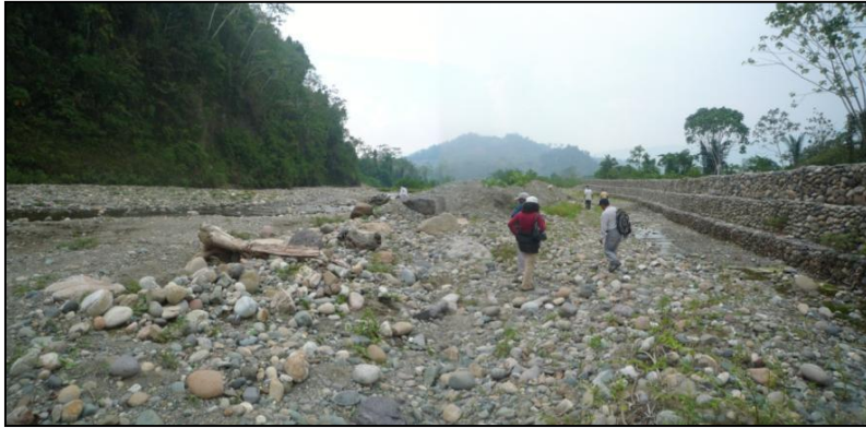
Foto 51: Gavión ubicado en la margen derecha del río Mayapo.
