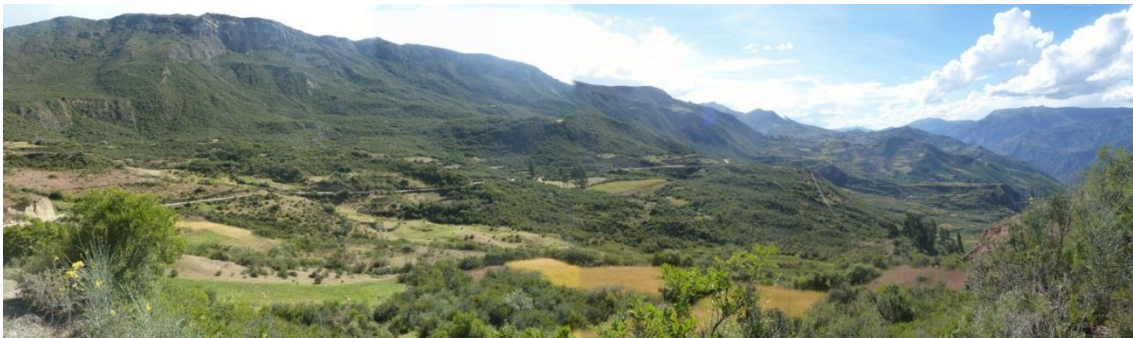
Foto 26: Deslizamiento Rotacional en Carretera Tiquihua- Canaria (Cerro Patacancha), km 43+700. Se muestra escarpa antigua.
