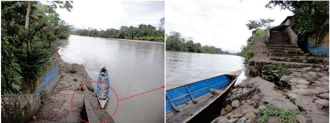
Foto 47: Erosión fluvial en la margen izquierda del río Iscozacín, Puerto Iscozacín. Hace 10 años el río se desbordó hasta la carretera afectando a las viviendas del Puerto. En el año 97 el nivel del agua subió 1 m de alto sobre el nivel de la carretera, por represamiento con el río Palcazú. Como producto de la erosión fluvial ha destruido la defensa ribereña reforzada con gaviones.
