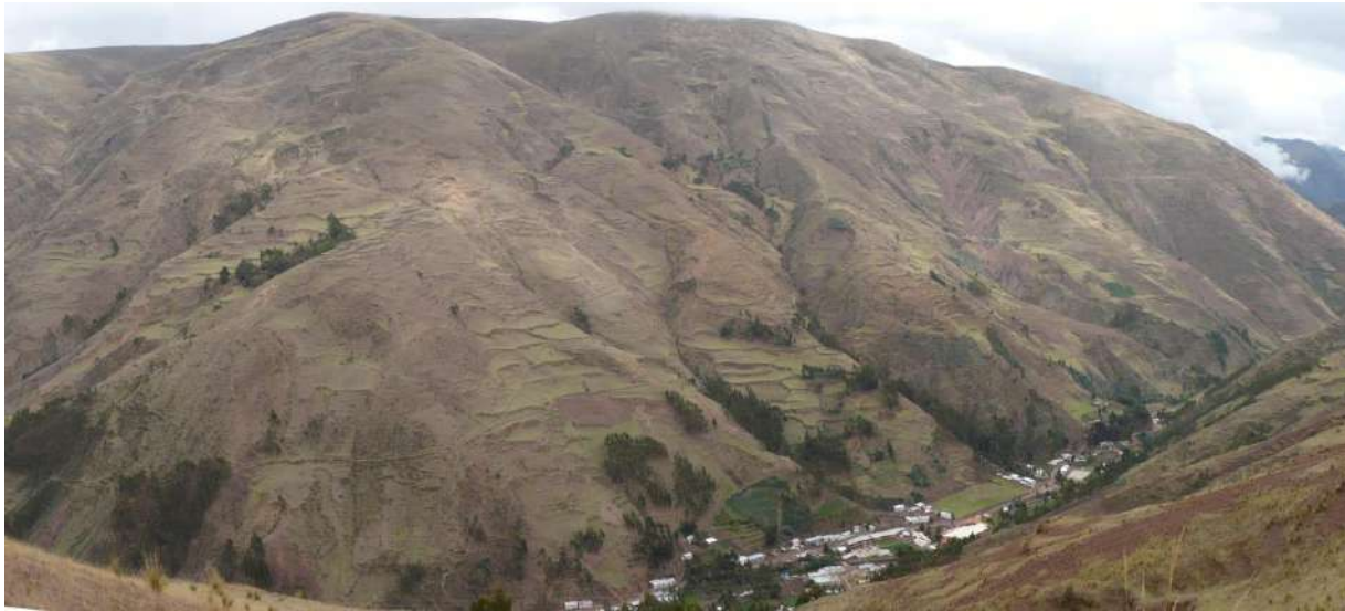
Foto 16: Erosión de laderas en el poblado Pallanchacra, en la margen izquierda del río Tingo.
