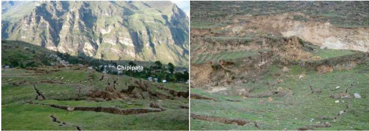
Foto 7: Sector Chipipata, con presencia de grietas transversales (izquierda), vista de saltos de la escarpa del deslizamiento (derecha).
