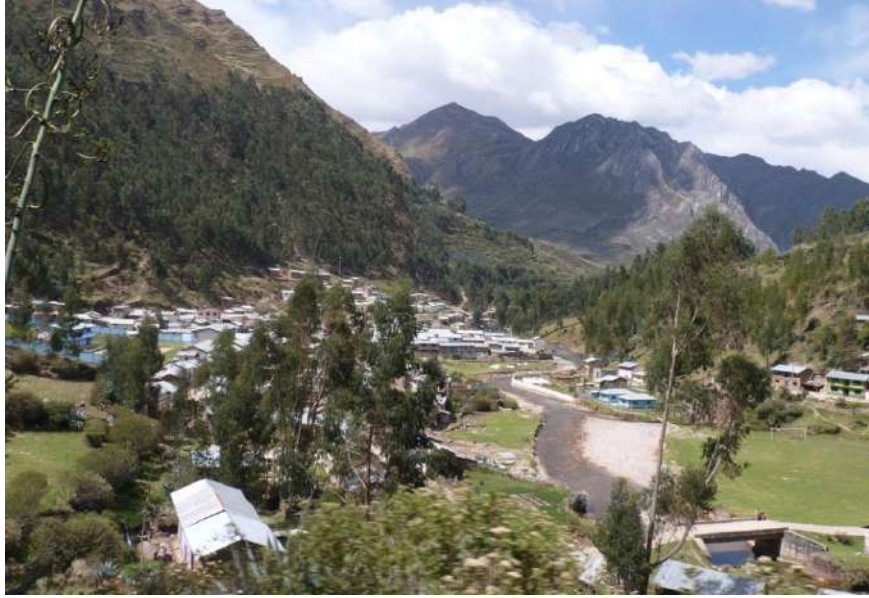
Foto 5: Zona afectada por inundación fluvial en ambas márgenes del río Andachaca, sector Chinche. Se ha colocado muro de contención.
