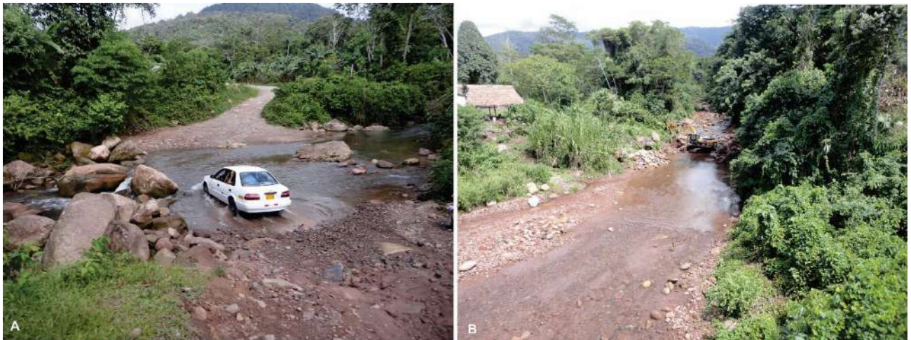
Foto 56: A) Quebrada Huarochirone que corta la carretera a Puerto Bermúdez en época de lluvias, acarrea huaicos y se desborda aislando el acceso a Puerto Bermúdez. Se ha colocado enrocado en la margen izquierda de la quebrada. B) Huaico en la quebrada Nochos.
