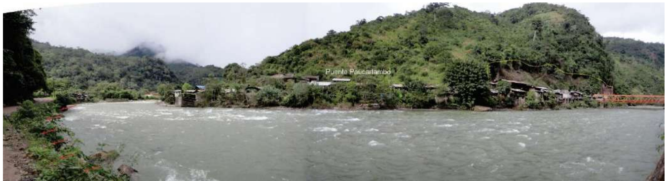
Foto 42: Erosión fluvial en la margen derecha del río Paucartambo, afecta carretera Puente Paucartambo-Villa Rica, en la margen izquierda presenta inundación y derrumbes.
