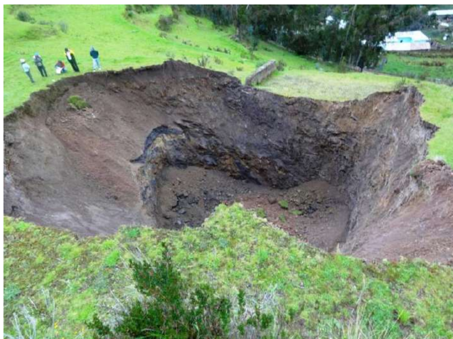
Foto 20: Hundimiento en el sector Ragán en formación kárstica, el cual colapsó el 15 de enero del 2014, con 21 m de diámetro por 20 m de profundidad (Tomado de http://diariocorreo.pe ).
