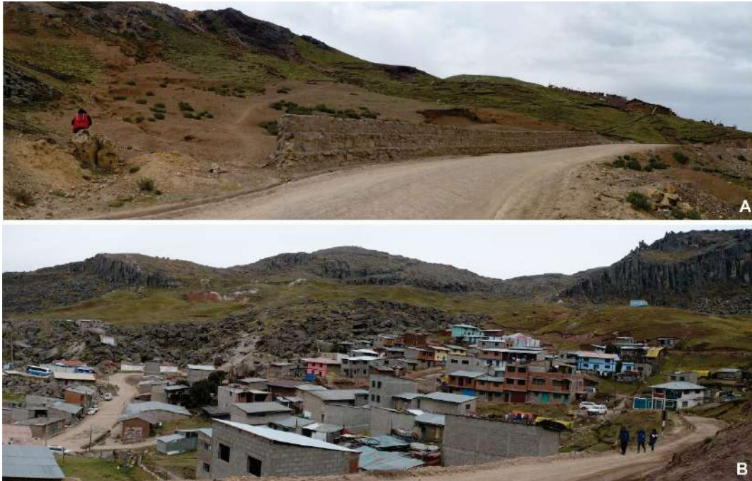
Foto 25: A) Pequeños deslizamientos en talud superior de la carretera Mina Huarón-Huayllay, con presencia de asentamientos en la carretera y reptación de suelos. B) Depósito de avalancha de rocas antiguo en el sector Huayllay, la zona también es afectada por reptación de suelos.
