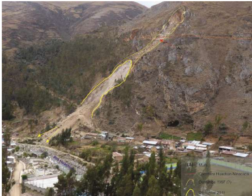
Foto 23: Derrumbes y erosión en cárcavas, en el cerro Lluyc Punta, en la margen izquierda del río Huachón (arriba), margen derecha de río Huachón, cerro Marca Marca (abajo).
