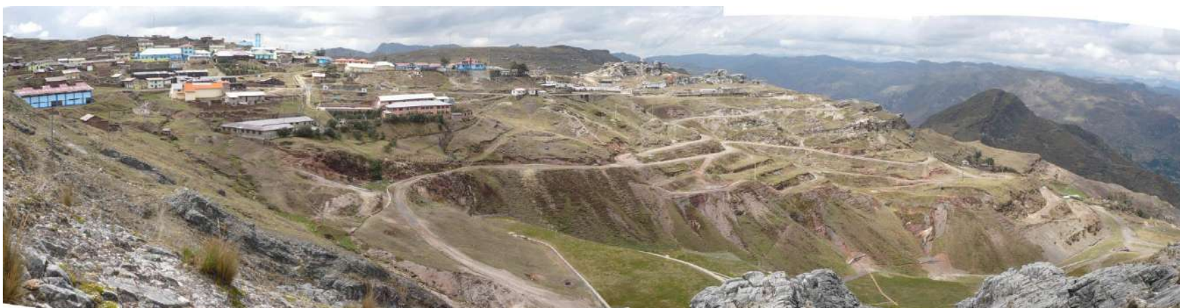
Foto 12: Vista panorámica del sector Casha, se encuentra sobre un deslizamiento rotacional antiguo con reactivaciones en forma de derrumbes y cárcavas en el cuerpo del depósito superficial.
