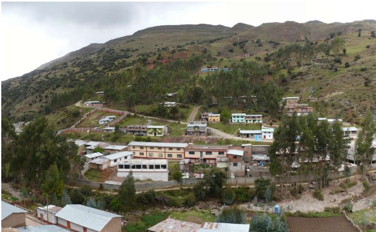
Foto 21: Deslizamiento rotacional de Yanapampa, algunas viviendas y colegio se encuentran en el cuerpo, también presenta reptación de suelos, margen derecha del río Huallaga.
