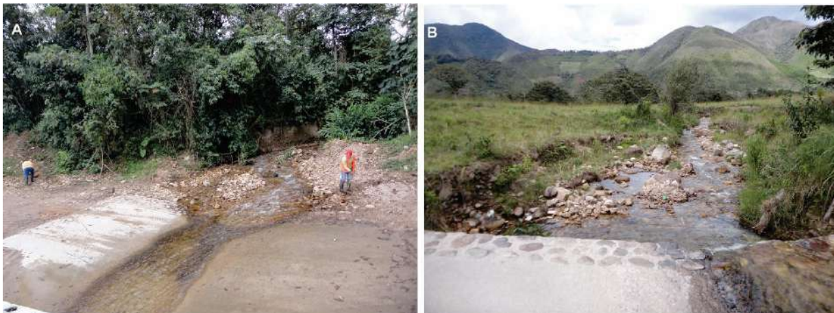
Foto 39: A) Sector 02 de Mayo, quebrada Agua Palmera de 5 m de ancho de cauce, todos los años acarrea flujos de detritos, se llevó puente de madera en diciembre del 2010, por lo que se colocó pontón de 2.5 x 1.5 m de alto en el km 1+860 de carretera Oxapampa-Tingo, puede afectar 2 viviendas y aprox. 40 m de carretera. B) Km 2+359 de la carretera Oxapampa-Tingo, cortado por la quebrada Tigre, todos los años acarrea huaicos, se ha colocado badén de 5 x 8 m, puede afectar 4 viviendas y terrenos de cultivos.
