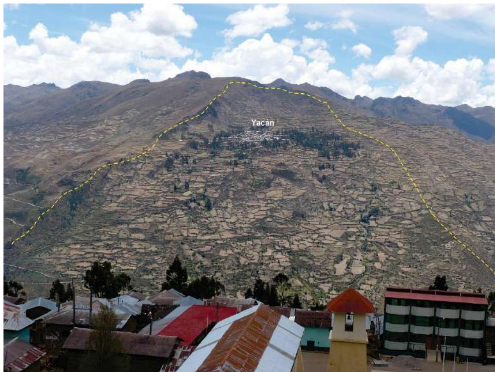
Foto 8: Vista del deslizamiento antiguo de Yacán, nótese escarpa antigua aún visible, con reactivaciones al pie del deslizamiento en la margen izquierda del río Chaupihuaranga, y presencia de erosión en cárcavas.
