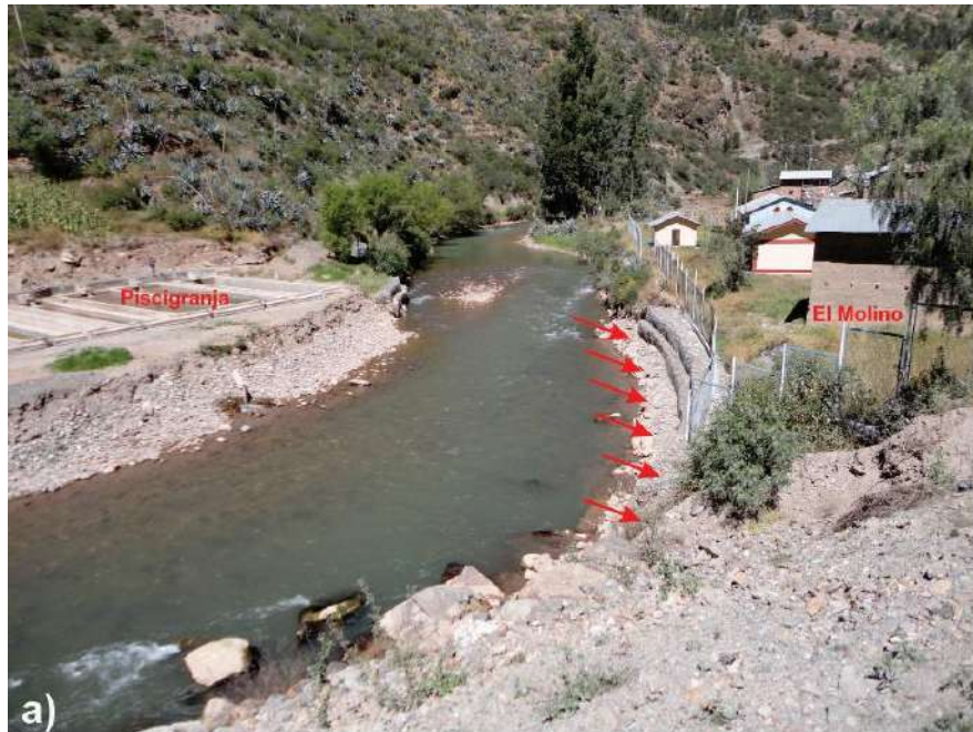
Foto 9: a) Erosión fluvial en la margen izquierda del río Chaupihuaranga que puede afectar la carretera Yanahuanca-Ambo; una piscigranja y colegio del sector Molino, también es afectado por la crecida del río.
