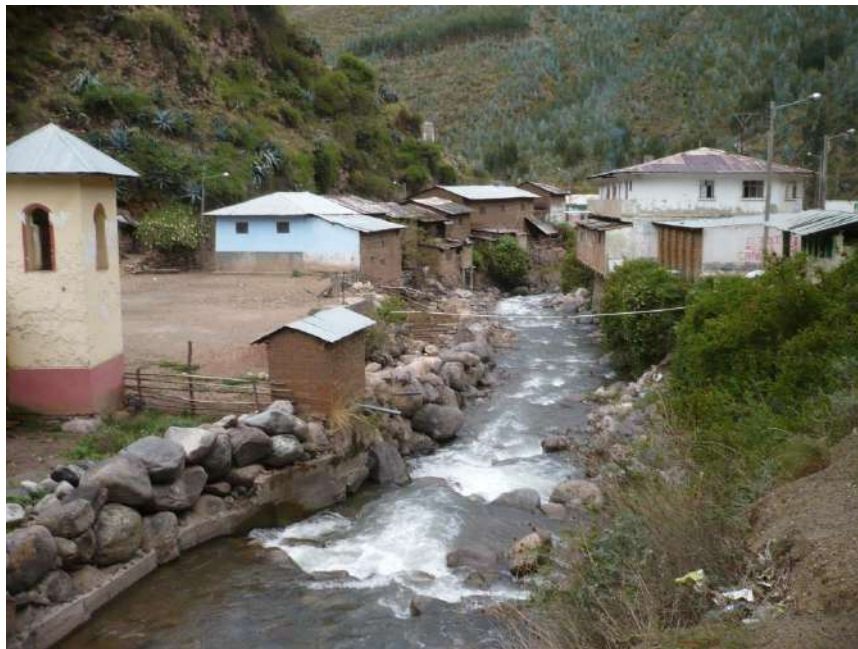
Foto 17: Erosión fluvial e inundación en ambas márgenes del río Tingo. Invación del cauce del río Tingo, viviendas del poblado Salcachupán se encuentran muy cerca a los bordes del río, esta mala práctica aumenta el riesgo.
