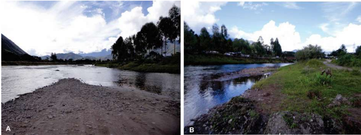
Foto 38: A) Vista aguas arriba, de la confluencia del río Chontabamba y quebrada Llamaquizú. B) Vista aguas abajo, ambas márgenes del río Chontabamba están sujetas a inundaciones, puede afectar 46 viviendas en la margen derecha del río Chontabamba. Se produce por el desborde del río Chontabamba, inundando localidades de Nueva Berna y San Carlos (14/12/1997 y 02/02/2000).
