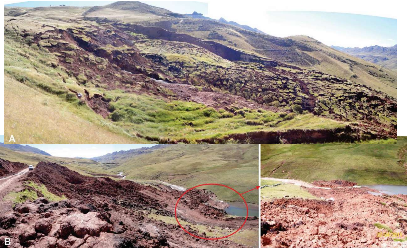
Foto 2: (A) Vista panorámica del Movimiento complejo (deslizamiento-flujo) de Santiago Pampa. (B) Vista del pie del movimiento complejo que se comportó como un flujo de lodo. Destruyó la carretera y embalsó al río Andachaca.
