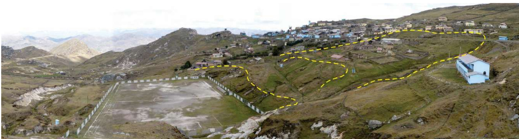
Foto 13: Vista panorámica del poblado Goyllarisquizga, parte de la población se encuentra sobre un deslizamiento rotacional antiguo con reactivaciones en forma de flujo de tierra, presenta asentamientos.
