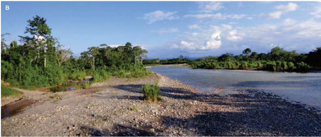
Foto 51: A) Inundación por desborde del río Chuchurras, 100 m hacia la margen izquierda, y erosión fluvial en la margen derecha aprox. 350 m de longitud, Afectó viviendas del sector Santa Rosa de Chuchurras y la carretera Pampacocha-Iscozacín. B) En marzo del 2010 afectó viviendas de los poblados Pampacocha y 07 de Junio, en la margen derecha del río Omaíz, el nivel del agua alcanzó hasta 1 m de alto sobre el nivel de la carretera.
