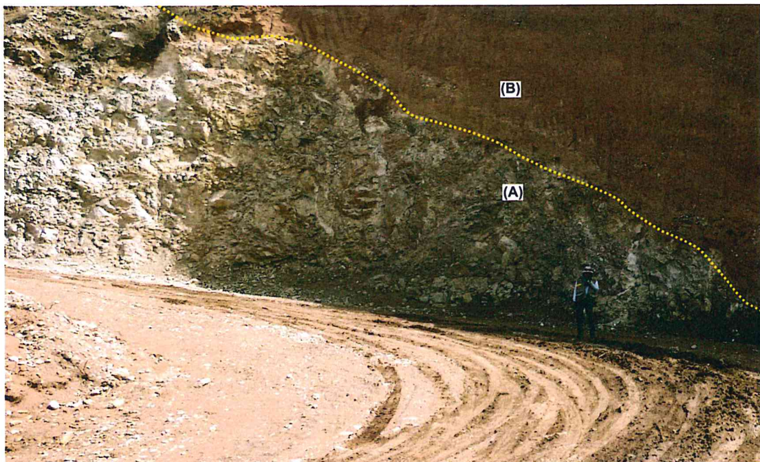
Foto 3: Contacto de las margas (A) y el depósito de deslizamiento (B).
