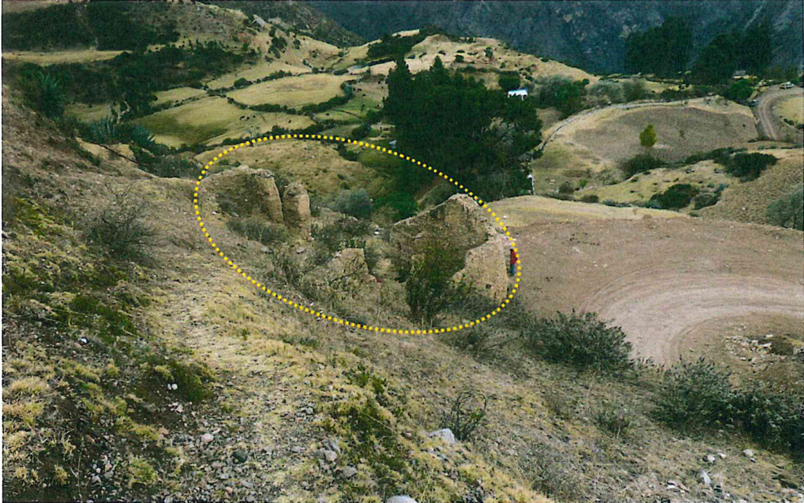
Foto 36: Vivienda afectada por la reactivación del año 1985.
