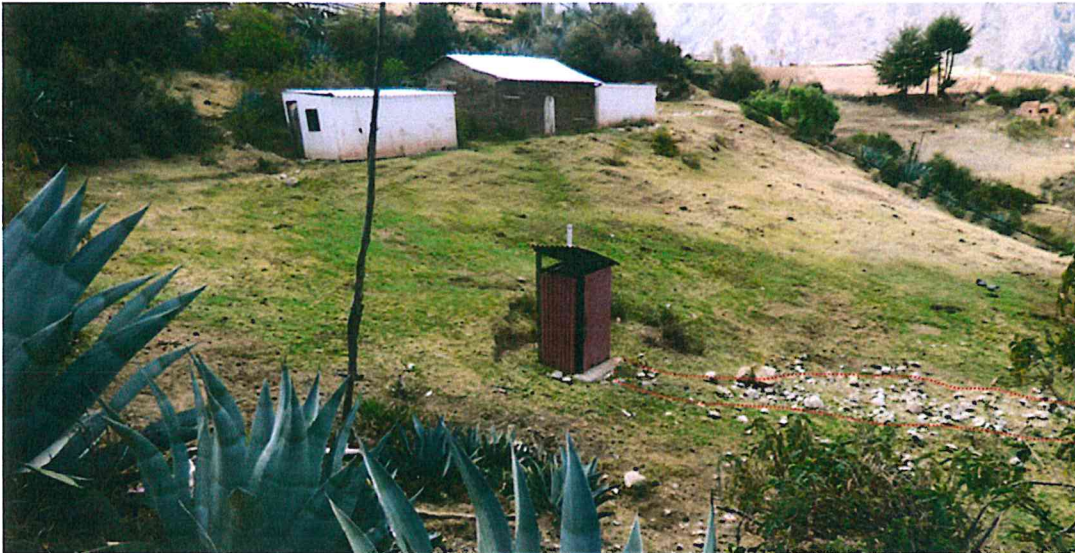
Foto 34: Letrina, se aprecia la huella dejada por el escurrimiento de agua (líneas rojas).
