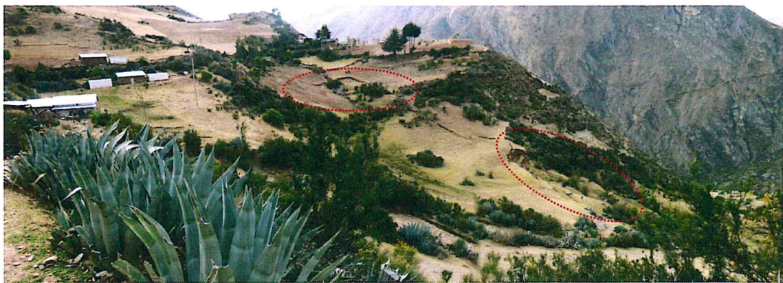
Foto 30: Se aprecian dos lugares (líneas rojas), donde se están presentando escarpas y agrietamientos del terreno.
