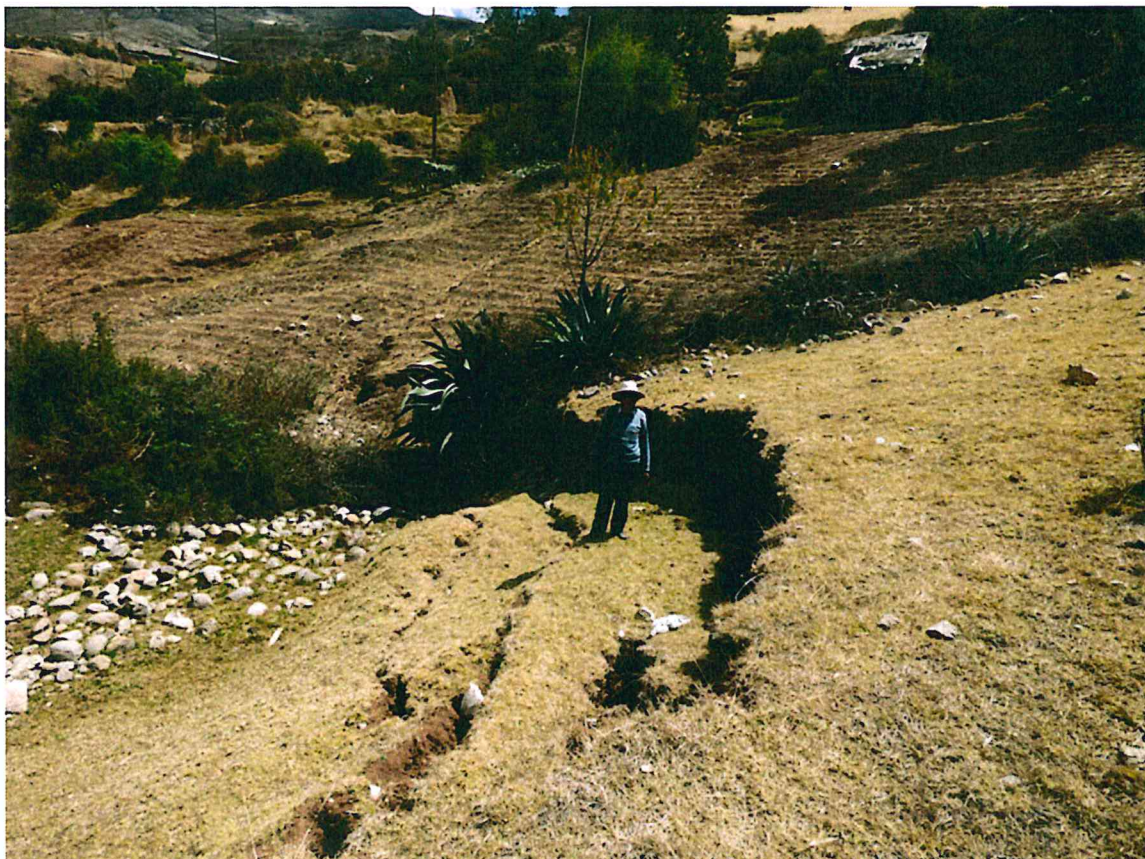
Foto 33: Escarpa secundaria, con un salto de 1 m y agrietamientos del terreno.
