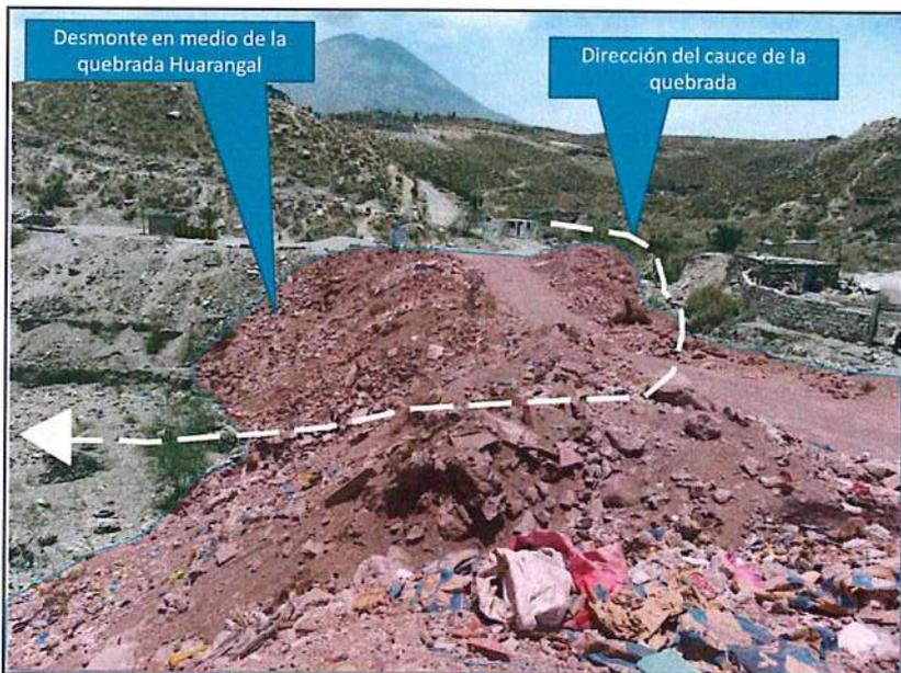
**Figura 19.** Intersección de las quebradas Chilcal y Huarangal, se observa material de desechado en medio de las quebradas, este material obstruye el cauce de las quebradas.
