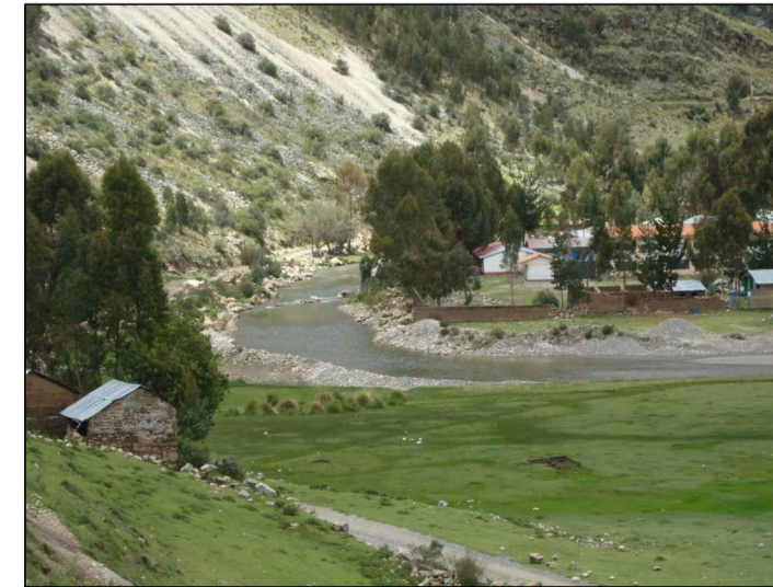
SE OBSERVA SECTOR DE LA CIUDAD MAS PROPENSO A SUFRIR DESGRACIAS POR LA PRESENCIA DE DESLIZAMIENTOS PROVENIENTES DEL CERRO CHOCCELLOCLLA (SECTOR DE ALTO RIESGO)
