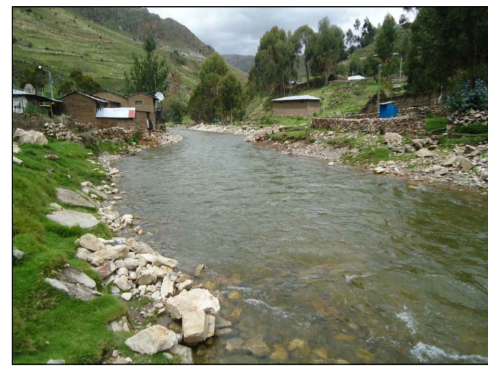
SECTOR DE LA CIUDAD PROPENSO A SUFRIR NUEVAS INUNDACIONES (SECTOR EN ALTO RIESGO)
