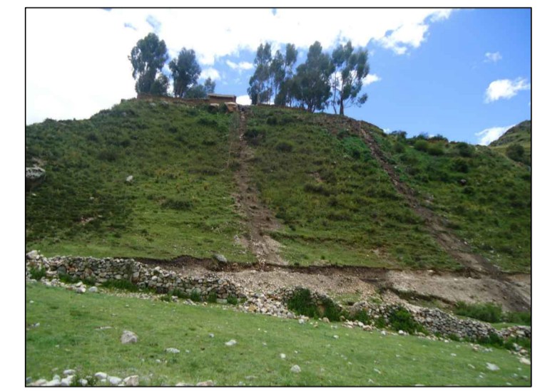
LADERA DEL SECTOR DE SANTA ROSA, EN EL QUE SE OBSERVA EROSION FLUVIAL (SECTOR EN ALTO RIESGO), A CONSECUENCIA DE NO CONTAR UN TRATAMIENTO ADECUADO DE LADERA
