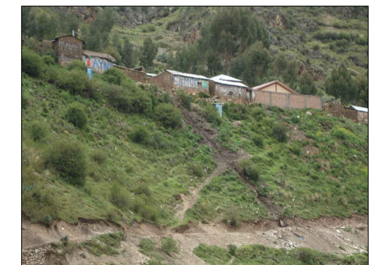
LADERA DEL SECTOR DE SANTA ROSA, EN EL QUE SE OBSERVA EROSION FLUVIAL, DESPLAZAMIENTO DE TERRENO Y ESCARPAS (SECTOR EN ALTO RIESGO), EN LA QUE SE OBSERVA VIVIENDAS E INCLUSIVE UNA I.E. QUE ESTAN PROPENSAS A COLAPSAR A CONSECUENCIA DE NO CONTAR UN TRATAMIENTO ADECUADO DE LADERA
