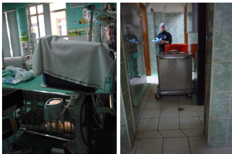
Figura 39. Equipos sin freno por lo cual, podría generarse desplazamiento de los mismos.
