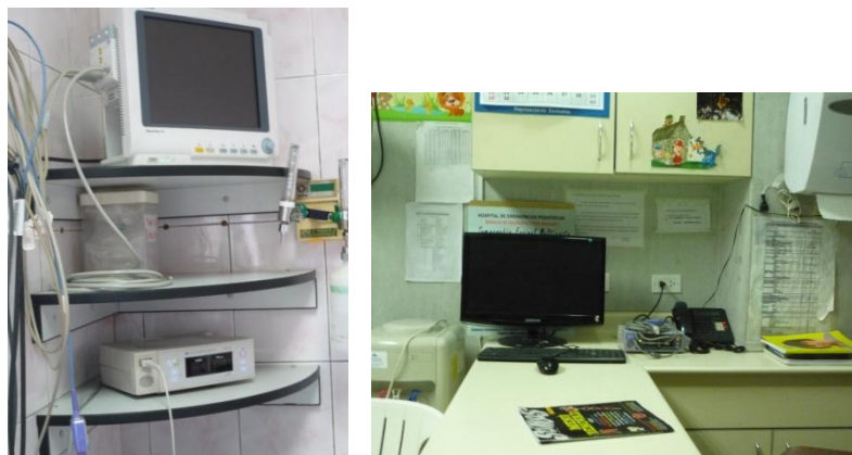
Figura 38. Los equipos médicos y no médicos no se encuentran seguros frente a posibles deslizamientos.
