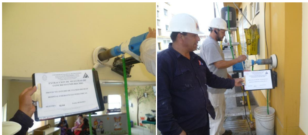
Figura 18. Extracción de núcleos de concreto.
