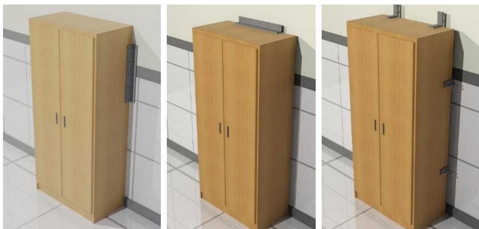
Figura 51. Muebles y armarios deben estar fijados y asegurados afín de evitar caídas que afecten al personal de salud o que obstruyan salidas o corredores de evacuación.
