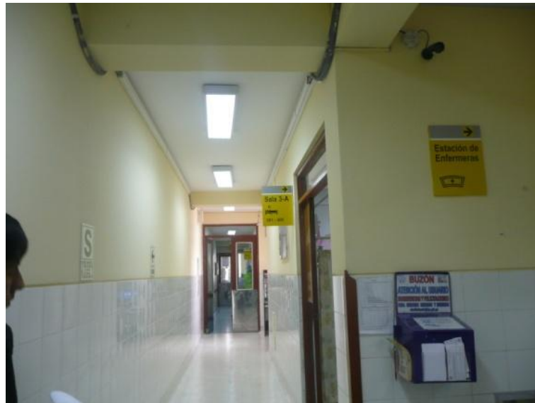
Figura 6. Tabiquería unida a la estructura.
