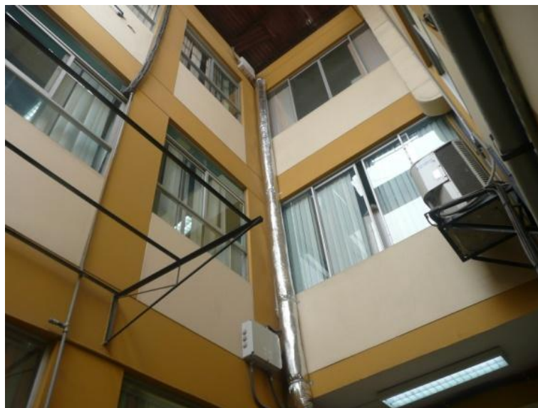
Figura 5. Vista de las estructuras del Bloque C.
