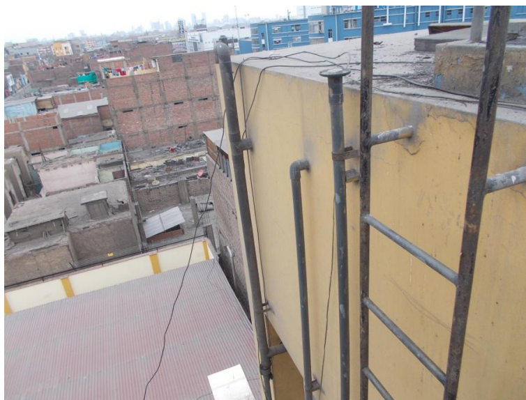
Figura 43. Ingreso a reservorio elevado.
