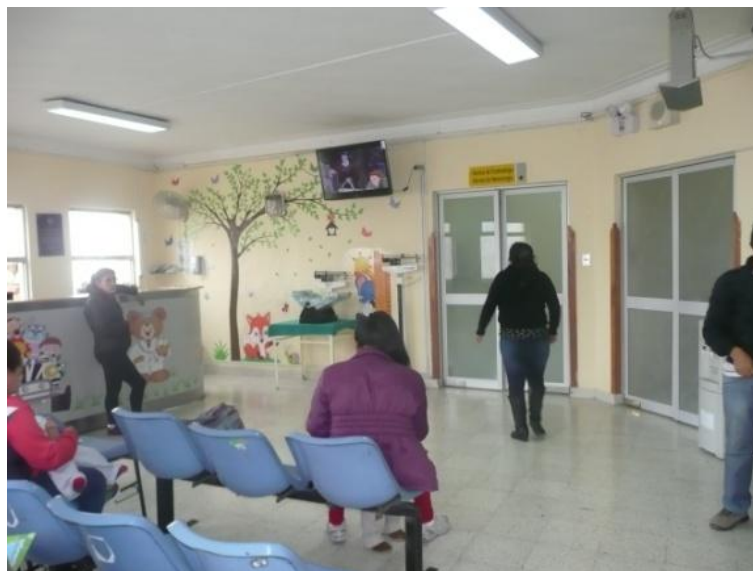
Figura 4. Vistas de las estructuras del Bloque A.
