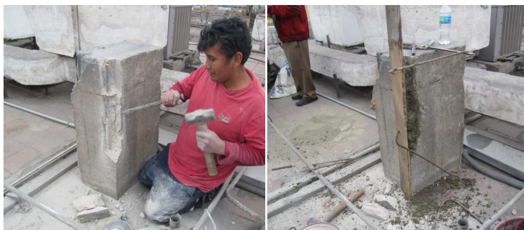
Figura 19. Extracción de muestras de acero y resane del concreto de la zona intervenida.
