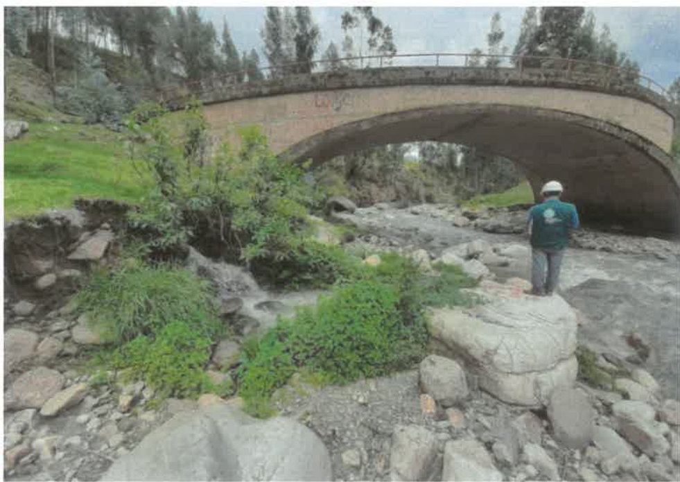
Imagen N° 6: Vertimiento de aguas residuales al río Chacapata
