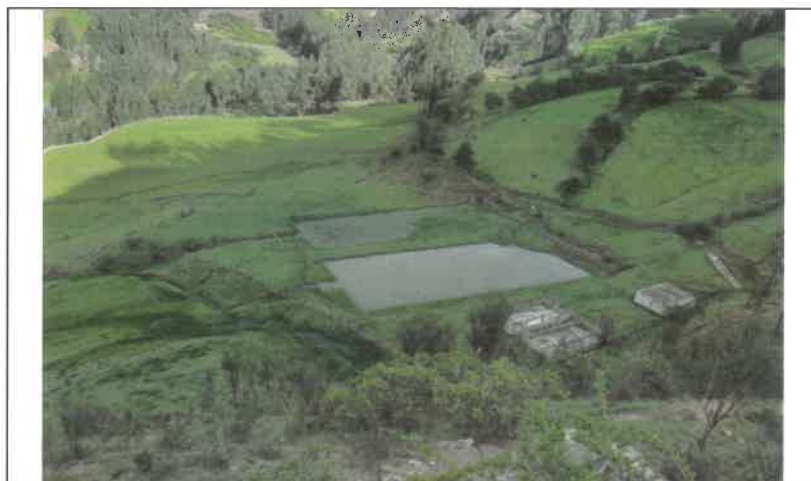
Imagen N° 4: La planta de tratamiento de aguas residuales del sector Cochapampa-Huancallu, se encuentra en estado de abandono porque no se culminó. Actualmente el proyecto se encuentra judicializado
