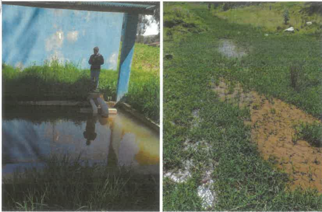
Imágenes N°11 y 12: El pozo séptico colapsó y causó la inundación de una camino de herradura y cultivos cercanos
