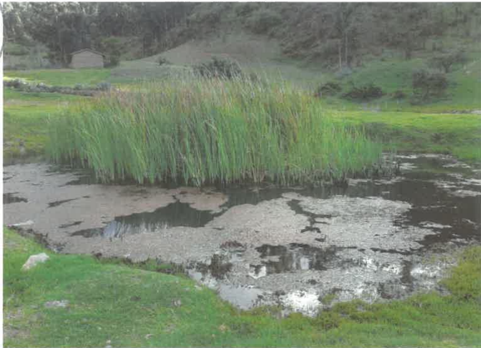
Imagen N° 5: La planta de tratamiento de aguas residuales del Sector Collpa se encuentra en estado de abandono porque el proyecto no se culminó, y actualmente se encuentra judicializado.
