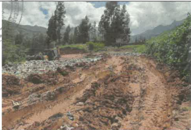
Imagen N° 1: Dificultades en el transporte de residuos sólidos en épocas de lluvia por el mal estado de las vías de acceso al botadero Ampash.
