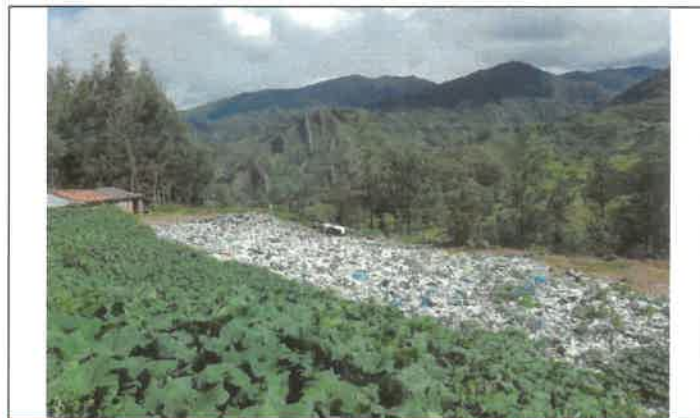
Imagen N° 3: Deficiencias en la disposición final de sólidos no valorables, tanto en la cobertura y el manejo de lixiviados en el botadero Ampash. No cuenta con la maquinaria adecuada (tractor Oruga)
