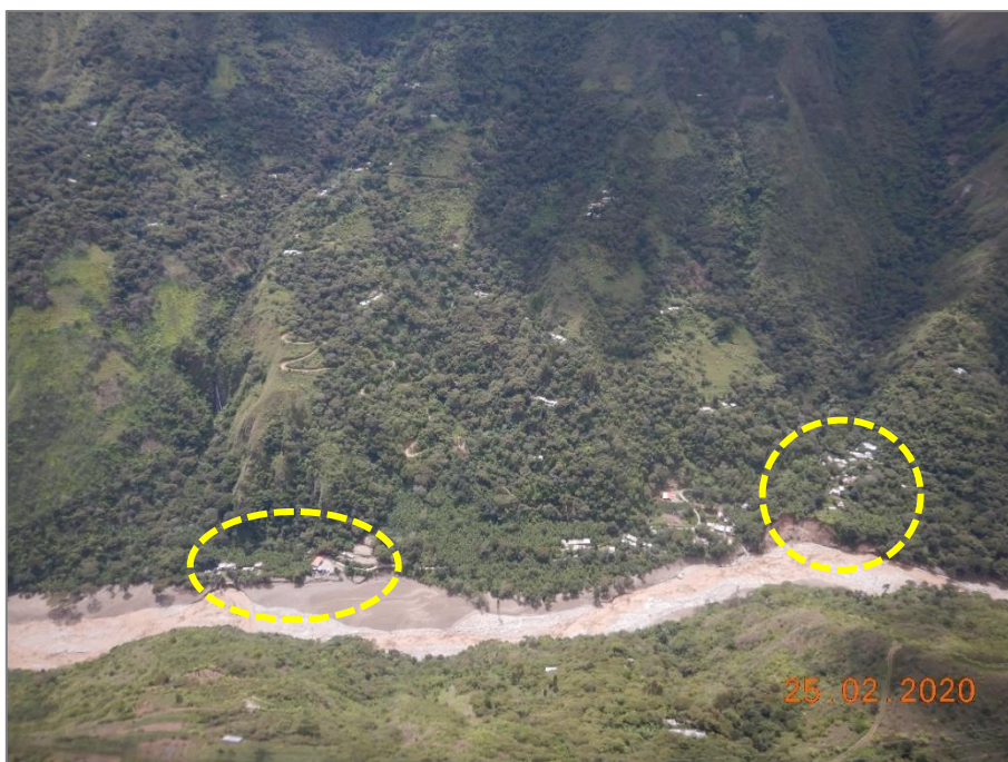
Figura 6. El sector Paltaychayoc, emplazado en la margen derecha, viene siendo afectado por la dinámica erosiva del aluvión.
