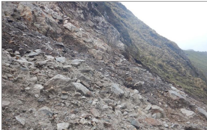
Fotografía 1. Vista de afloramiento de roca intrusiva muy fracturada, en la margen izquierda del río Salkantay.
