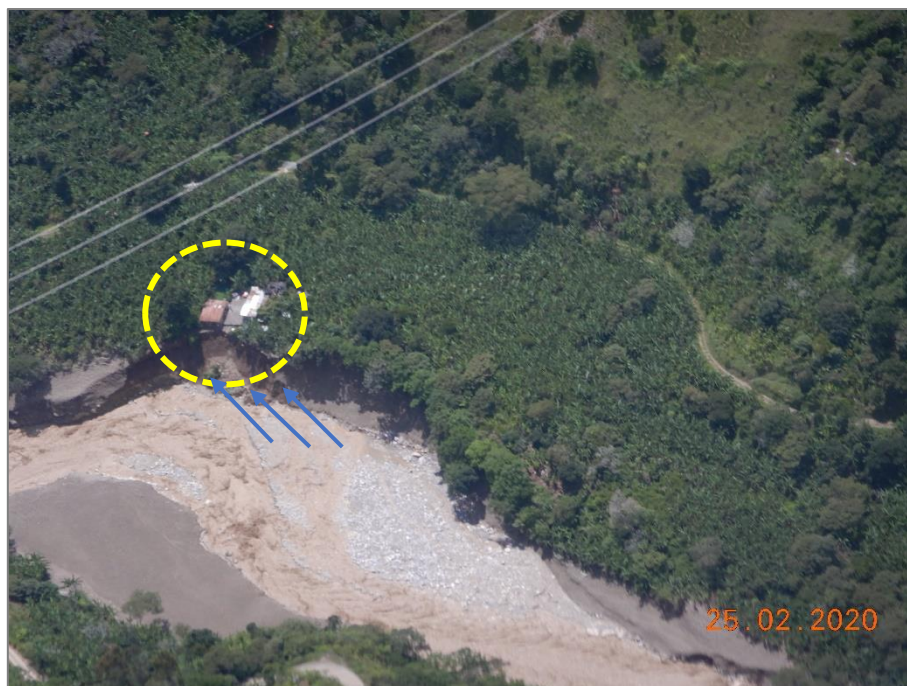
Figura 7. Se observan viviendas a punto de colapsar debido a la erosión en el talud, que generó el aluvión.
