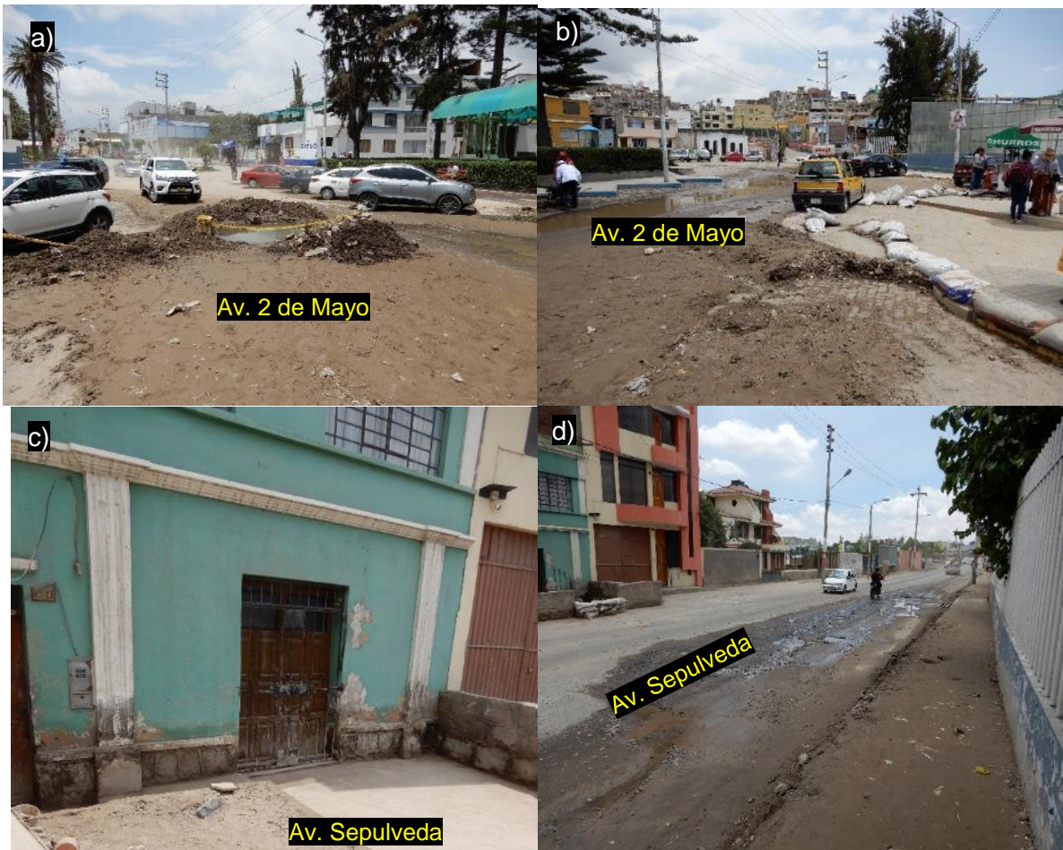
Figura 20. Sector Puente Tingo, distrito Jacobo Hunter. a y b) Av. 2 de mayo con sedimentos y bloques dejados por el huaico. c y d) El huaico llego hasta 0.50 cm de alto en las viviendas de la Av. Sepúlveda.
