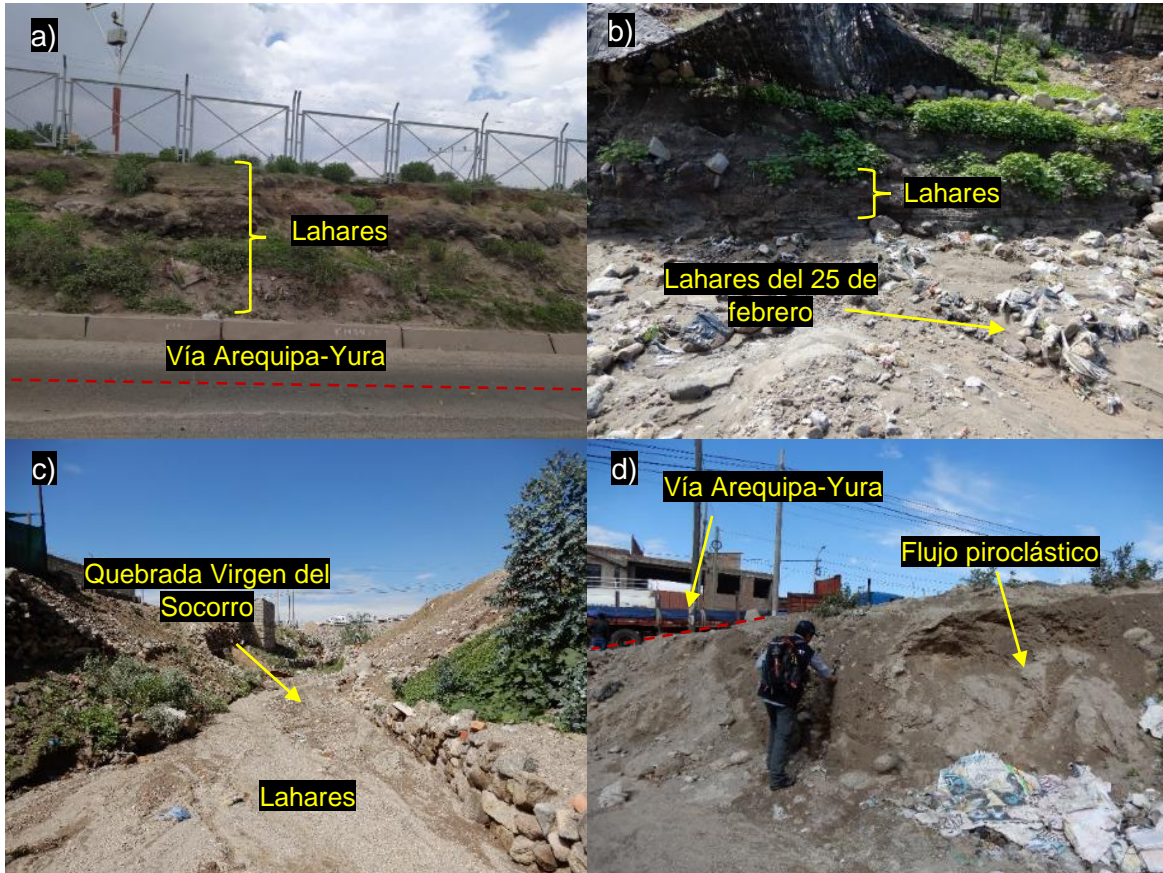
Figura 30. a) lahares de hasta 3 m de espesor, aflora en la carretera Arequipa-Yura. b) y c) lahares dentro de la quebrada Virgen del Socorro. d) flujo piroclástico de bloques y ceniza en el sector Monserrat.
