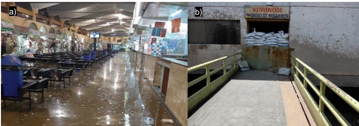
Figura 16. Sector Terminal Terrestre, distrito Jacobo Hunter. a) huaico dentro del Terminal Terrestre, b) sacos terreros en la puerta de ingreso al terminal terrestre.
