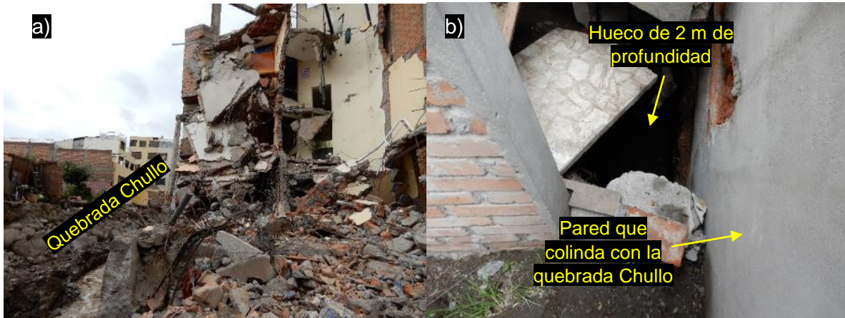
Figura 22. Sector Urbanización Independencia Americana afectada por huaicos. a) Casa destrozada e inhabitable, b) Patio de una vivienda a punto de colapsar, tiene un hueco de 2 m de profundidad.
