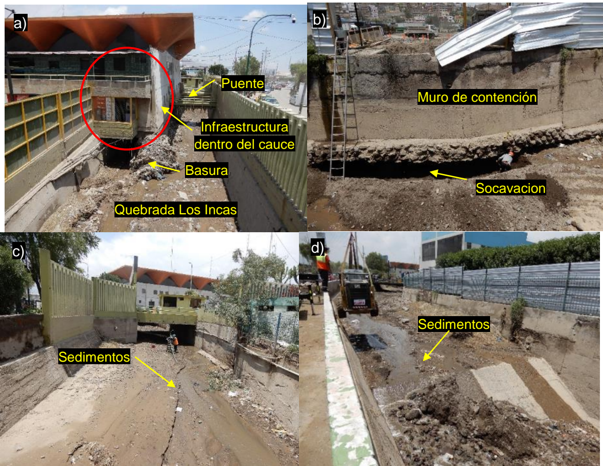
Figura 18. Sector Terminal Terrestre, distrito Jacobo Hunter. a). cauce de la quebrada Los Incas reducido hasta 4 m de ancho. b) cimiento del muro de contención erosionado. c) y d) sedimentos y bloques dejados por el huaico.
