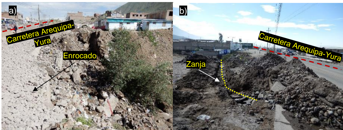
Figura 33. Trabajos ejecutados por Gobierno Regional de Arequipa, a) enrocado en el puente Monserrat. b) zanja que canaliza los huaicos desde Cono Norte y Yura hacia la quebrada Virgen del Socorro.
