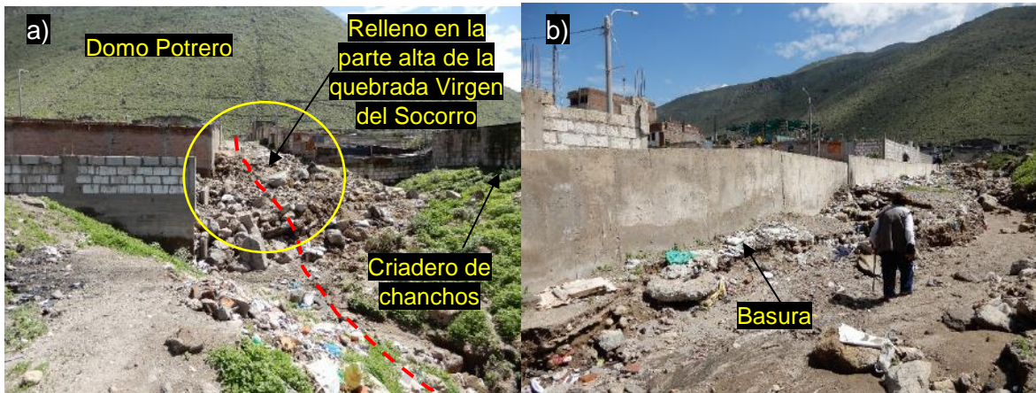
Figura 32. a) Parte alta de la quebrada Virgen del Socorro, completamente rellena, b) criaderos de chanchos, basura y desmonte en la quebrada.
