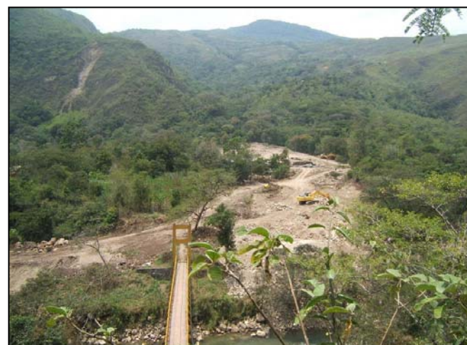
Anexo Donce, área afectada por flujos de detritos excepcionales.
