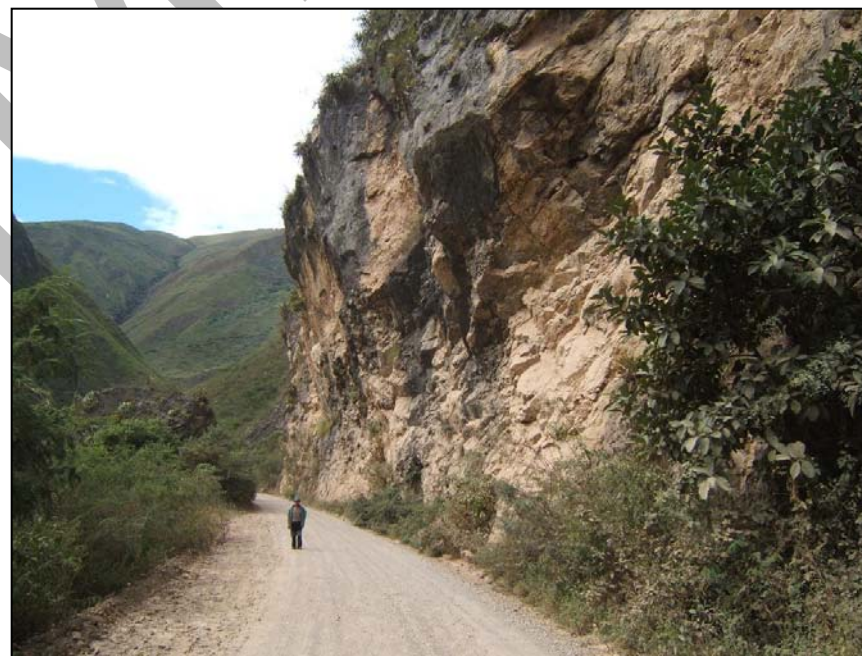
Talud de corte para carretera compuesto por material rocoso fracturado y de pendiente muy escarpada.
