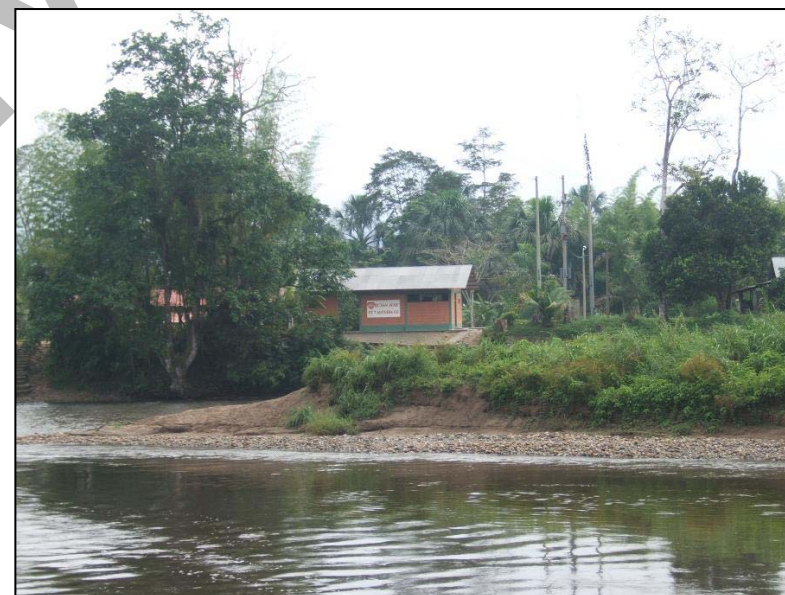
I.E. San José, Chiriaco. Ubicado en la margen derecha del río Chiriaco.
