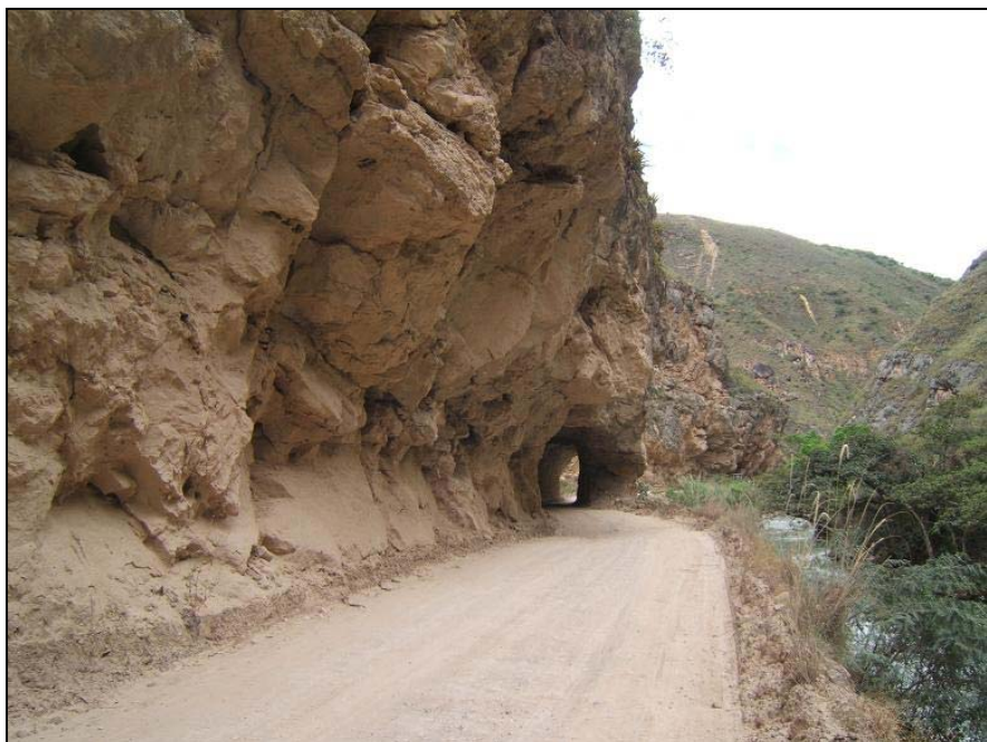
Sector El Túnel, margen derecha del río Utcubamba, se aprecia talud rocoso de muy escarpado.
