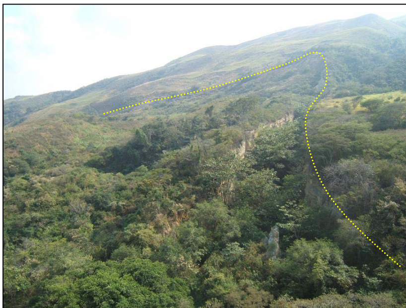
El Porvenir, escarpa del deslizamiento rotacional activo parcialmente cubierto por vegetación.
