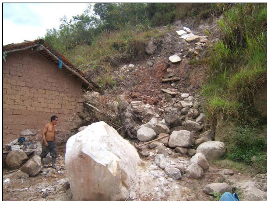
Vivienda afectada por deslizamiento activo, ubicado en el barrio San Juan de Distrito de Omia.
