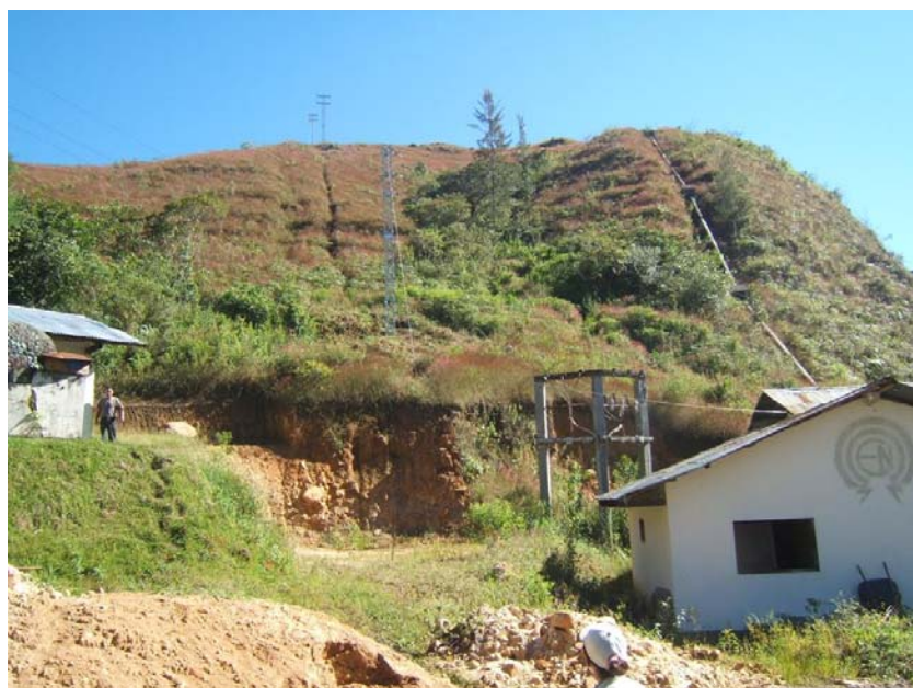
Minicentral hidroeléctrica San Antonio, afectado por Huayco en xxxx
