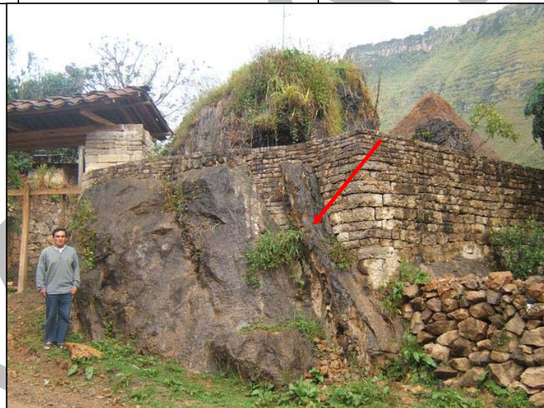
Bloque de roca de 3 a 4 m., forma parte del material proluvial (abanico) ubicado en la intersección del río Pomacochas y Atuen, nacimiento del río Utcubamba.
