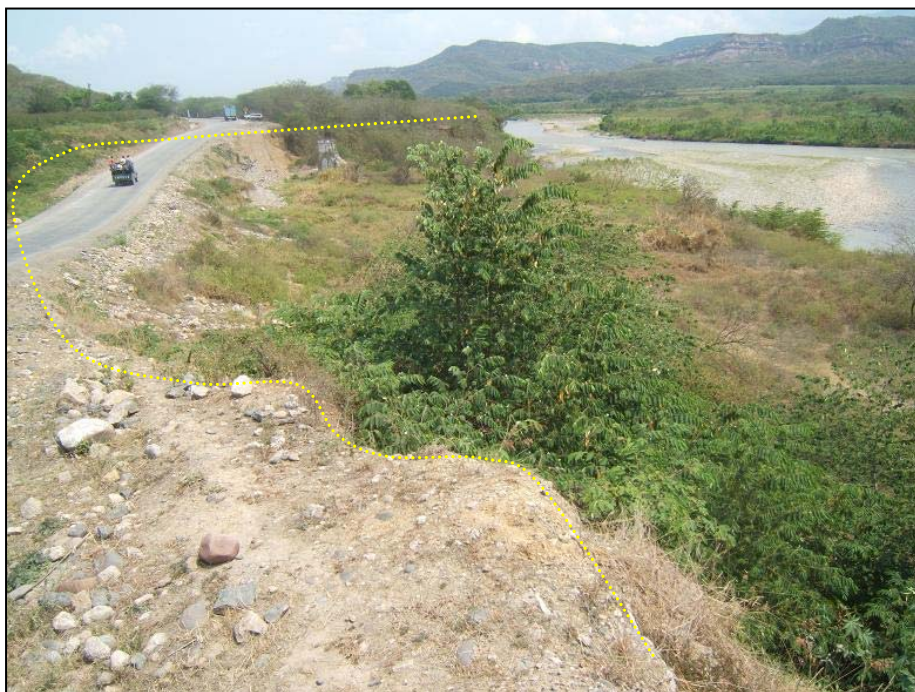
Deslizamiento rotacional elongada en la margen izquierda de río Utcubamba, cerca al Puerto de Motupe, Km 241.
