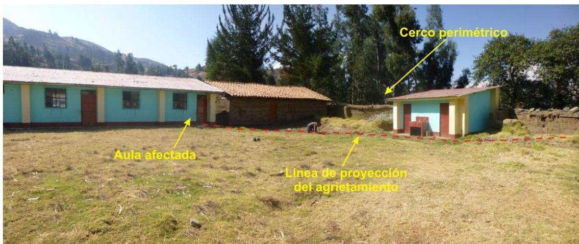
Foto 23. Zona afectada del centro educativo.
