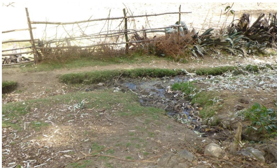
Fotos 20 y 21. Puquiales con drenaje inadecuado (canales sin revestimiento).
