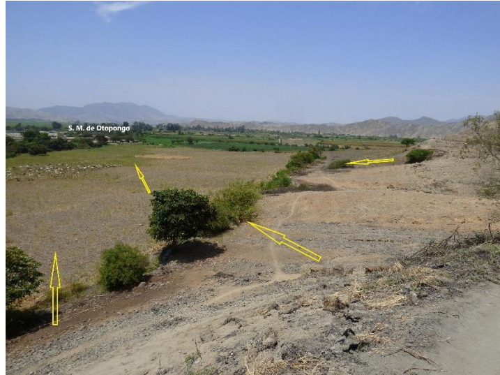
Figura 9: Vista con dirección al suroeste donde se ha señalado con flechas de color amarillo la dirección que siguen los flujos de agua y detritos que discurren por la ladera del cerro Botija, hacia el fondo se ubica el centro poblado de Santa María de Otopongo.
