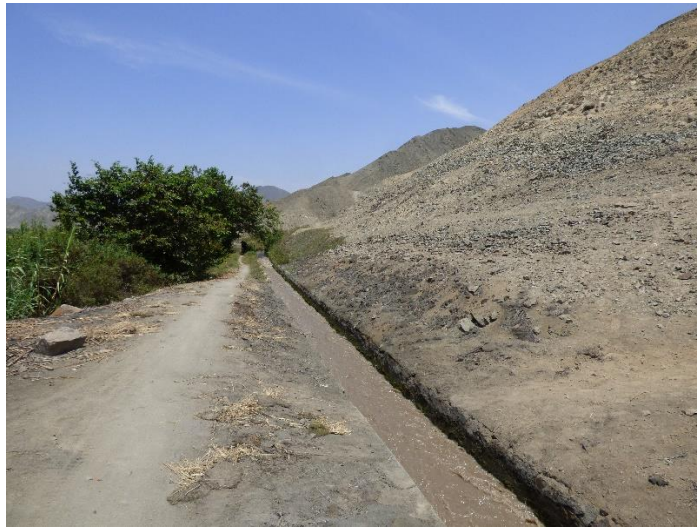
Fotografía 5: Vista con dirección al noroeste donde se observa el canal de riego de concreto y mampostería abierto en la ladera del cerro Botija, a una altitud más elevada que el centro poblado de Santa María de Otopongo.
