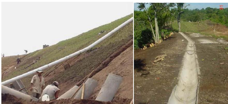
**Figura 26.** Cunetas en bermas, en la corona de un talud, utilizando elementos prefabricados de concreto.
