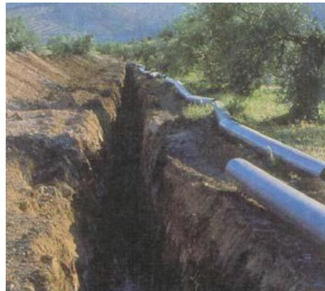
**Figura 28.** Zanja para la colocación de tubería de un drenaje longitudinal. Tomado de libro "Ingeniería Geológica".
