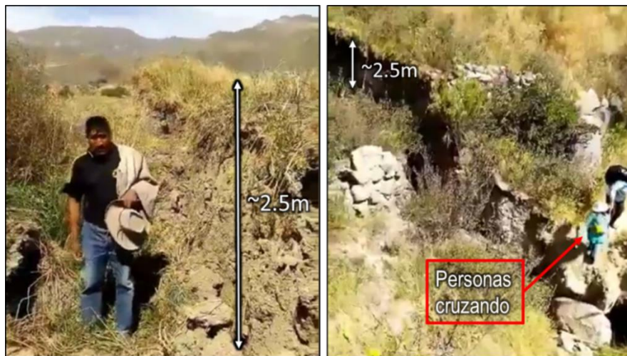
Figura 1: Grietas en el distrito de Achoma reportadas el 15 de mayo de 2020 por pobladores. ( https://www.facebook.com/AchomaPeru/videos/2170168599795797/ )
