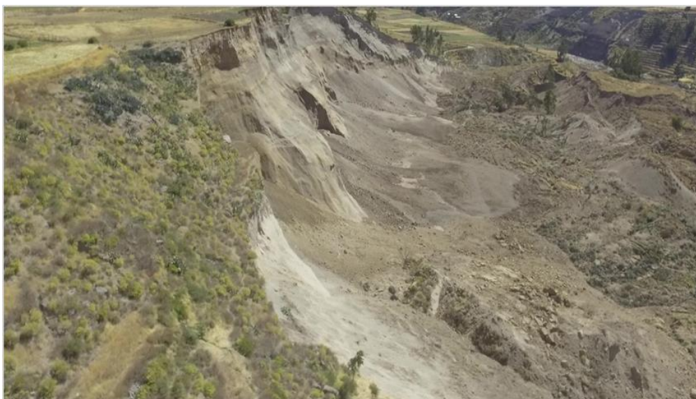
Figura 6: Captura del deslizamiento ocurrido en Achoma a partir del sobrevuelo de un vehículo aéreo no tripulado o dron.
