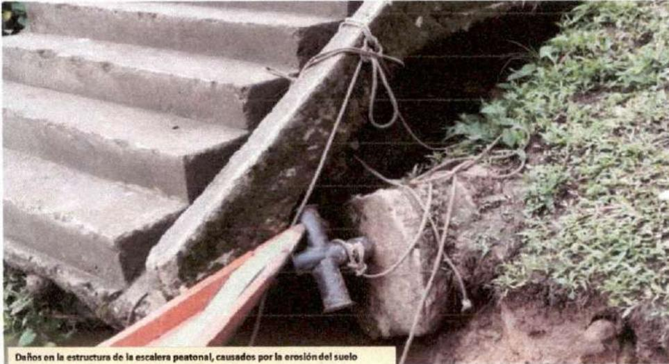
Daños en la estructura de la escalera peatonal, causados por la erosión del suelo
