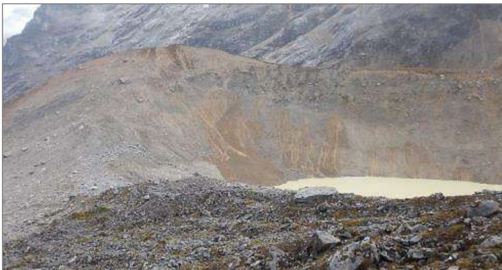
Fotografía 6. Vista de deslizamiento en la morrena lateral derecho.
