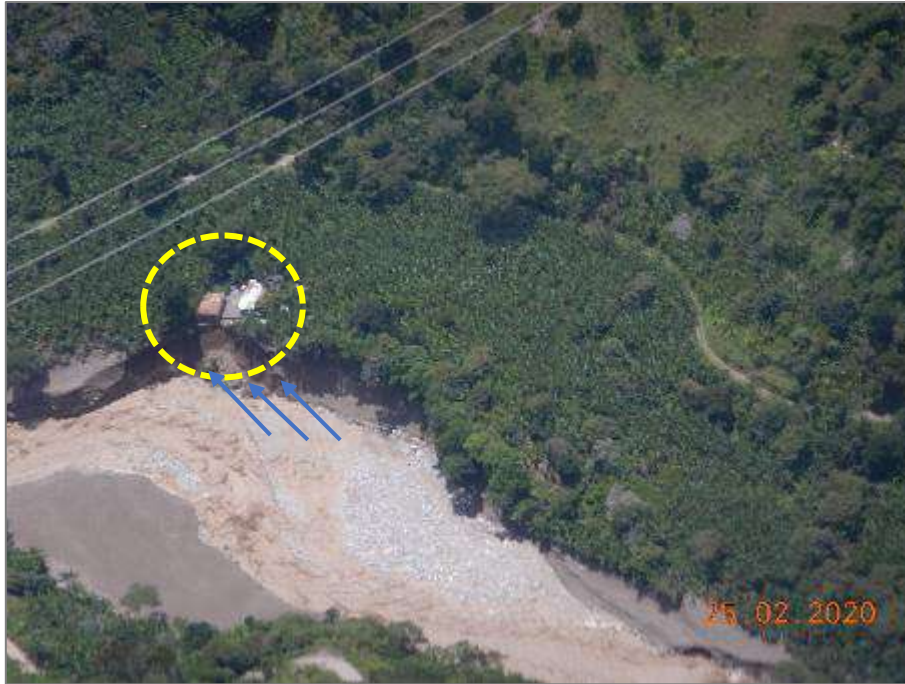
Figura 13. Se observan viviendas a punto de colapsar debido a la erosión en la base del talud, que generó el aluvión.
