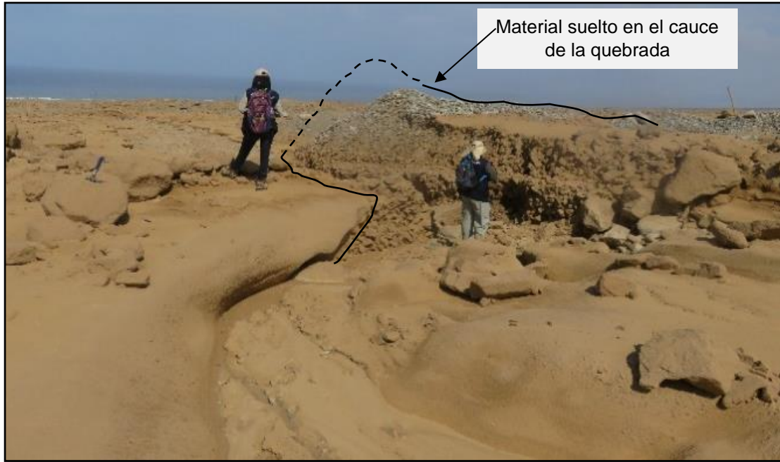
Figura 10. Muestra montículo de material de escombros en el cauce de la quebrada
