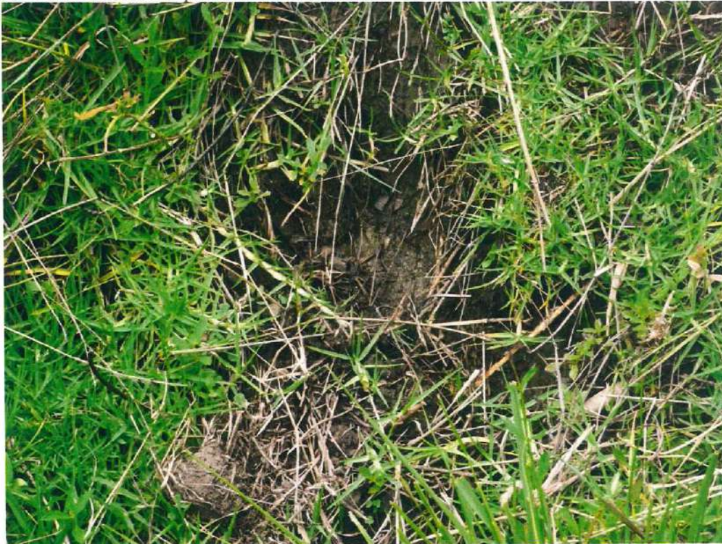
Fotografía 5: Vista del suelo saturado con agua proveniente de fugas en las tuberías del reservorio de agua.
