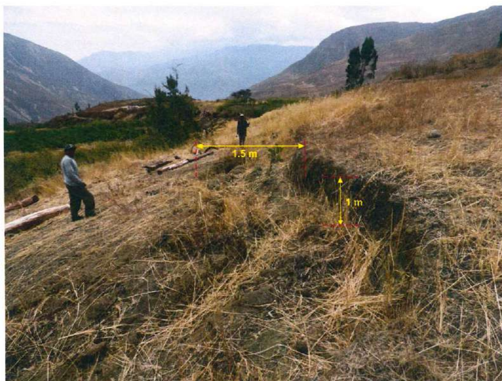
Figura 15: Vista con dirección al noroeste donde se puede observar la escarpa principal del deslizamiento D3, el bloque de suelo basculado en el cuerpo y la abertura en el suelo de 1,5 m de longitud.
