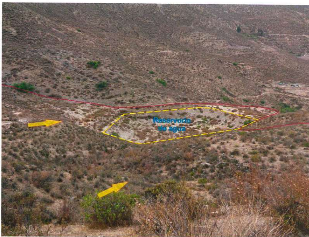
Figura 25: Vista con dirección sureste donde se puede observar el reservorio de agua asentado en parte del cuerpo del movimiento complejo.
