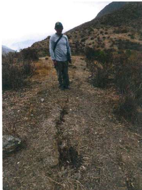
Figura 24: Grieta con abertura de 0.10 m ubicada detrás de la escarpa principal de la reactivación R1.
