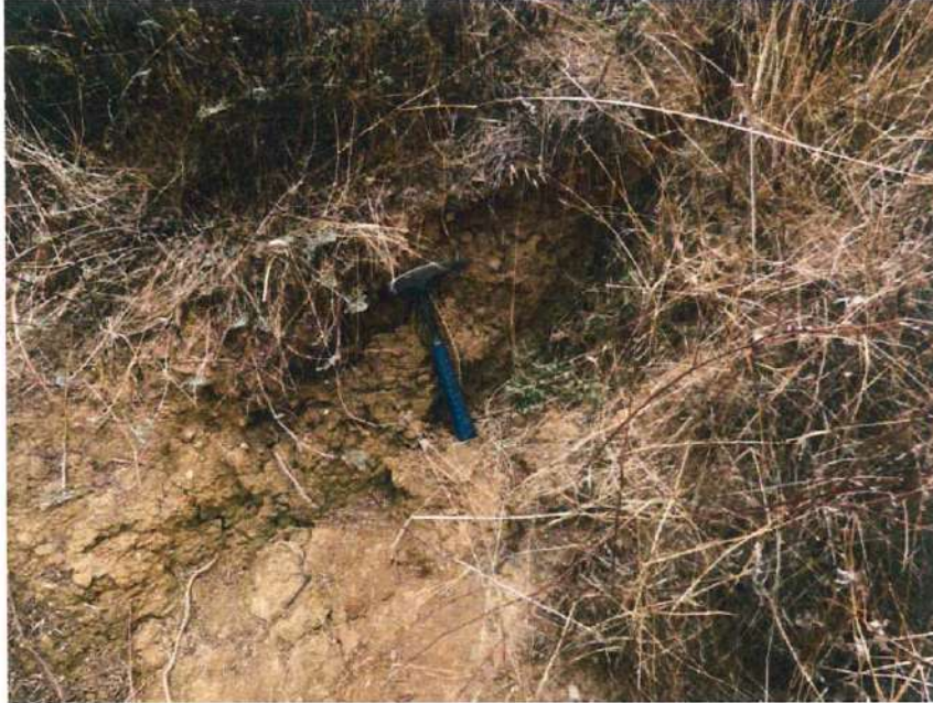
Fotografía 11: Vista de la grieta G2 donde se puede observar el salto que produjo en el terreno de unos 0.40 m.
