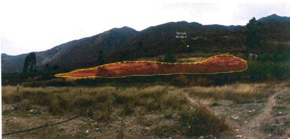
Figura 12: Vista con dirección al este donde se marcaron los límites del deslizamiento rotacional D3, por encima de la escarpa principal se ubica un reservorio de agua de concreto.
