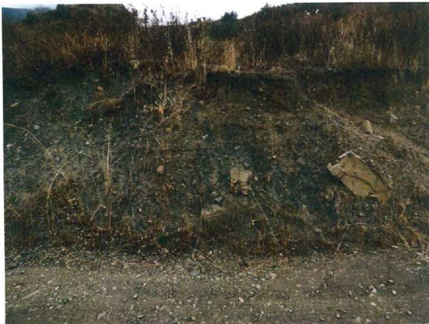
Fotografía 9: En la vista es posible observar el suelo arcillo-limoso con gravas y boques, derivado de la alteración de las arcillitas de la Formación Carhuaz.
