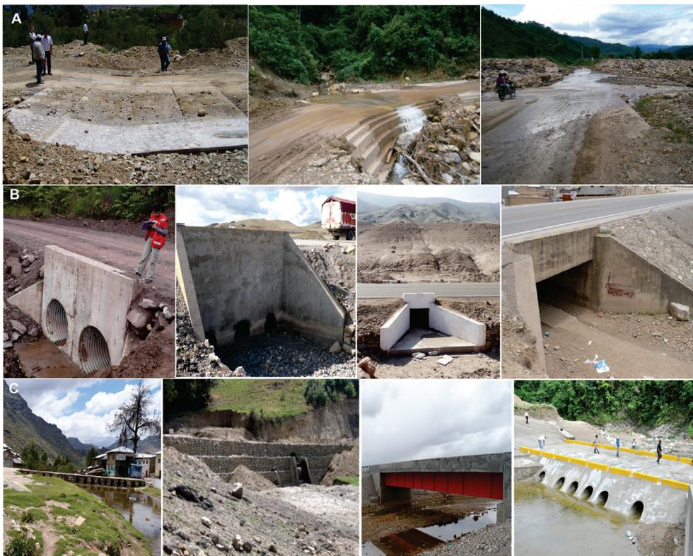
Fotografía 9.6 Obras de drenaje para redes viales, A) badenes, B) alcantarillas y pontones y C) puentes, puentes-badén.
