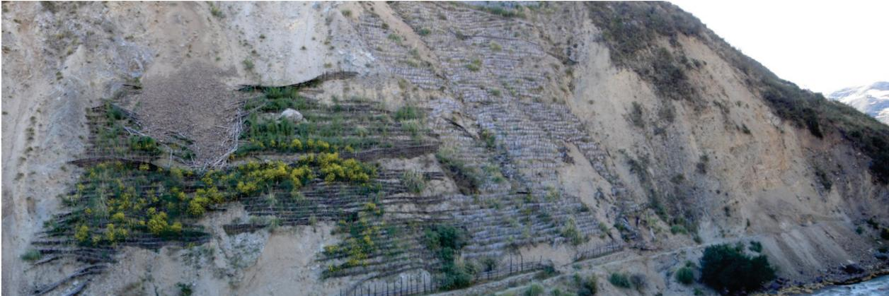
**Fotografía 9.8** Ejemplo de evacuación de aguas superficiales y control de erosión en cárcavas, mediante trinchos escalonados.
