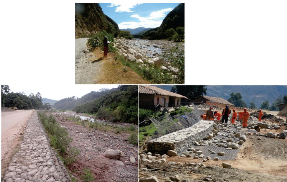
Fotografía 9.9 Ejemplos de uso de enrocados y muros de gaviones para protección de carretera. En muchos casos esto debe estar acompañado de un levantamiento de la rasante de la carretera.
