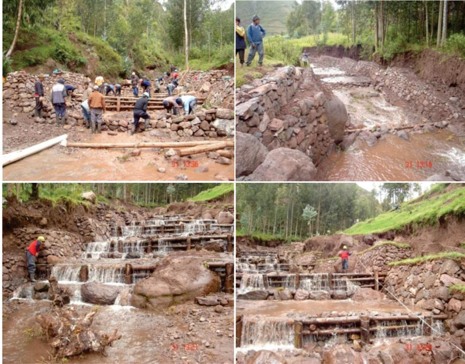
**Fotografía 9.5** Construcción de disipadores de energía de las corrientes concentradas en el cauce de la quebrada, mediante diques transversales (enrocado y armazón de troncos) y canalización del cauce con muros laterales escalonados utilizando bloques de rocas para mitigar los efectos ante la ocurrencia de un flujo de detritos.
