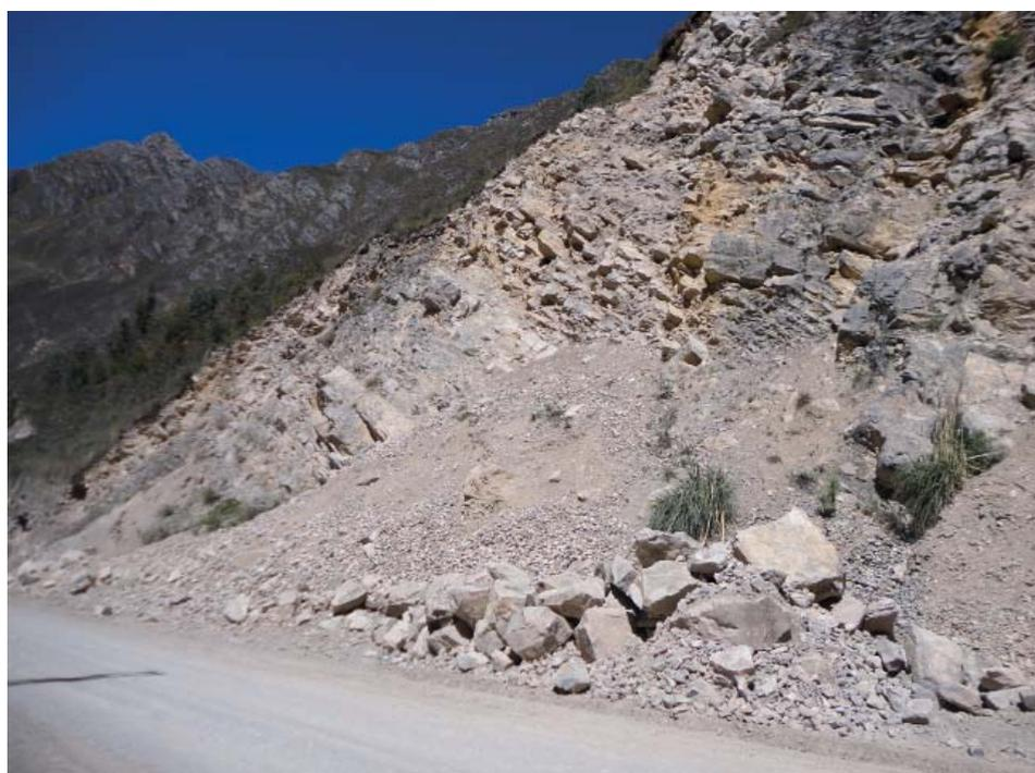
**Fotografía 3.6** Areniscas con intercalaciones de lutitas del Grupo Goyllarisquizga en la carretera a Yanahuanca, con presencia de caída de rocas y vuelcos en el talud de corte.
