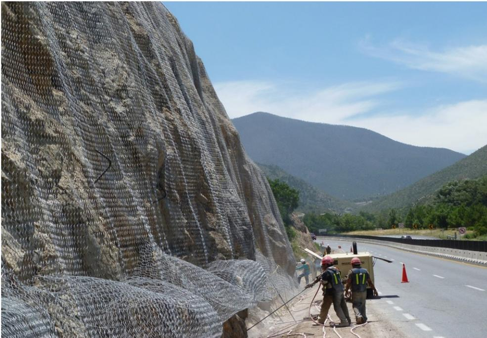
**Fotografía 9.2** Mallas de protección con anclajes para caída de rocas o derrumbes tanto en detritos como roca alterada.
