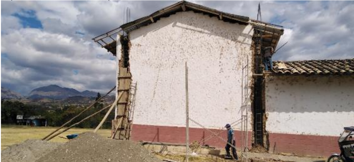
Figura 27. Iglesia del centro poblado Nuñumabamba en proceso de restauración.
