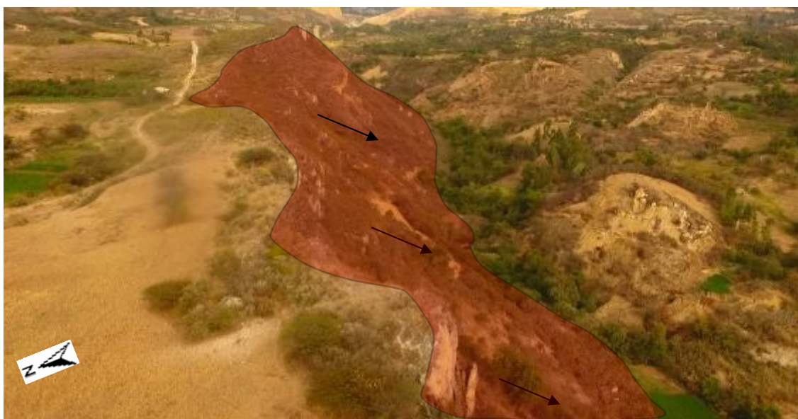
Figura 22. Vista aérea de la zona de derrumbes y caída de rocas.
