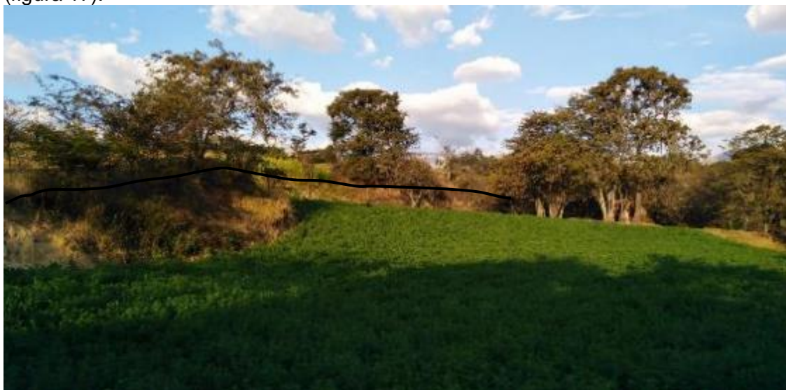
Figura 17. Escarpe principal de deslizamiento en el sector Lomas de viento.
