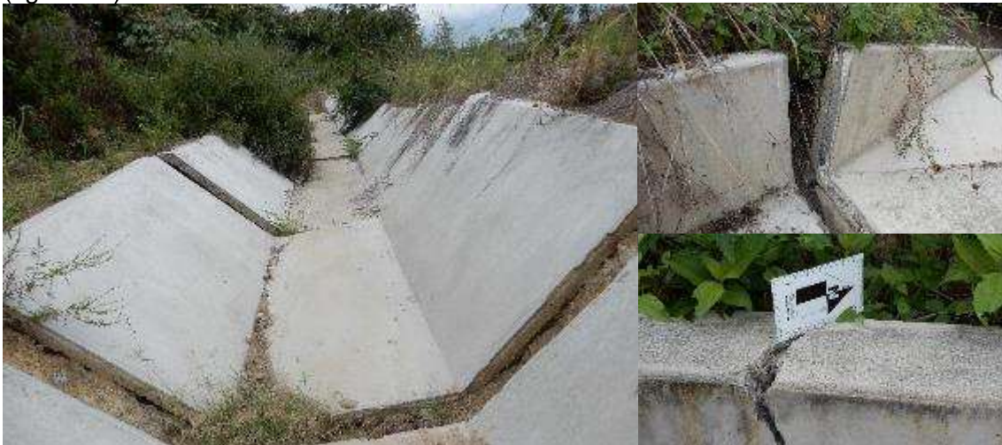
Figura 36. Canal de riego Santa Isabel – Misquiyacu Alto.
