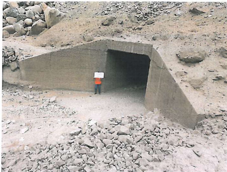
Figura 60: Sistema de drenaje de la quebrada, parte inferior.
