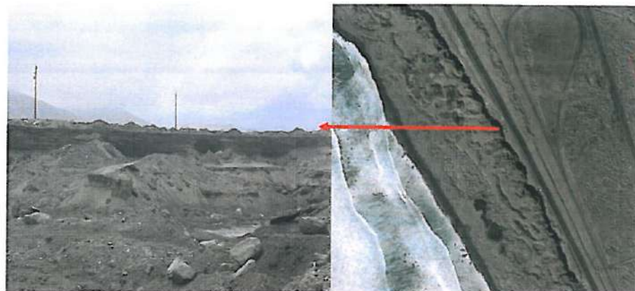
Figura 138: detalle de la zona de deslizamiento.
