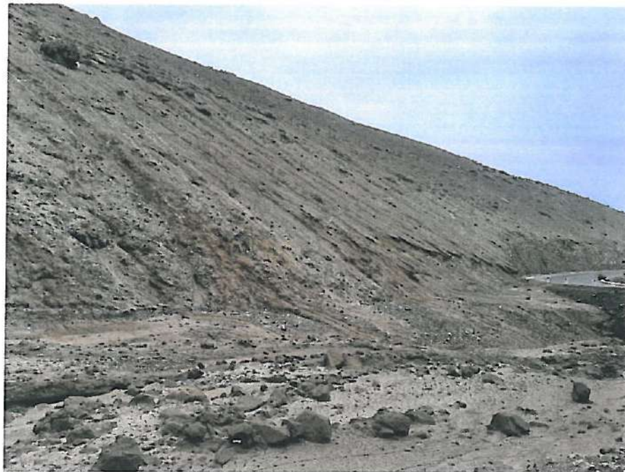
Figura 140: Zonas de deslizamiento, carretera Costanera Norte.
