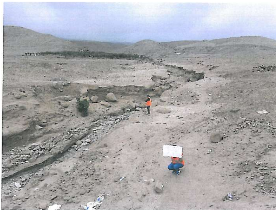
Figura 94: Socavación del canal principal de la quebrada.
