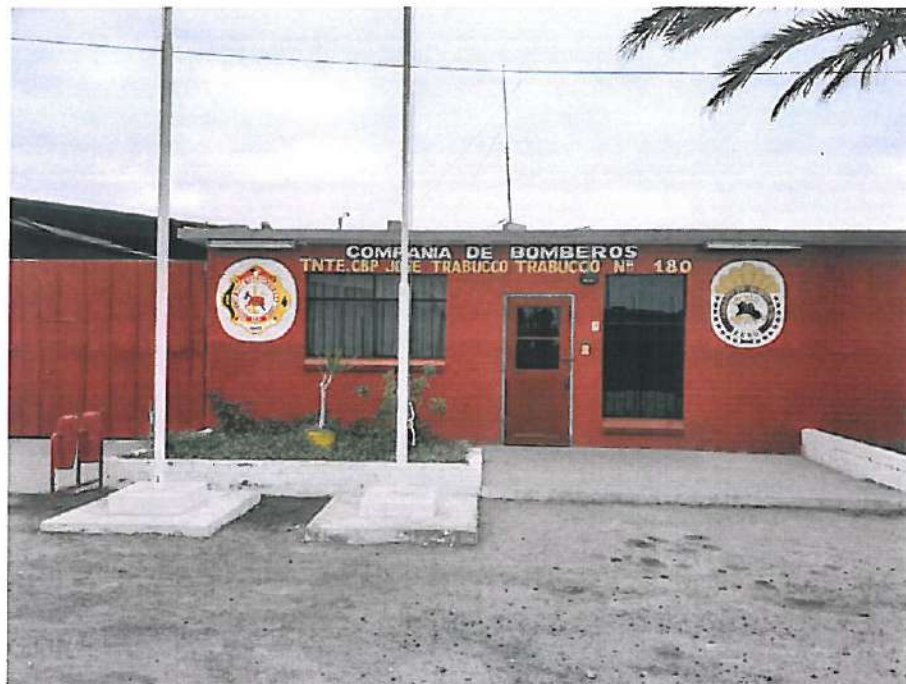
Figura 20: Estación de Bomberos - Pacocha.
