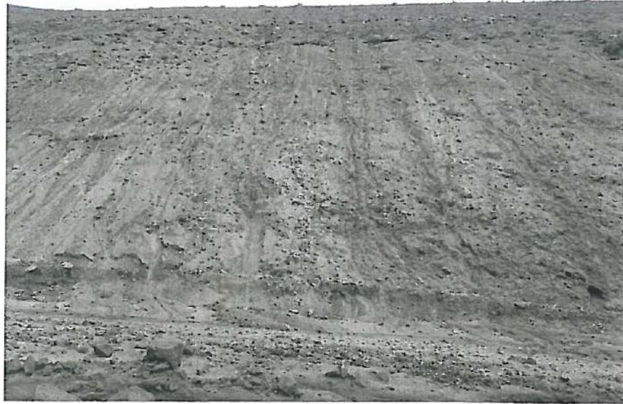
Figura 45: zonas de deslizamiento en la carretera Costanera Norte.
