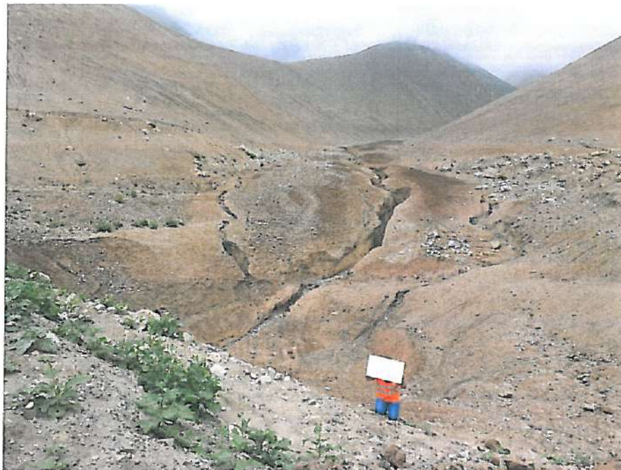
Figura 76: socavamiento en el canal principal.
