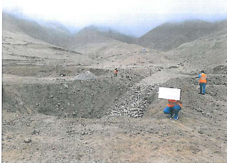
Figura 79: Canal principal completamente colmatado
