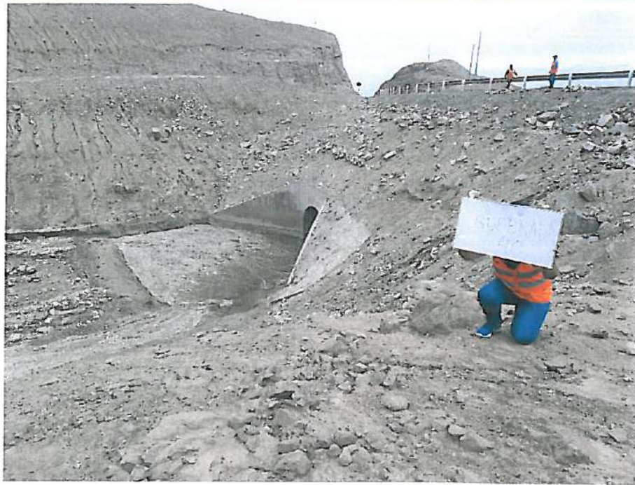
Figura 83: Vista de la quebrada aguas abajo.
