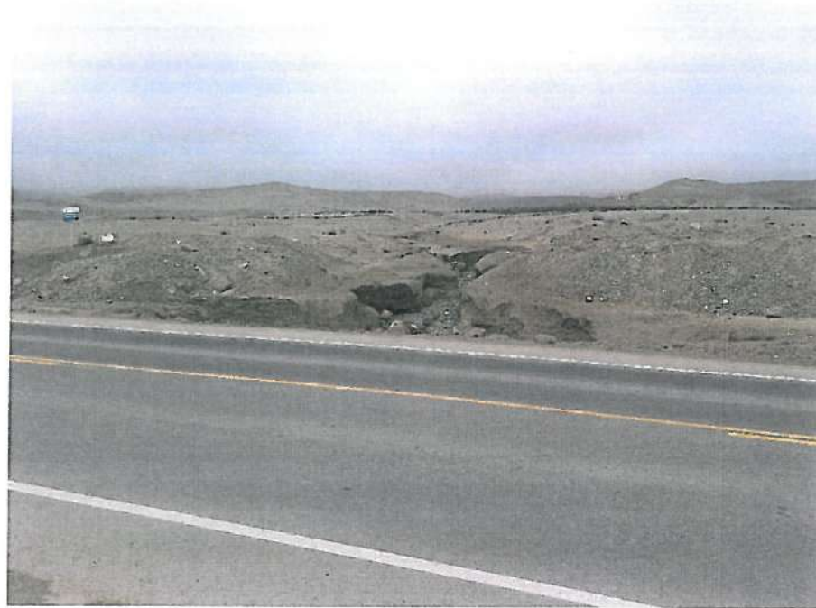
Figura 98: vista aguas arriba.
