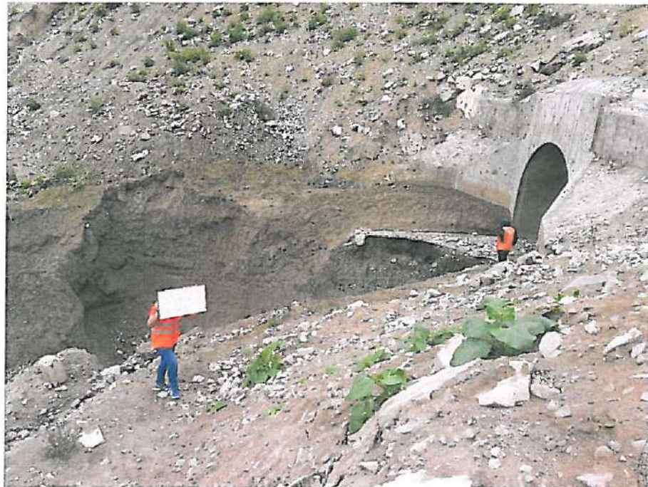
Figura 69: Sistema de drenaje con daños en la sub base.
