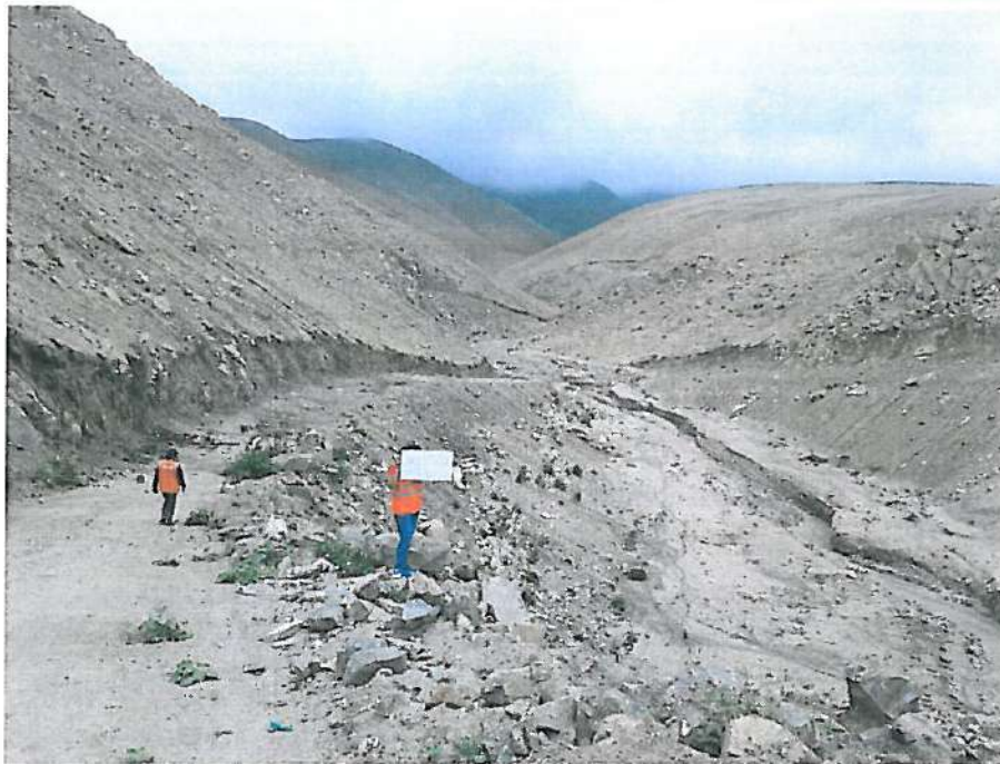
Figura 63: Quebrada N° 8, vista aguas arriba.
