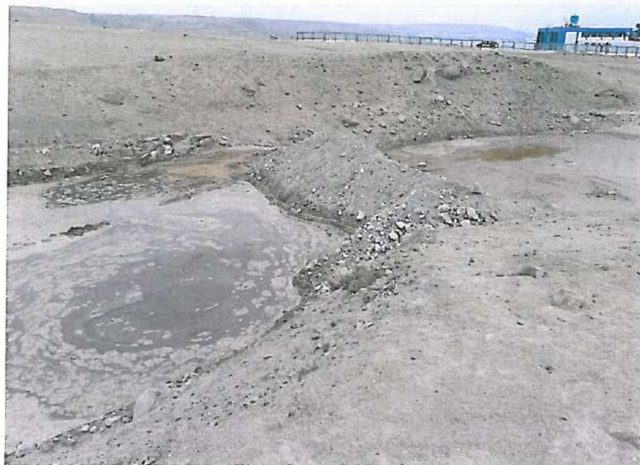
Figura 121: Flujos de lodo en la quebrada Zaparo.
