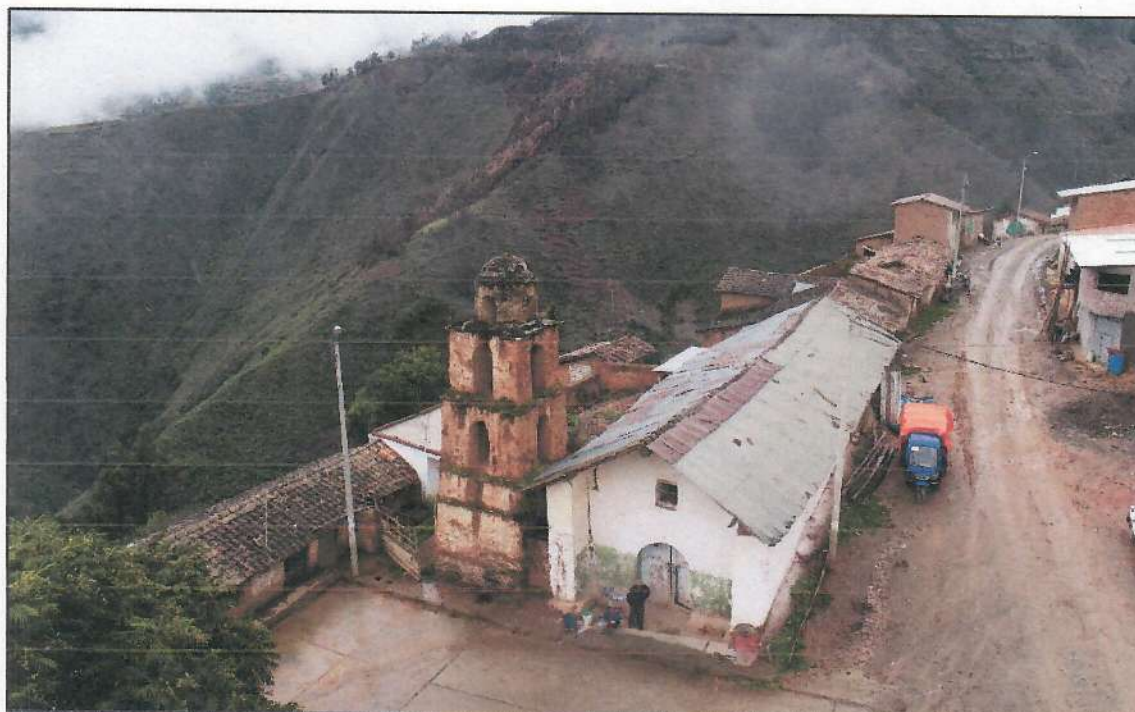
Imagen 04: Fotografía de Iglesia afectado por los Flujos de Detritos ocurrido en Temporadas de Lluvias ocurrida años anteriores. (CP. Carampa-Pazos-Tayacaja-Huancavelica). Fuente: Equipo Técnico GRD.
