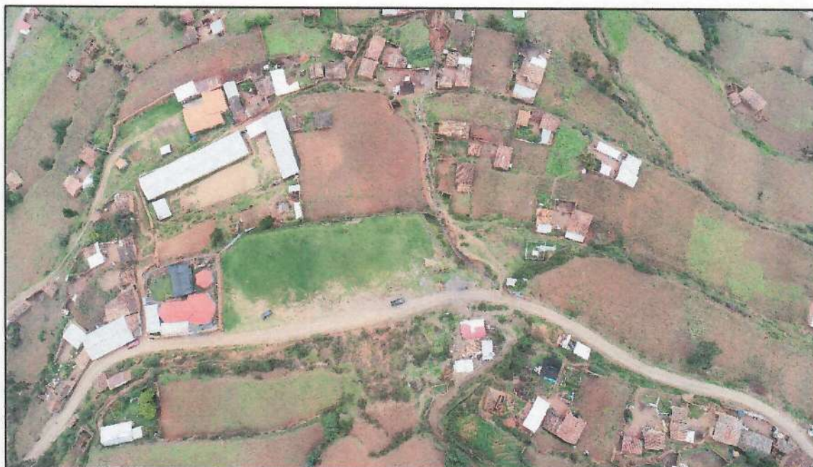
Imagen 07: Fotografía aérea Drone, Vista del Canal Provisional construido por los Pobladores para reducir el Riesgo. (CP. Carampa-Pazos-Tayacaja-Huancavelica). Fuente: Equipo Técnico GRD.
