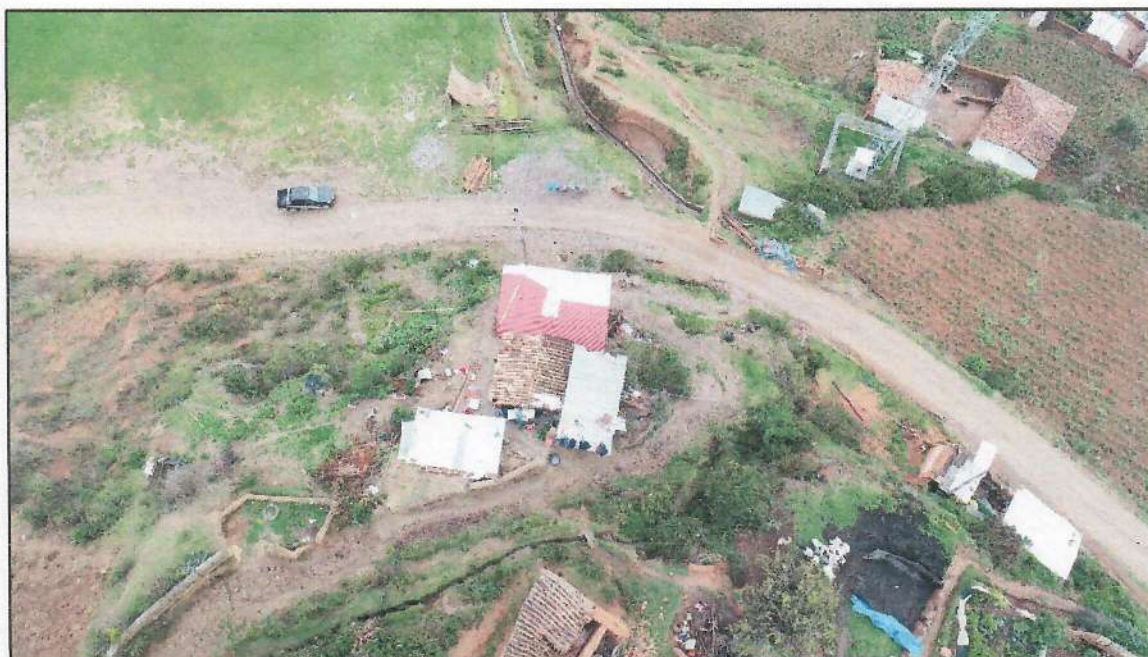
Imagen 09: Fotografía aérea Drone, Vista del Canal del Riachuelo con presencia de Material proveniente del socavamiento y depositado en zonas con pendientes bajas y que pone en Riesgo alto para las casas que se ubican cercanas al canal del Riachuelo. (CP. Carampa-Pazos-Tayacaja-Huancavelica). Fuente: Equipo Técnico GRD.
