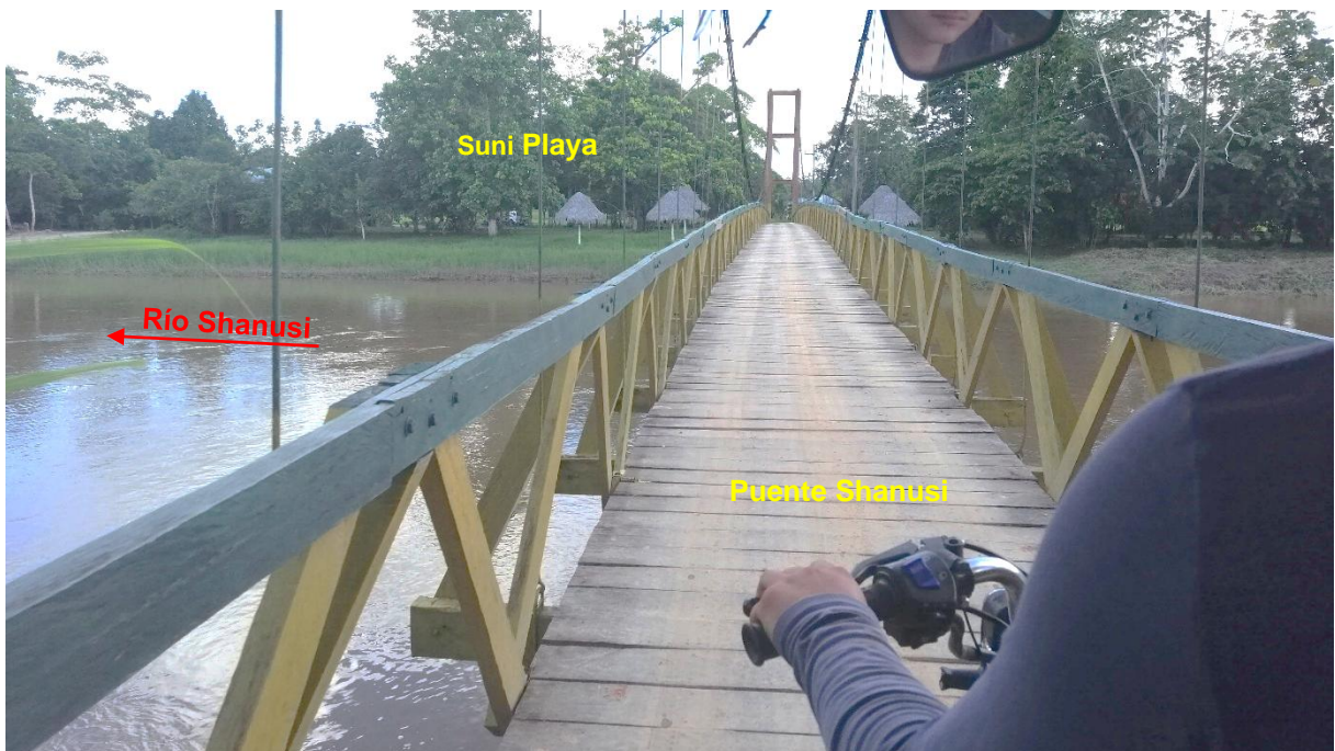
Figura 3: Puente Shanusi que conduce al caserío Suni Playa.
