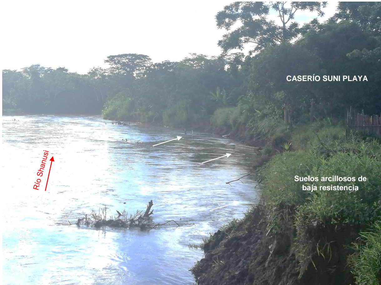
Figura 11: Vista hacia aguas abajo del río Shanusi del efecto erosivo sobre la ribera derecha, la cual está conformada por suelos arcillosos de baja resistencia.
