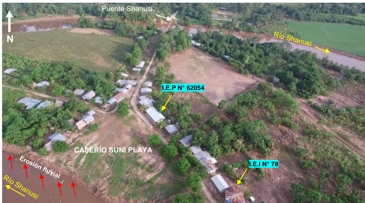
Figura 8: Vista general del caserío Suni Playa. Se observa erosión en el extremo sur del caserío, las ubicaciones de la I.E.P N° 62054 e I.E.I N°78. Fuente: Modificado de Radio Oriente, 2017.
