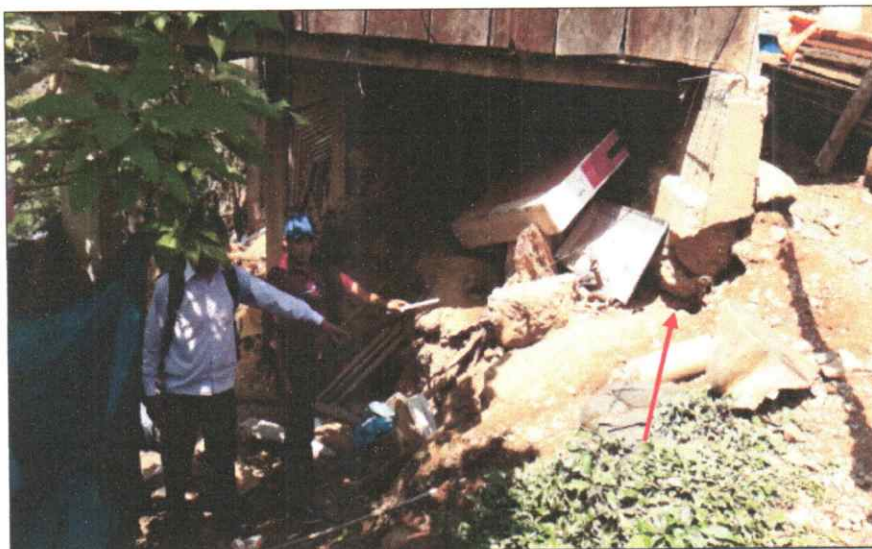
Imagen N° 3.4: Se observa en algunas viviendas, escarpa principal 70 m. y salto vertical es 2 m aproximadamente.
