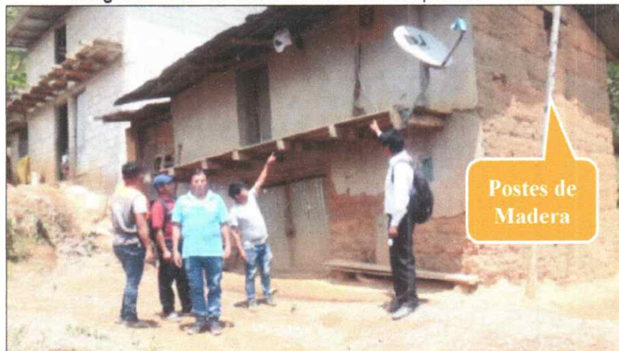
Imagen N° 2.10: Instalaciones eléctricas con postes de madera
