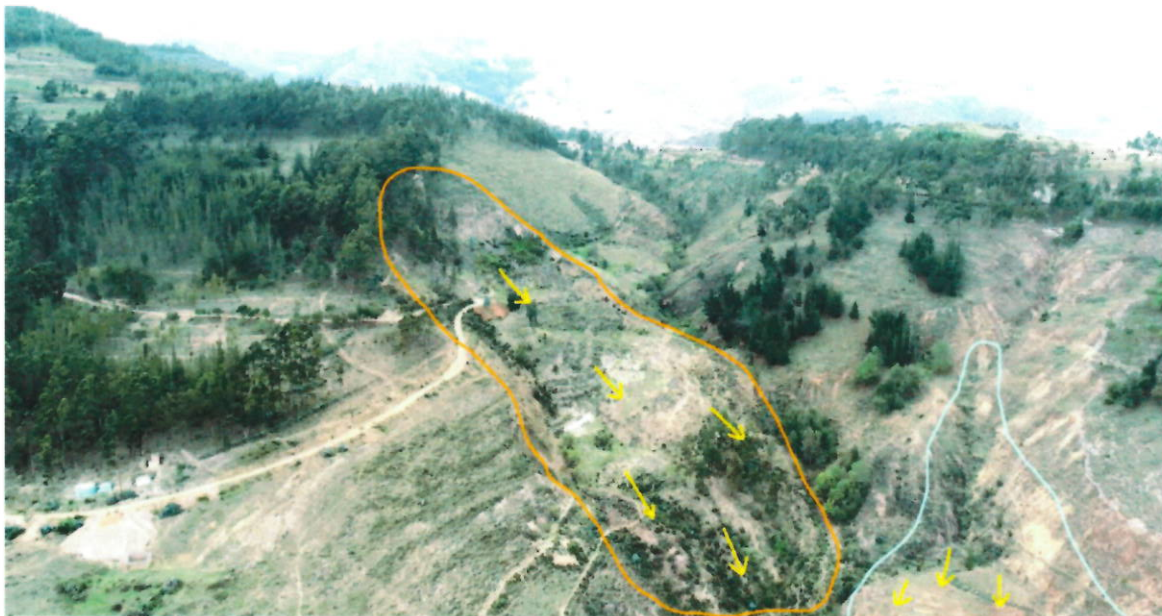
Fotografía 4. Zona alta del sector Calispuquio, lugar de alta susceptibilidad a movimientos en masa, como deslizamientos rotacionales (línea anaranjada) y flujos (línea celeste); las flechas amarillas muestran la dirección del movimiento.
