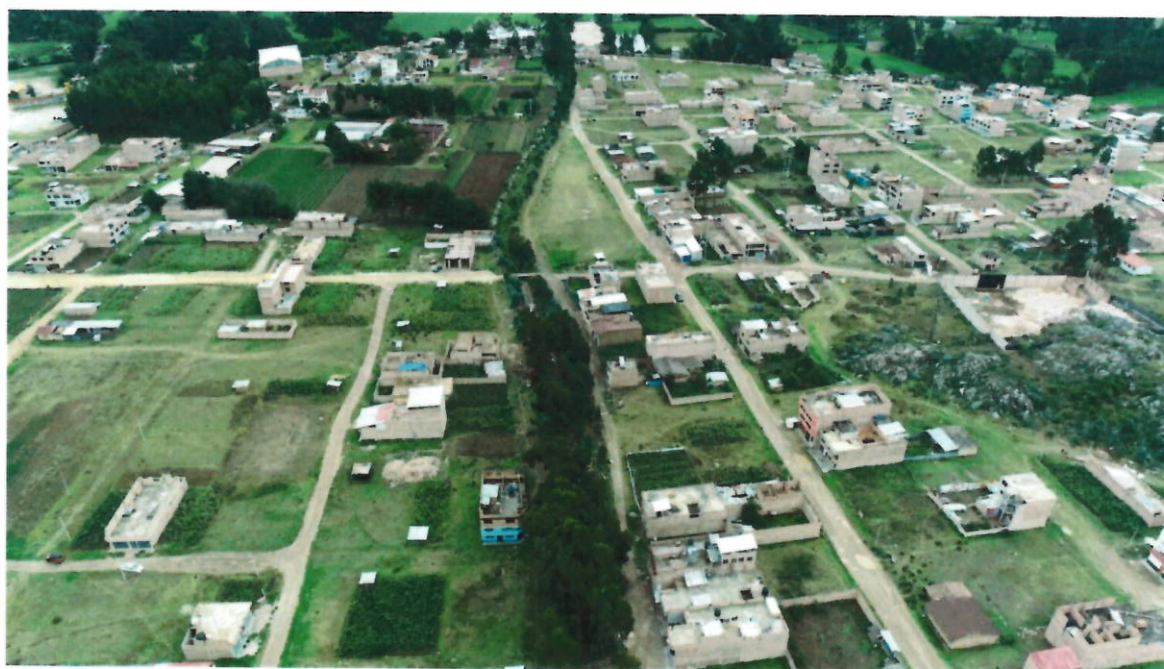
Fotografía 7. Vista desde un dron de la quebrada Los Chilcos en la Urbanización 2010.
