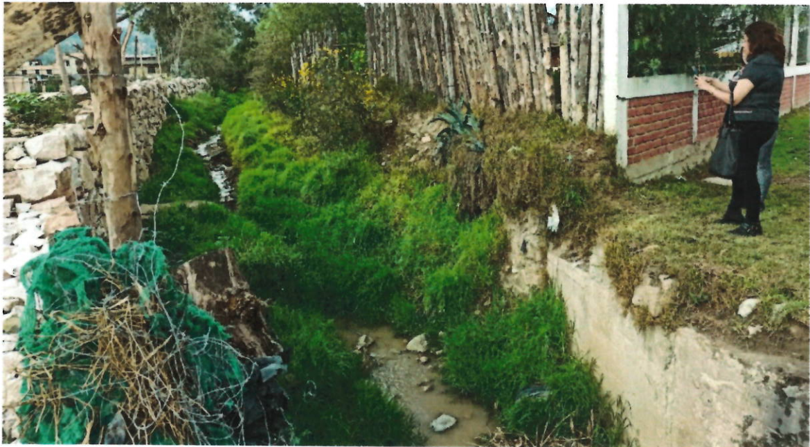
Fotografía 8. Punto de inspección N° 4, cruce con la vía 3N.
