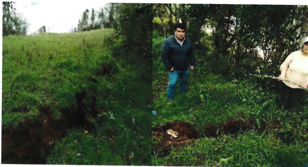
Fotografía 5. Agrietamiento del terreno, vista tomada en un lado lateral y al pie de la ladera, originando un asentamiento de la carretera.
