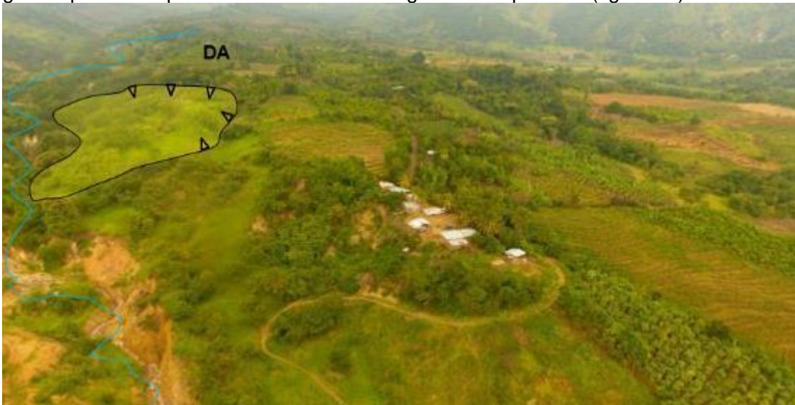
Figura 18. Vista de oeste a este de deslizamiento antiguo ocurrido al norte del área urbana de La Laguna.
