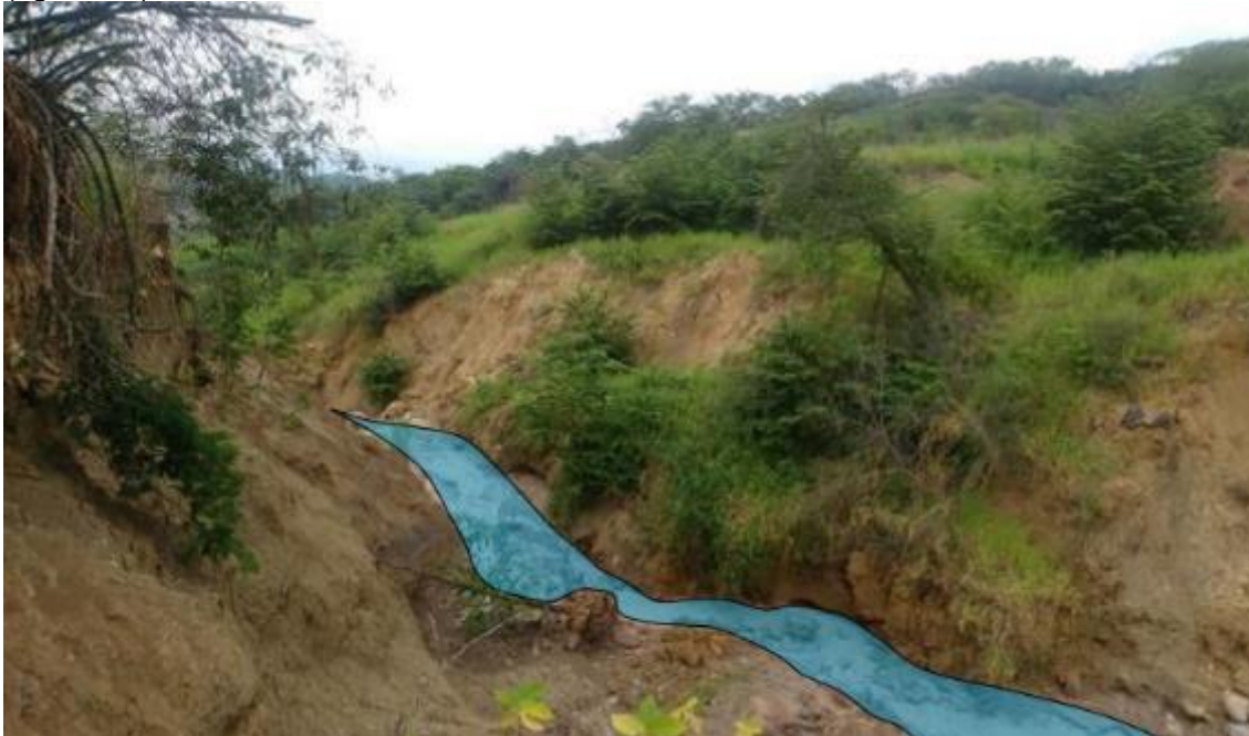
Figura 23. Vista de sur a norte del pie del deslizamiento en la quebrada Agua Sucia.
