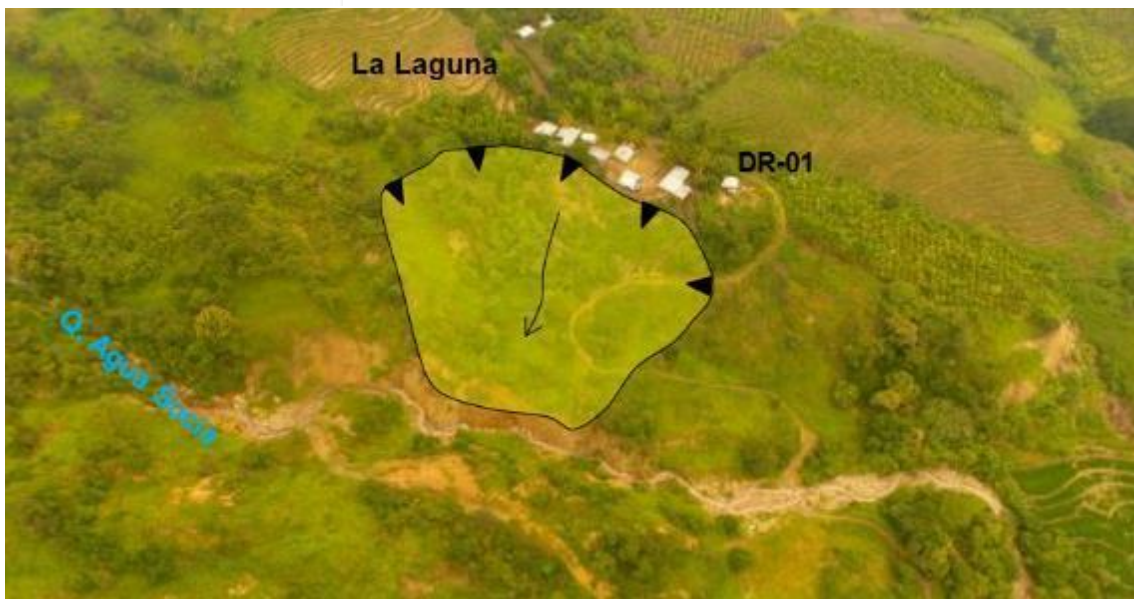
Figura 19. Deslizamiento que afecta a varias viviendas en el caserío La Laguna.
