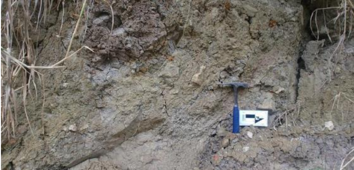
Figura 05. Corte de talud natural presente en el escarpe principal del deslizamiento, se observan depósitos cuaternarios.
