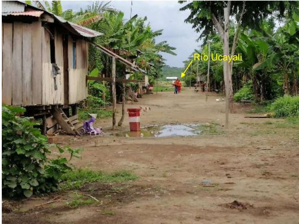
Figura 44: Viviendas expuestas ante inundación y erosión fluvial.
