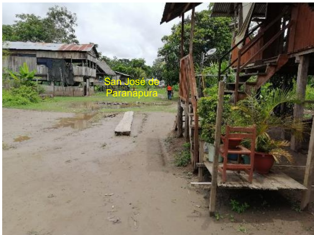
Figura 31: Viviendas con pisos elevados ante inundaciones.
