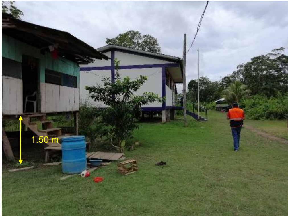
Figura 32: Altura de vivienda de 1.50 m, ante inundaciones.
