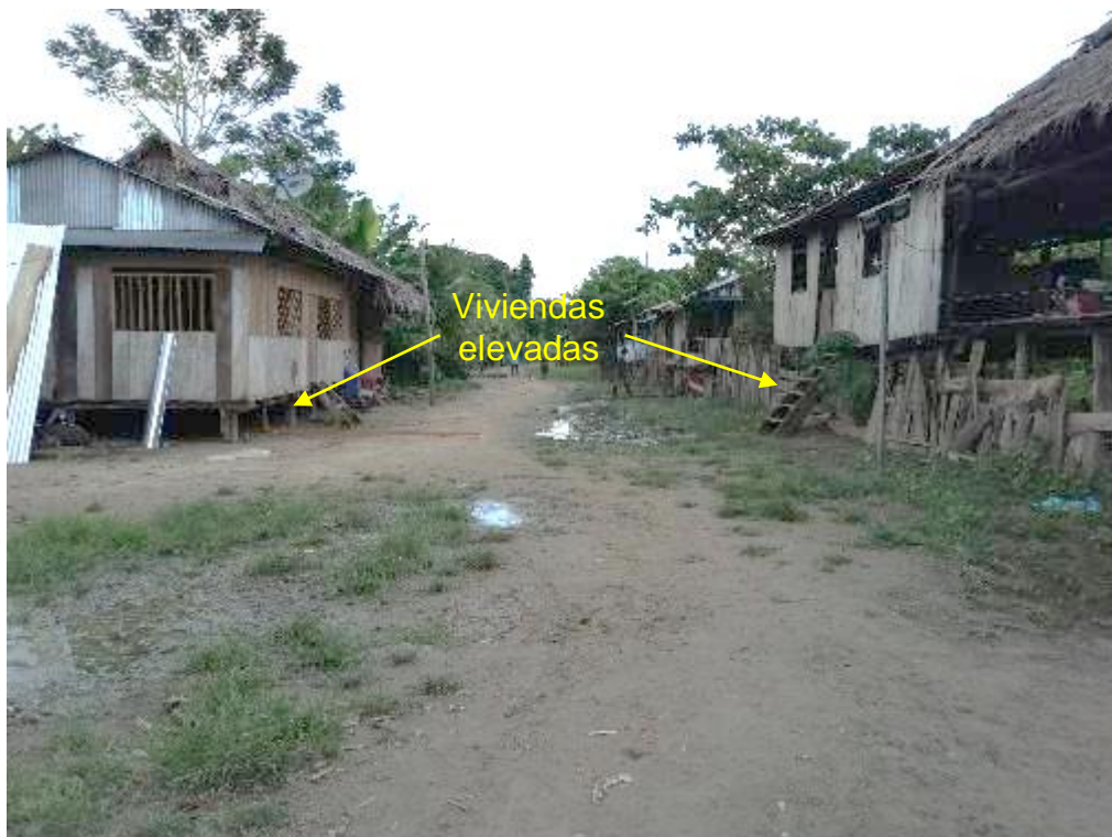
Figura 43: Viviendas con pisos elevados como medida de mitigación ante inundaciones.
