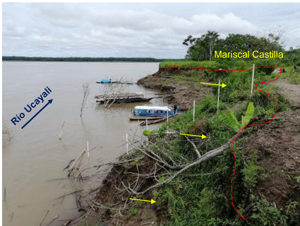
Figura 13: Vista del puerto de acceso a la localidad de Mariscal Castilla. Presenta erosión fluvial.
