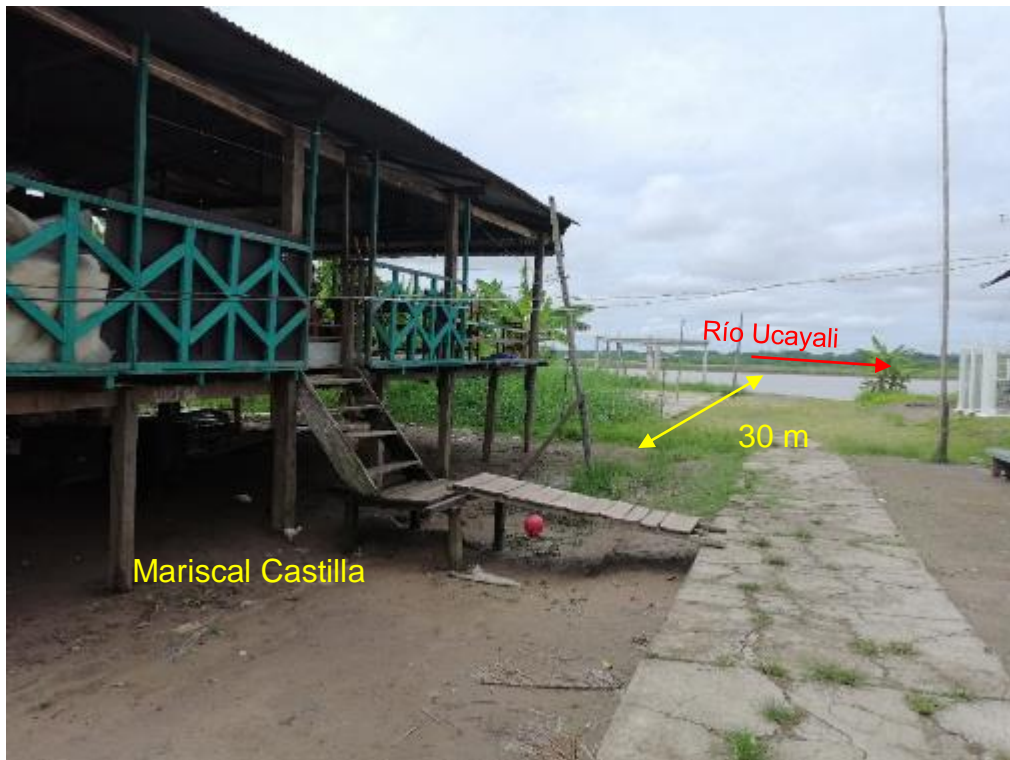
Figura 17: Viviendas ubicadas a 30 m de zona erosiva.
