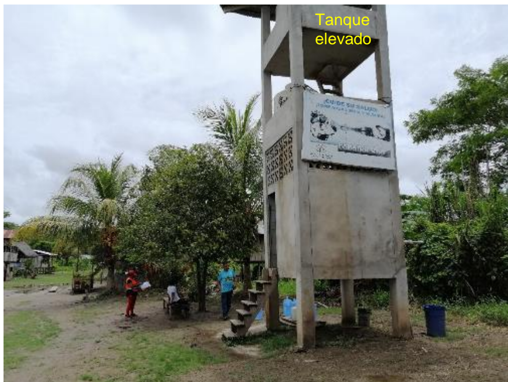
Figura 29: Planta potabilizadora de agua del sector San José de Parapapura.
