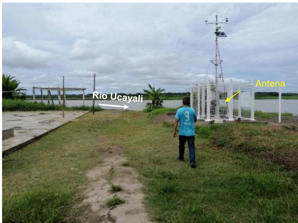
Figura 15: Antena de telecomunicaciones ubicada a 10 m de la zona ribereña. Zona de peligro alto ante erosión fluvial.
