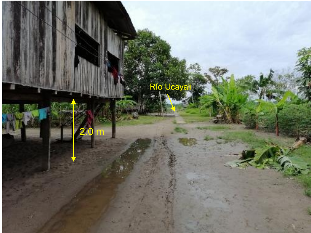
Figura 18: Viviendas elevadas 2.0 m sobre el nivel del terreno, como medida preventiva ante inundaciones.
