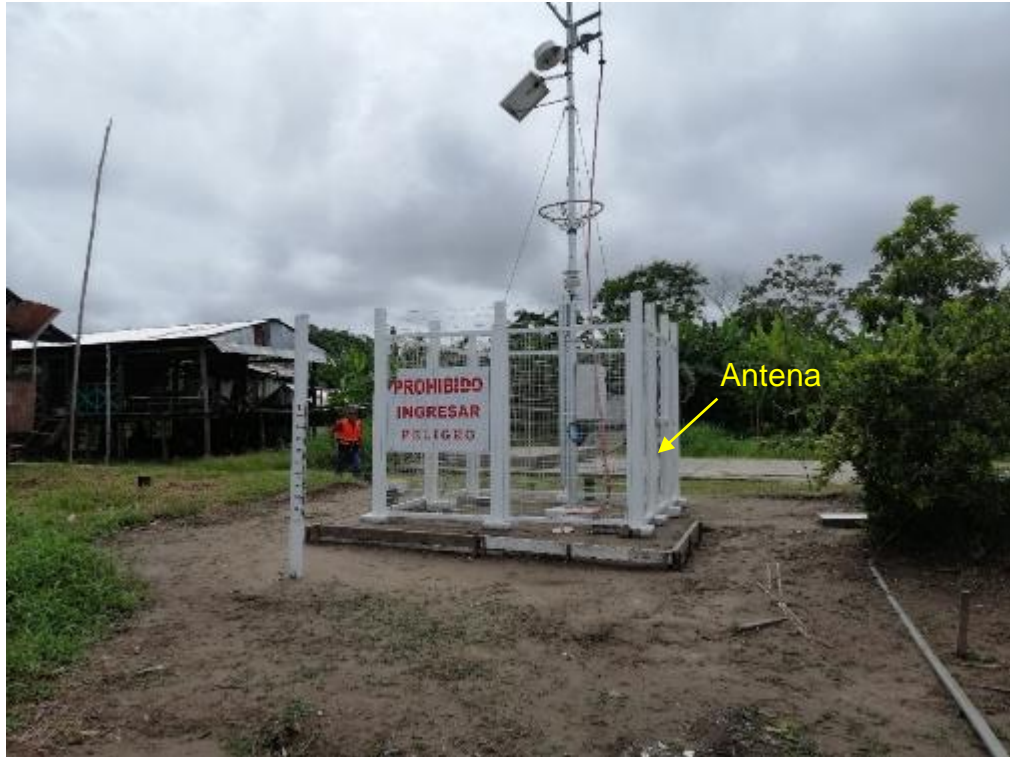
Figura 16: Antena de telecomunicaciones ubicada a 10 m de la zona ribereña.
