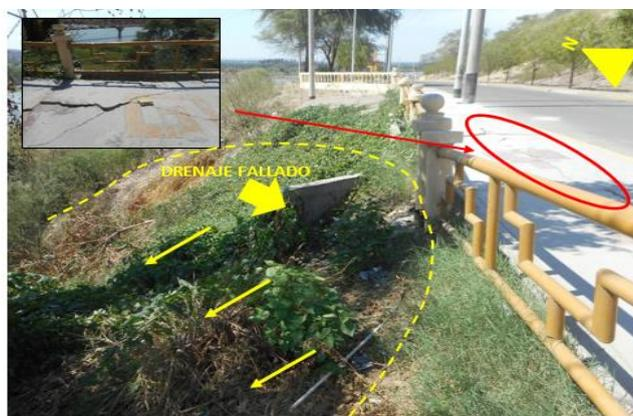
Figura 40: Aceras en las inmediaciones del malecón Turicarami deterioradas (elipse roja), debido a que los suelos han sido saturados y erosionados por las aguas de escorrentía que han sido originadas durante el periodo de lluvias y transportados por sistema de drenaje deficiente.
