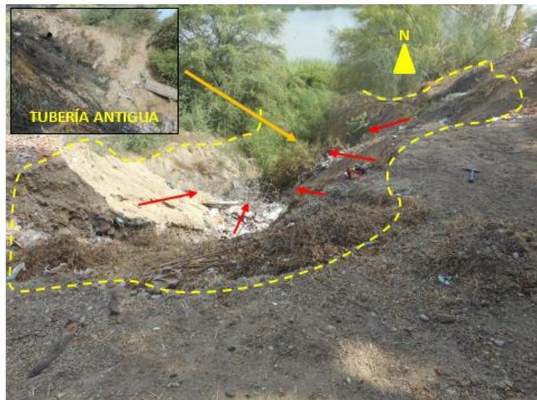
Figura 42: Zona inestable (línea amarilla) en la parte oeste de la plaza Bolognesi, posiblemente desestabilizada por aguas de escorrentía que han sido transportados por tubería antigua (parte baja de ladera).
