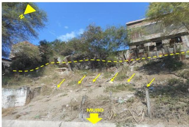
Figura 39: Acantilado susceptible a la ocurrencia de derrumbes, debido a la pendiente que presenta y el tipo de materiales que lo conforman, a pesar de contar con un muro de contención en el pie de la ladera.
