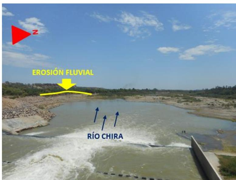
Figura 38: Erosión fluvial en el margen izquierdo del río Chira (parte baja de presa reguladora), durante los meses de lluvia (diciembre – abril).
