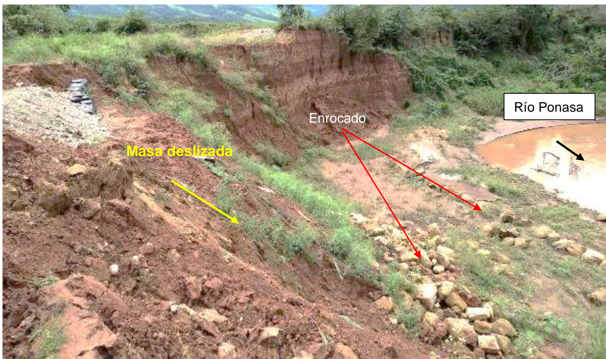
Figura 16: Vista de la zona media y baja del deslizamiento rotacional de suelos, fecha 25 de setiembre del 2019.
