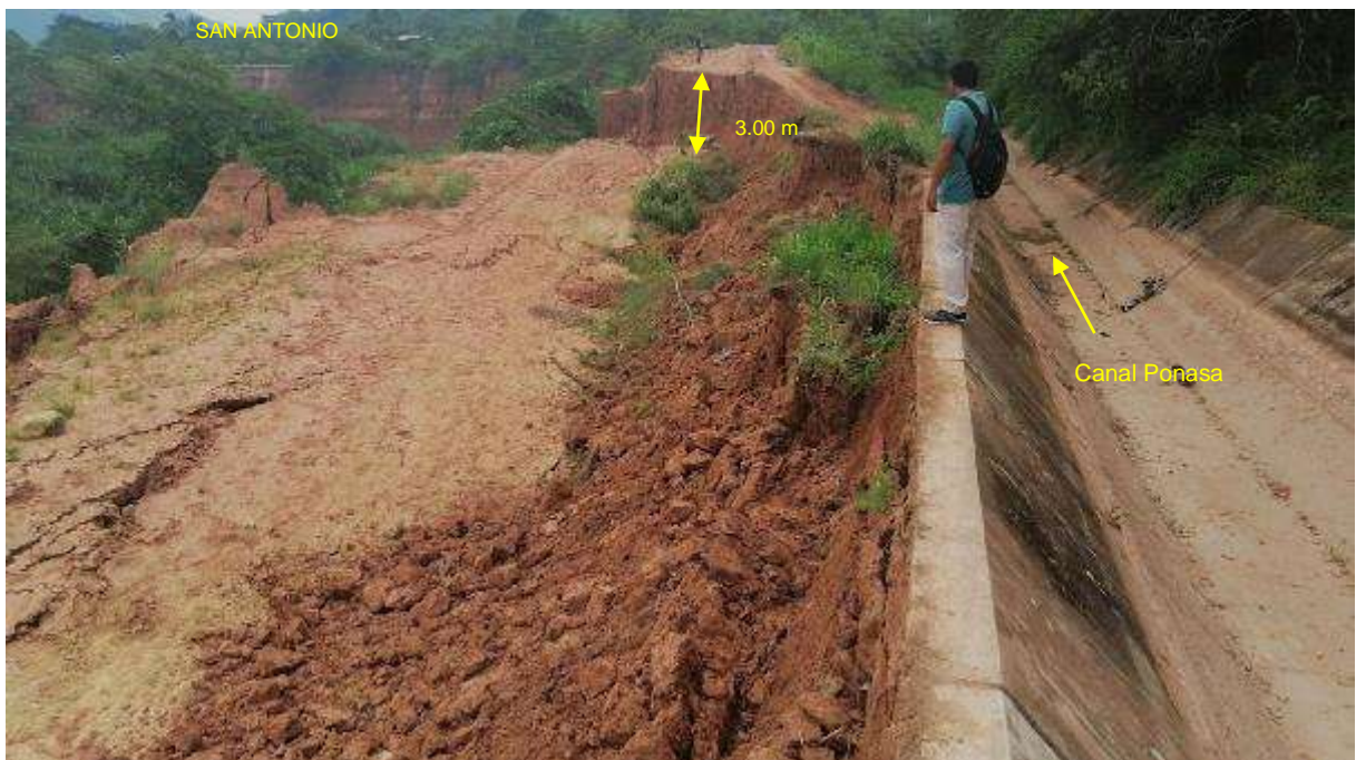
Figura 18: Escarpa principal del deslizamiento, fecha 13 de febrero del 2020.
