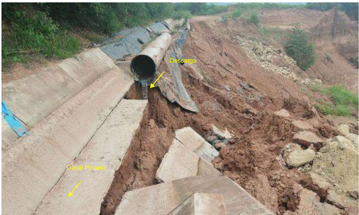
Figura 20: Descarga de agua del canal Ponasa hacia el cuerpo del deslizamiento, condición desfavorable para la estabilidad.
