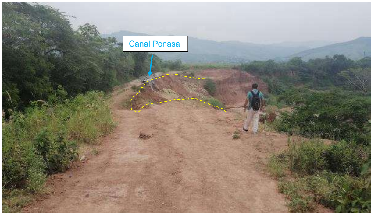
Figura 17: Vista del deslizamiento rotacional de suelos, fecha 13 de febrero del 2020.
