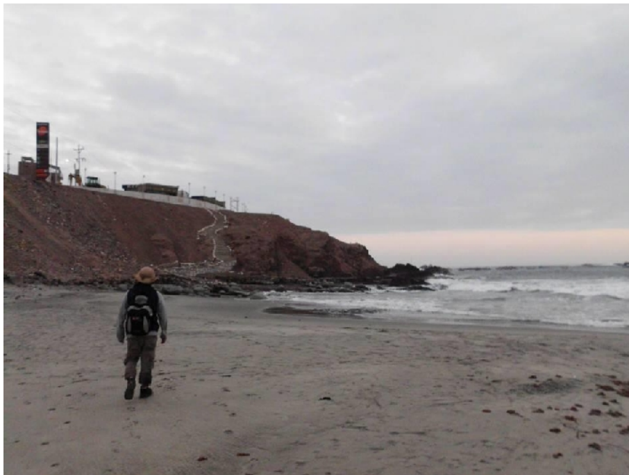
Figura 36: Caída de rocas que afectan el sector sur de la ciudad de Chala. Sobre este acantilado se encuentra el Hotel de Turistas.
