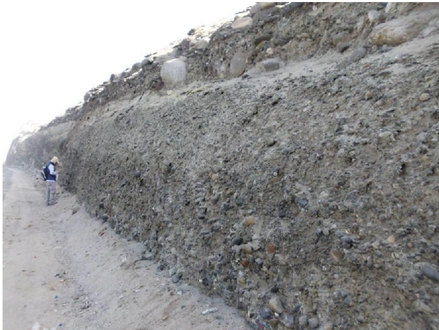
Figura 29: Terraza aluvional ubicada en la Panamericana Sur, sector Aguadita. Sobre estos materiales se asientan viviendas.
