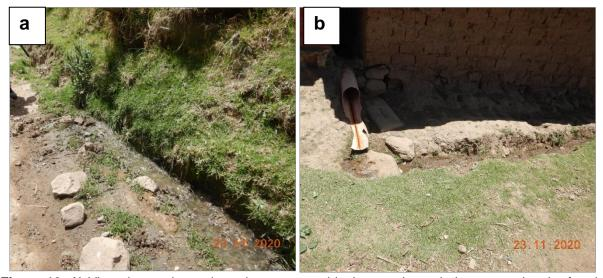
**Figura 12**. A) Vista de canal que drena las aguas residuales, producto de la ruptura de tuberías de desagüe, con coordenadas UTM (WGS 84): 817169 E, 8498303 N a 3610 m s.n.m. B) Tuberías de desagüe en pésimas condiciones, aguas vertidas sobre el terreno.
