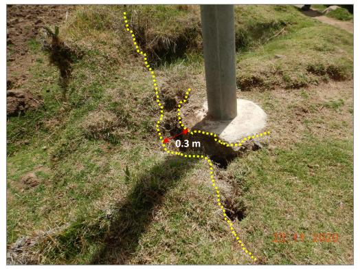
**Figura 10**. Poste eléctrico afectado debido al asentamiento del terreno, con coordenadas UTM (WGS 84): 817212 E, 8498285 N a 3619 m s.n.m.
