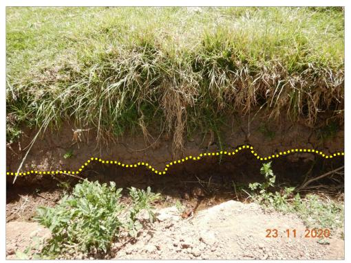
**Figura 11**. Vista del nivel de filtración de agua, debido al sistema de riego, con coordenadas (WGS 84): 817144 E, 8498265 N a 3611 m s.n.m.
