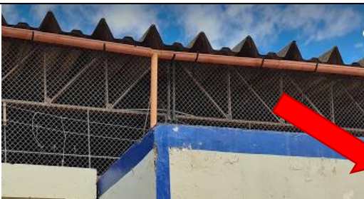
FOTO N° 08. EN ESTA FOTO SE OBSERVA QUE EN LA PARTE CONSTRUIDA DEL MERCADO DE ABASTOS SI PRESENTA LA EVACUACIÓN DE AGUA PLUVIALES
