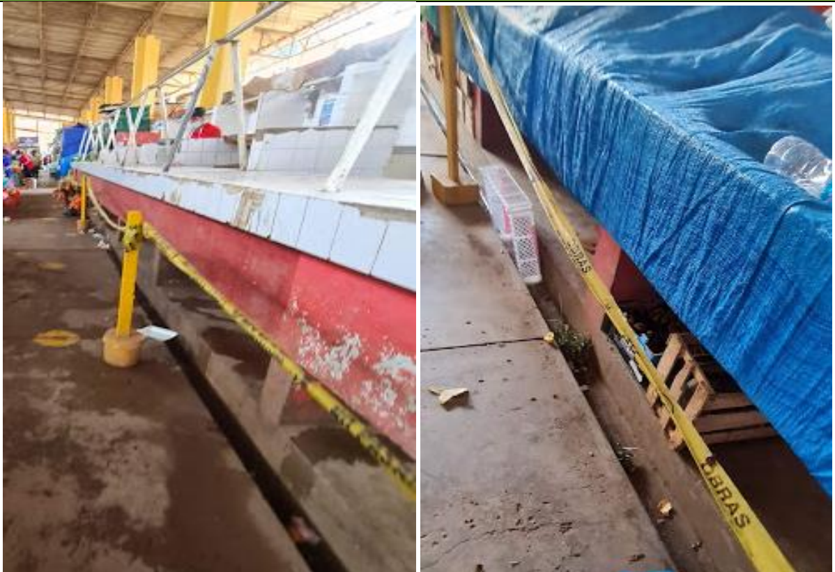
FOTO N° 06. FALTA DE LIMPIEZA DEL SISTEMA DE DRENAJE EN EL INTERIOR DEL MERCADO
