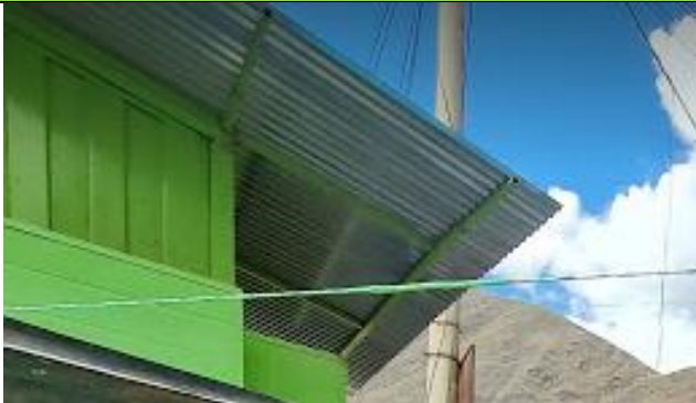
FOTO N° 07. LA COBERTURA DE LOS PUESTOS DE VENTA A LOS EXTERIORES ACTUALMENTE NO CUENTAN CON UN BUEN SISTEMA DE EVACUACIÓN DE AGUAS PLUVIALES
