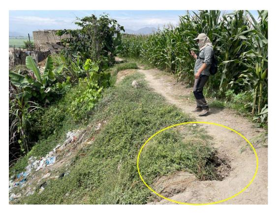
Figura 13. Zona de ladera sometida a proceso erosivo, con incidencia de hundimiento del suelo (círculo amarillo).
