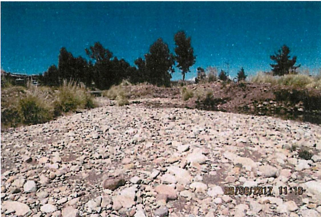
Se aprecia la colmatación y erosión de la margen izquierda del cauce del río Conima.
