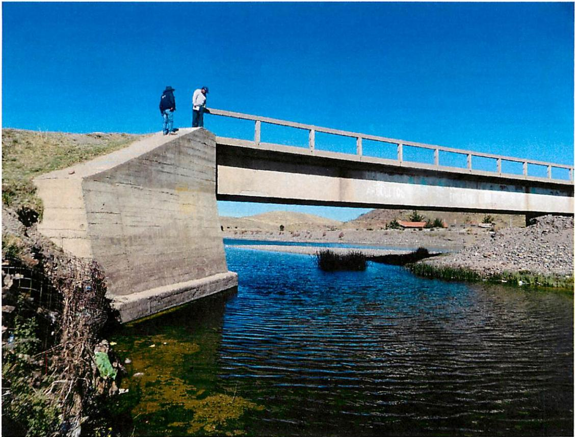
Se aprecia la necesidad de dique enrocado en el puente Cabanillas, en la margen izquierda del cauce del río Cabanillas
