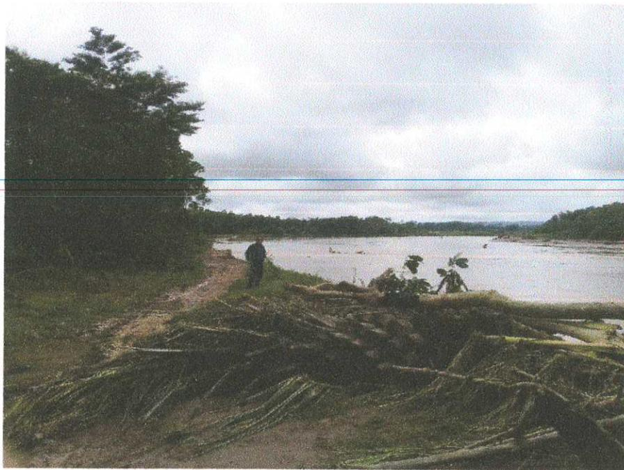
Fotografía N° 02. Carretera erosionada por la corriente del río Shanusi.
