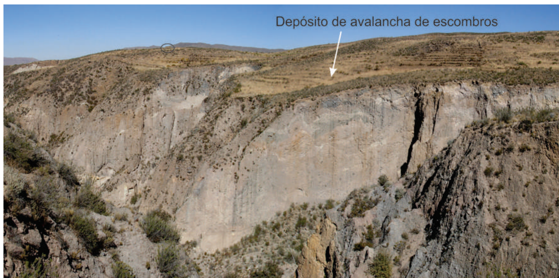
Figura 3.23 Depósito de avalancha de escombros, de facies matriz y bloques soportados, de más de 60 m de espesor que se observa en la zona de Pampa Pajonal-Santa Cruz.
