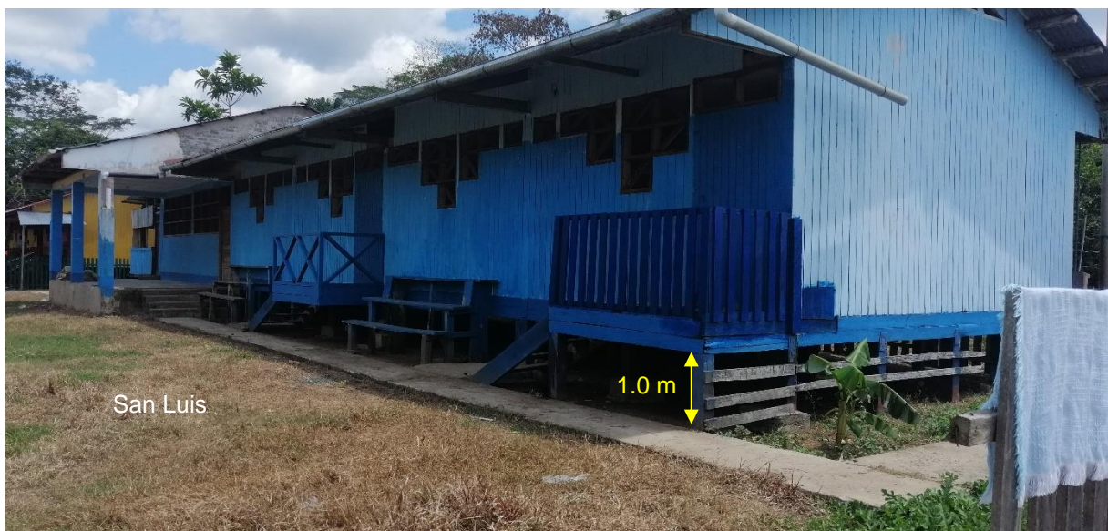
Figura 16: Institución educativa sobre columnas de 1.0 m se altura sobre el terreno natural.
