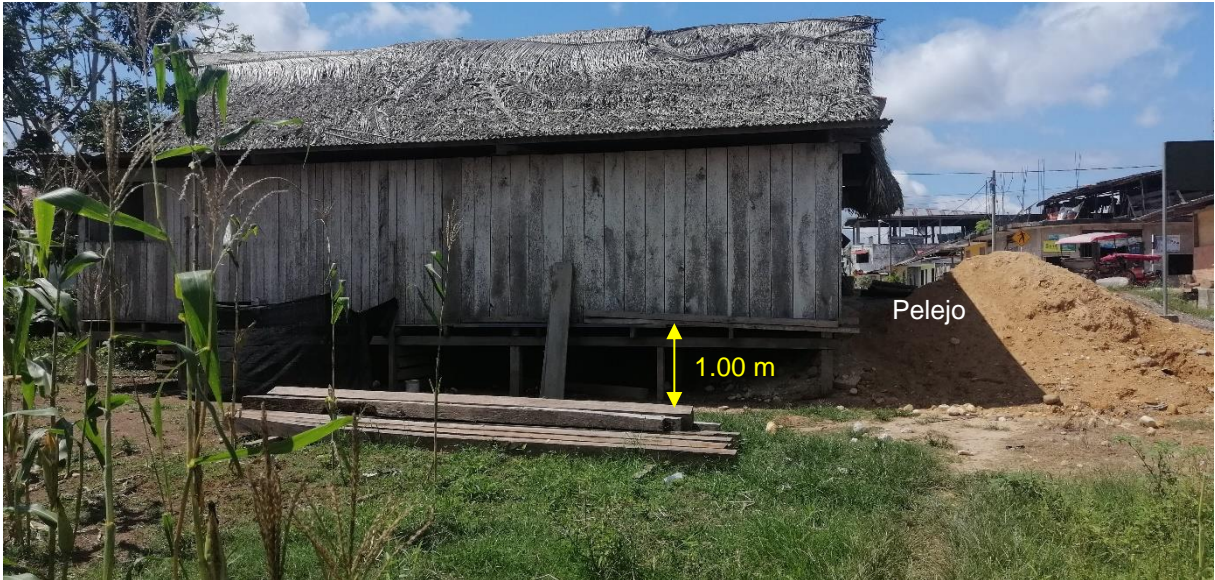
Figura 12: Viviendas ubicadas cercanas al borde del río Huallaga, se construyen sobre estructuras de 1.00 m sobre del nivel del terreno, evidencia una medida de convivencia con el peligro y de recurrencia periódica del mismo.
