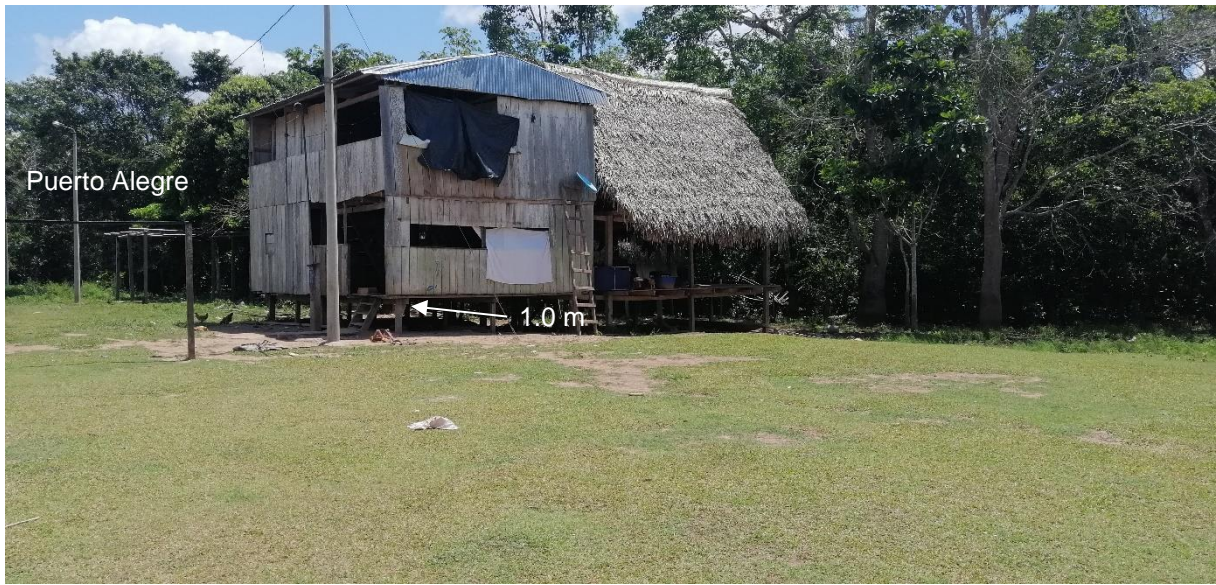
Figura 18: Vivienda con columnas de madera que sobresalen 1.0 m del terreno natural.
