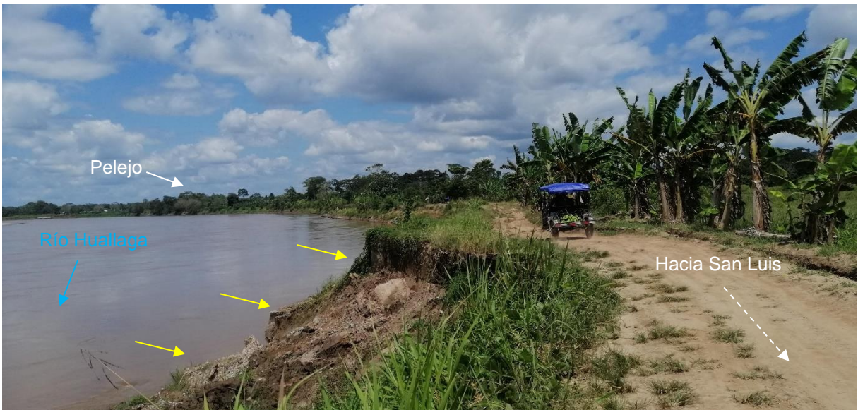
Figura 13: Erosión fluvial por socavación de la ribera izquierda del río Huallaga, en el extremo suroeste del casco urbano de Pelejo. Evento que afecta la vía afirmada que conduce a la localidad de San Luis.
