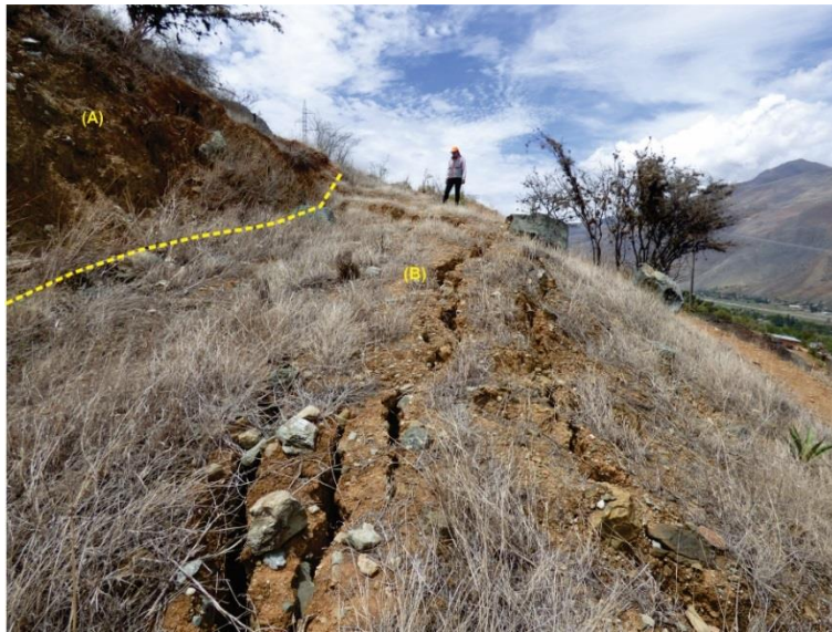
Foto 4. Escarpe secundario (A) y agrietamientos recientes en la superficie del terreno (B).
