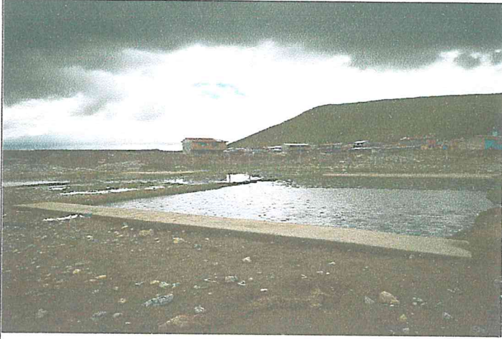
Fotografía 1: Desborde del río San Juan en el sector de Huaraucaca, afectando el PTAR Brocal.
