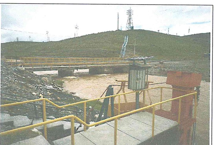
Fotografía 4: Río San Juan en el sector de Huaraucaca, causando erosión
