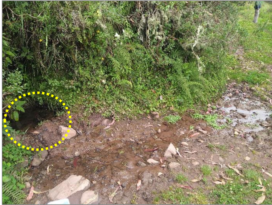
Figura 8. Surgencias de agua cerca de la margen derecha de la quebrada Soito Puquio.
