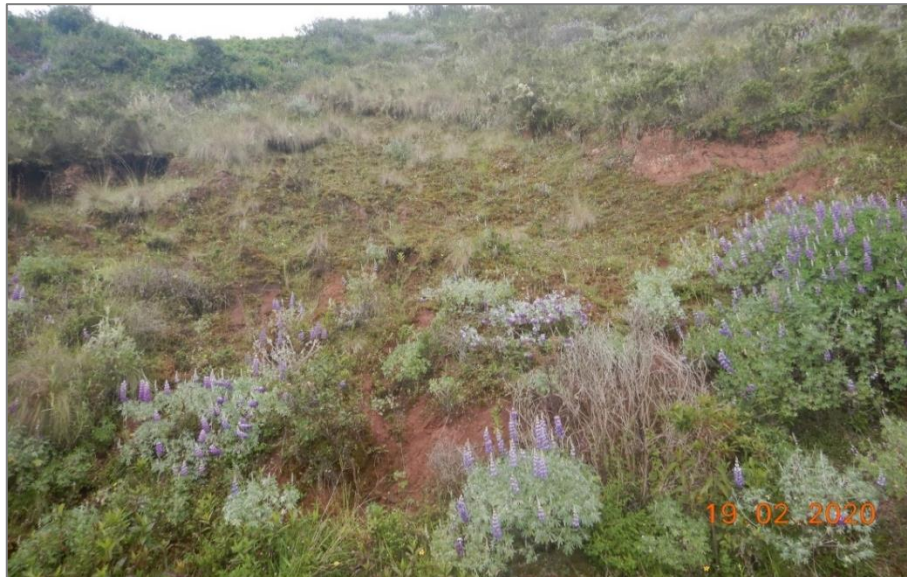
Fotografía 5. Vista en la parte alta a la margen derecha de la Qda. Hiervabuenahuayco, donde se originó el deslizamiento del año 2003.
