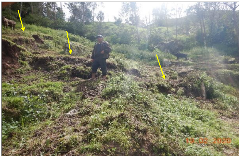
Figura 14. Se observa asentamiento del terreno en el cuerpo del deslizamiento.
