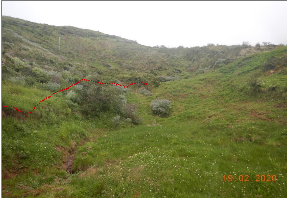
Figura 13. Vista de escarpe de deslizamiento antiguo y escarpe de deslizamiento reactivado representado por líneas rojas.
