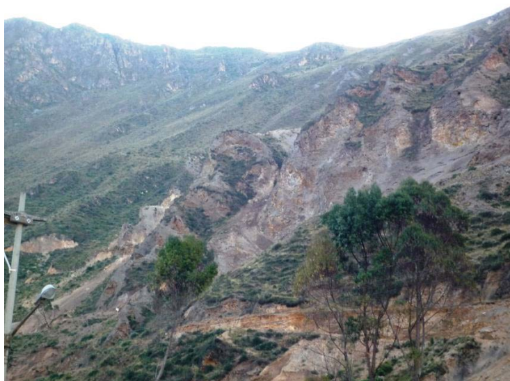
Foto 3 Deslizamiento en la Localidad de Culhuay en el distrito de Huaros-Canta
