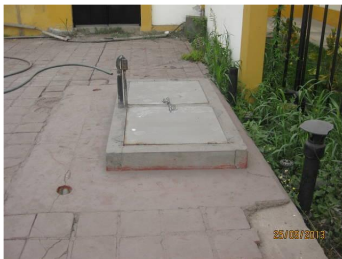
Foto 4 Cisterna principal sin conexión flexible de las líneas de agua.
