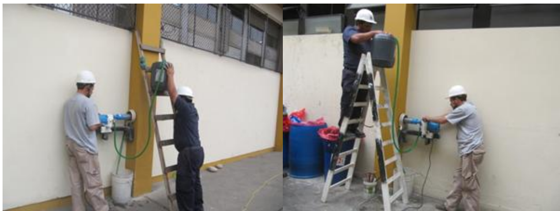
Figura AIII-4. Extracción de núcleos de concreto.
