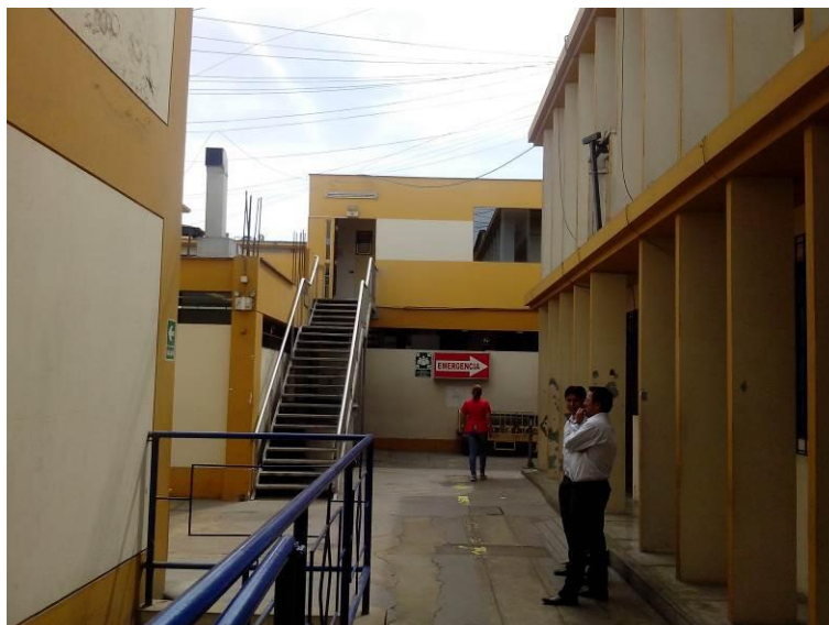
Foto 17. Escalera de acceso a la oficina del Comité Hospitalario de Defensa Civil (COE)
