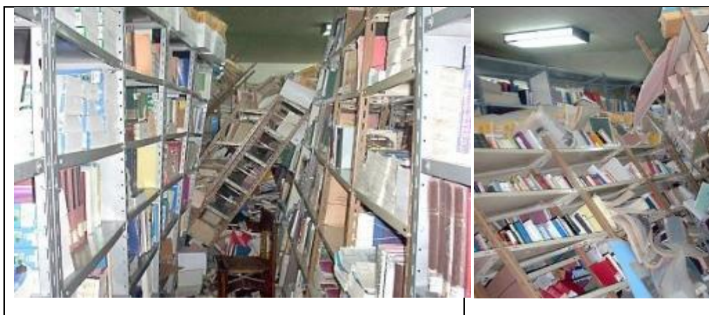
Fig.4.6 Caída y volcamientos de estanterías que no están adecuadamente sujetos.
