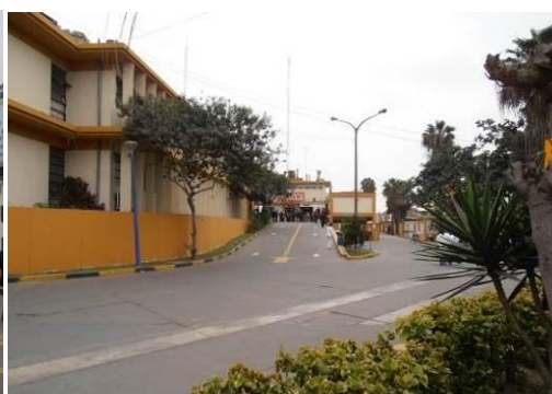
Foto 4. Rampa de acceso vehicular al servicio de Emergencia
