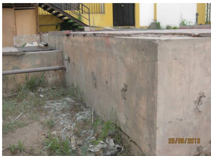
Foto 4 Cisterna principal sin conexión flexible de las líneas de agua.
