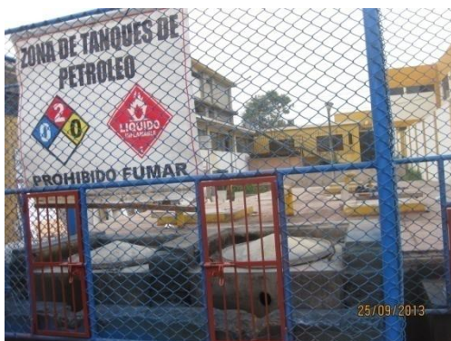
Foto 14. Ubicación de tanques de Combustible soterrado.
