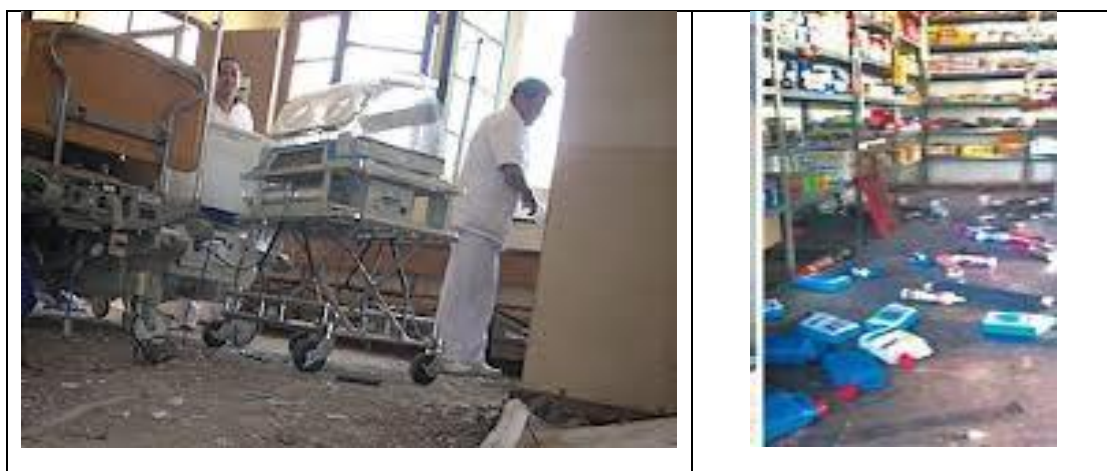
Fig. 4.5 Desplazamiento de equipos que pueden ocasionar la inoperatividad de los mismos.
