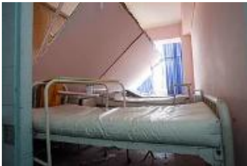
Fig. 4.1 Tabiques no asegurados adecuadamente, corren el riesgo de deformaciones o caídas ante eventos adversos.
