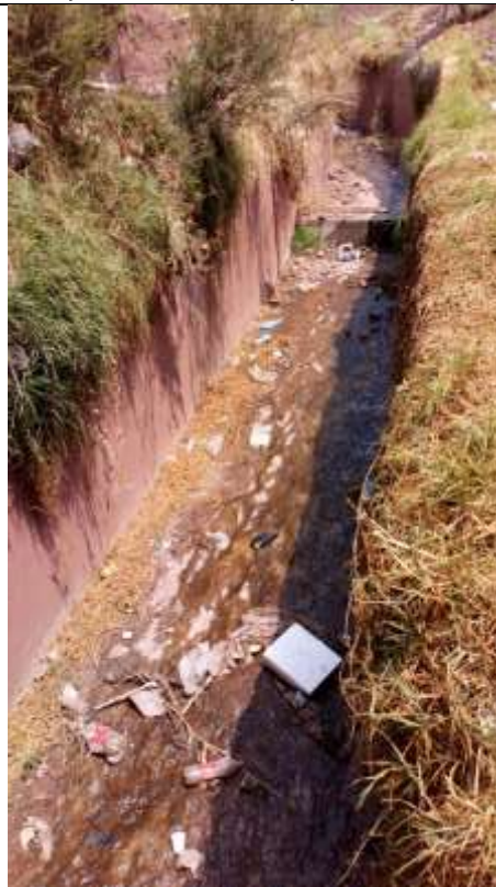
Fotografía 06: Vista aguas arriba del canal de la quebrada Picchu
