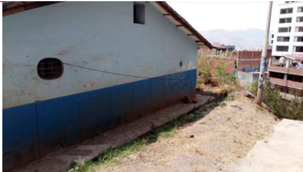
Fotografía 04: Se evidencia la precariedad de servicios, en la toma se observa la conexión insegura de fluido eléctrico.
