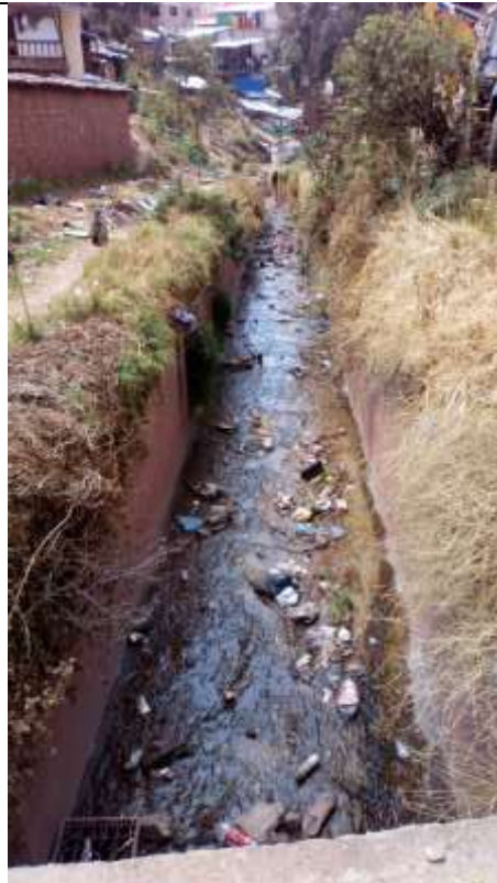
Fotografía 05: Vista aguas abajo del canal de la quebrada Picchu
