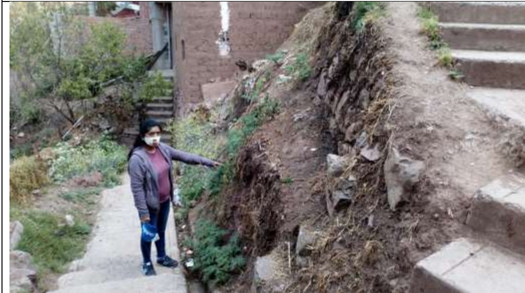
Fotografía 02: Se muestra la presencia de suelo de relleno en el talud
